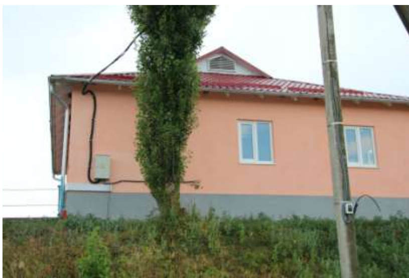
Figura 7. Clădirea stației de dirijare
