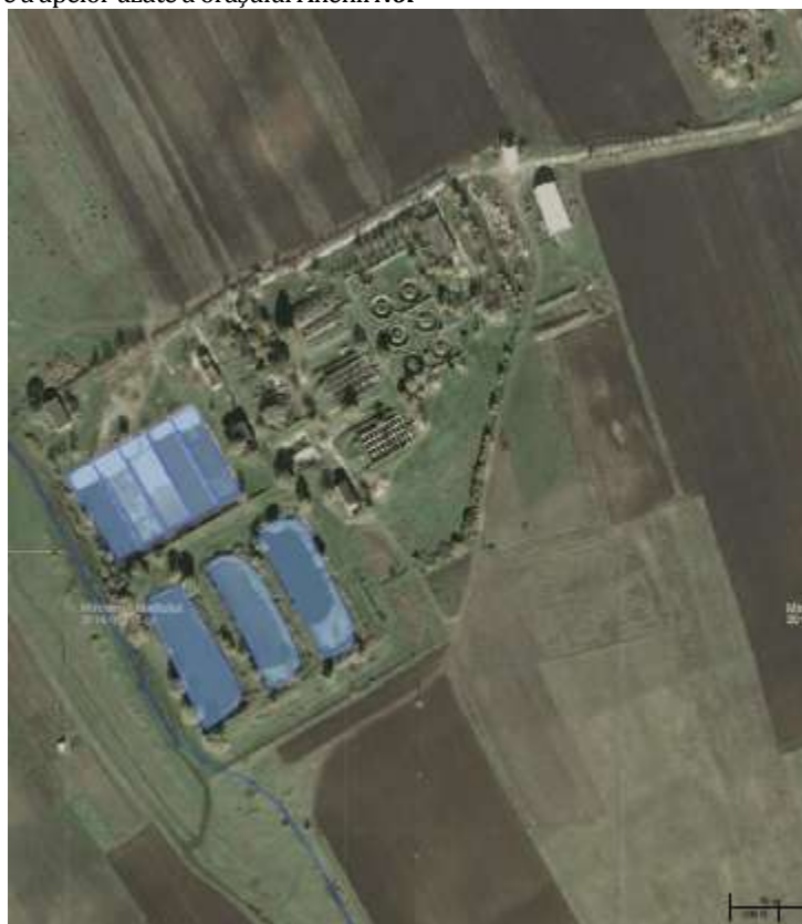
Figura 6. Stația de epurare a apelor uzate a orașului Anenii Noi
