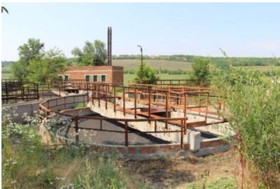
Figura 8. Starea fizică a decantoarelor primare
