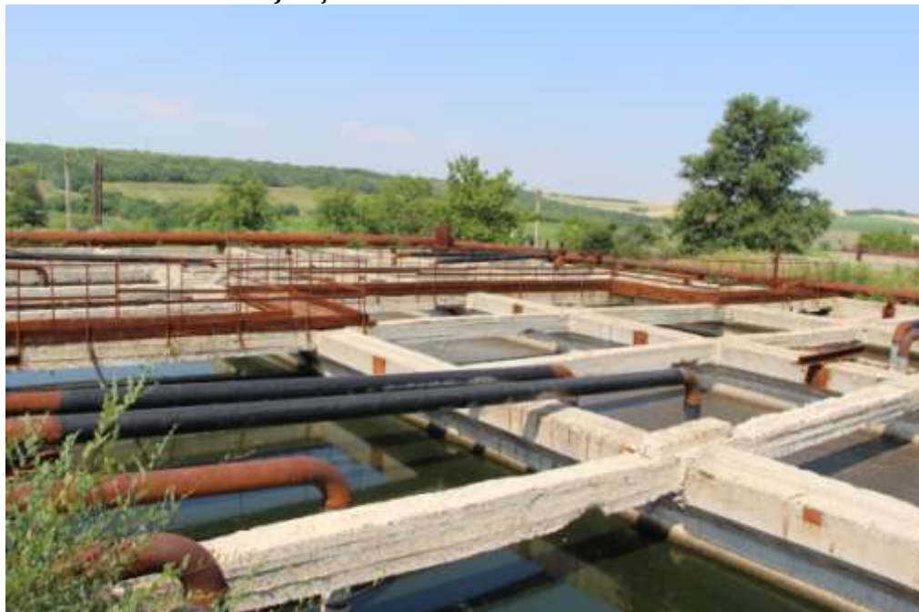
Figura 9. Bazinele de aerare care nu funcționează mai mult de 10 ani
