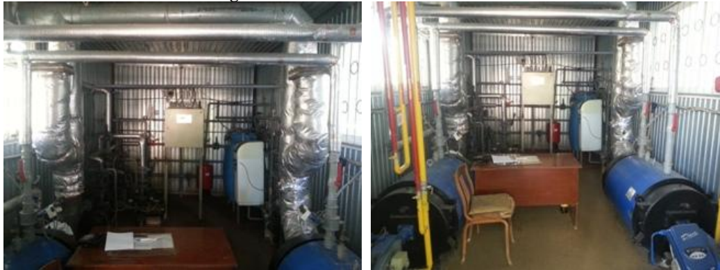
Figura 3. Interiorul centralelor din Orasul Floresti
