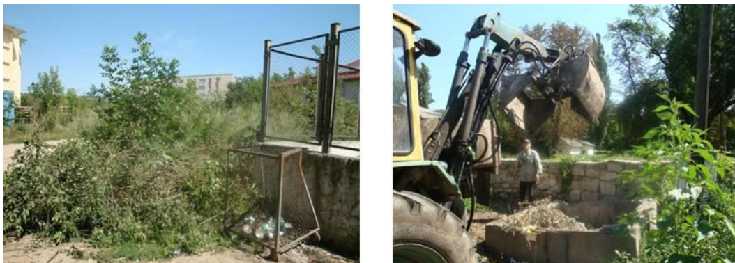
Figura 50: Sistem de precolectare a deseurilor in orasul Soroca
