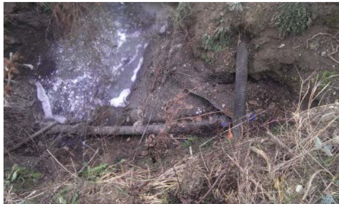
Imaginea 3. Starea fizică a conductelor de alimentare cu apă și de canalizare
