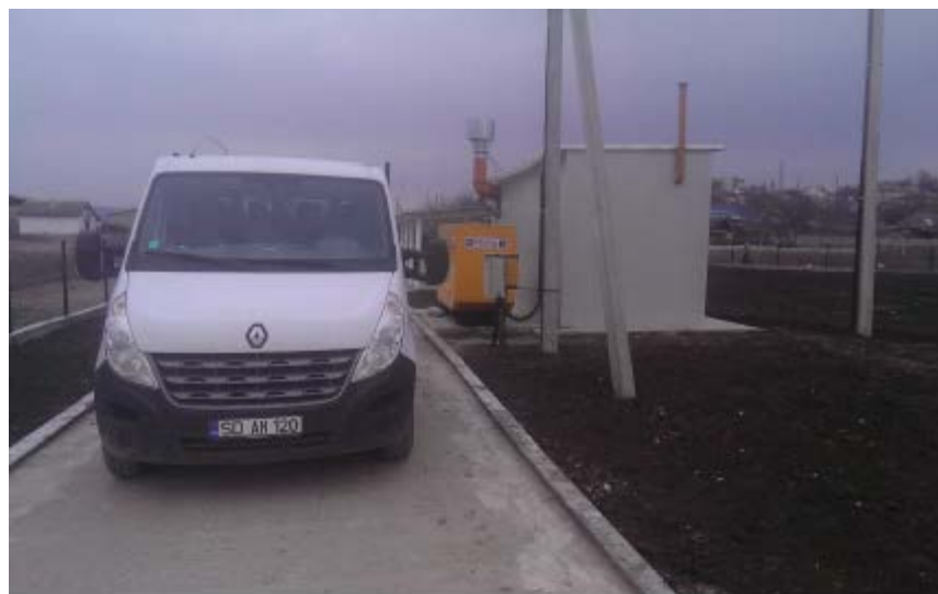
Imaginea 12. Platforma „A” Clădirea instalației de deshidratare și de compresoare
