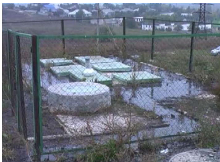
Imaginea 13. Stația de epurare din or. Șoldănești în stare de avarie
