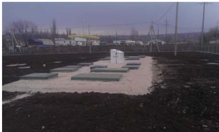
Imaginea 11. Platforma „A”. Stația de epurare „TOPAS - 300”
