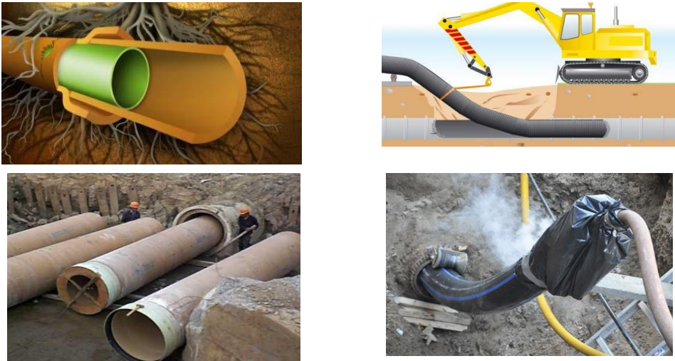
Fig. 35 Relining cu tub nou în tubul vechi
