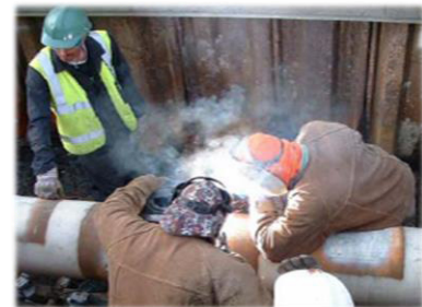
Fig. 9 Remedierea tuburilor din oțel prin sudare cu petice
