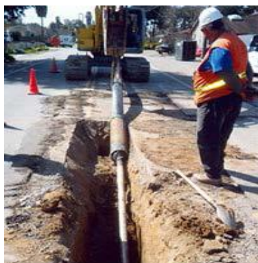
Fig. 42 - Tehnologia de foraj orizontal dirijat
