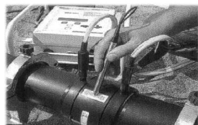
Fig. 86 Conectarea aparatului la fitting și citirea codului de bare a fittingului
