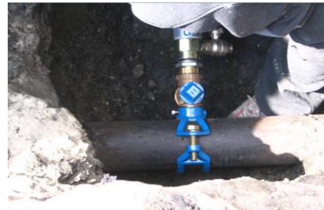
Fig. 19 Construcție branșament, dispozitiv de găurire în conducta sub presiune
