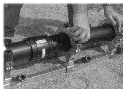
Fig. 85 Fixarea elementelor de sudat în aliniament
