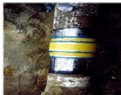
Fig. 10 Repararea conductelor cu material compozit
