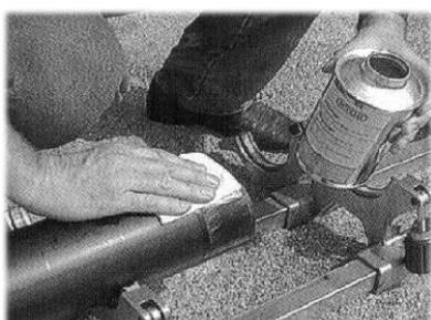
Fig. 84 Degresarea capetelor de conductă
