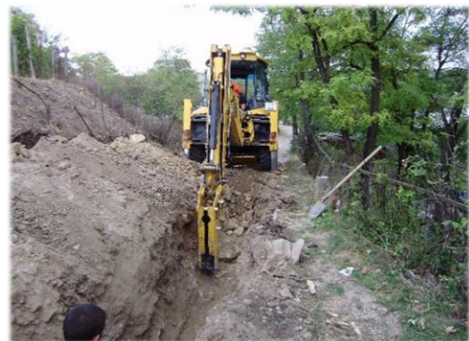
Fig. 18 Executarea tranșeului cu excavator cu cupă inversă
