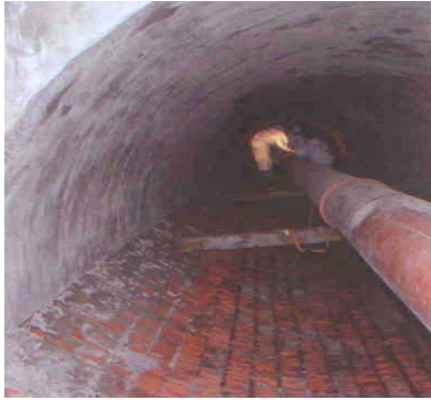
Fig. 33 a, b Cămășuire cu beton armat realizat prin torcretare
