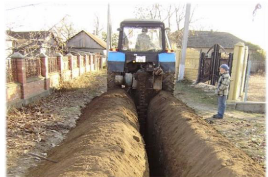
Fig. 22 Executarea săpături cu excavator cu lanț
