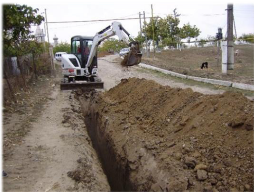
Fig. 18 Executarea tranșeului cu excavator cu cupă inversă
