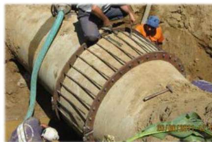
Fig. 6 Remedierea mufelor tuburilor din beton armat
