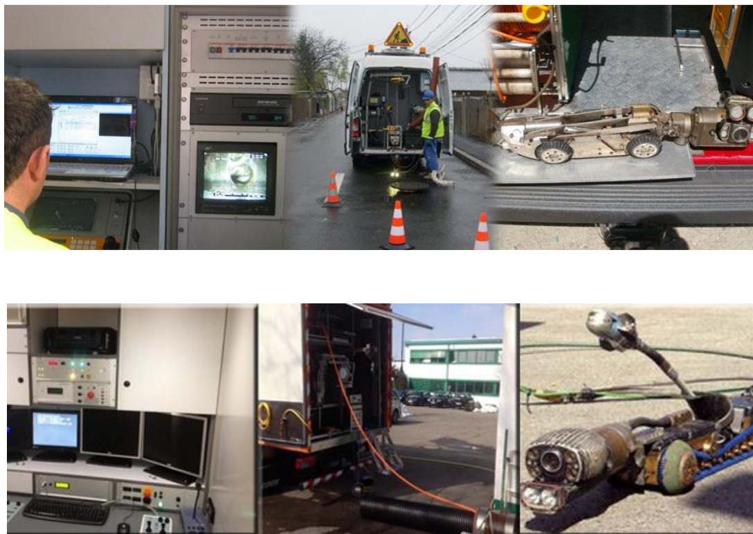
Fig. 31 a, b Inspecția CCTV a rețelelor de canalizare
