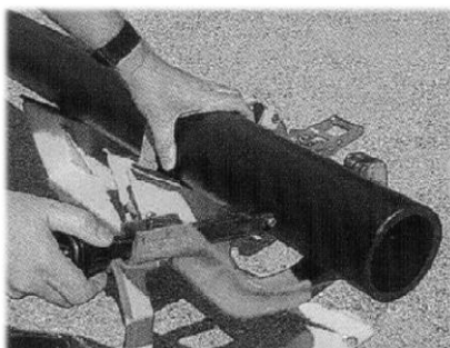
Fig. 82 Tăierea capetelor pe conductă la un unghi de 90°
