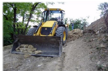
Fig. 14. Executarea lucrărilor cu buldo-excavatoare
