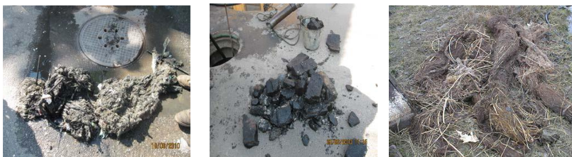
Fig. 22 Materiale ce blochează rețeaua de canalizare
