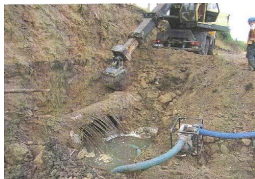
Fig. 4 Fragmentarea tubului de beton armat prefabricat
