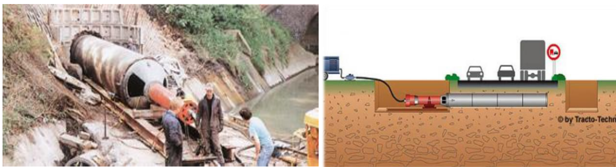
Fig. 139 Forare prin percuție
