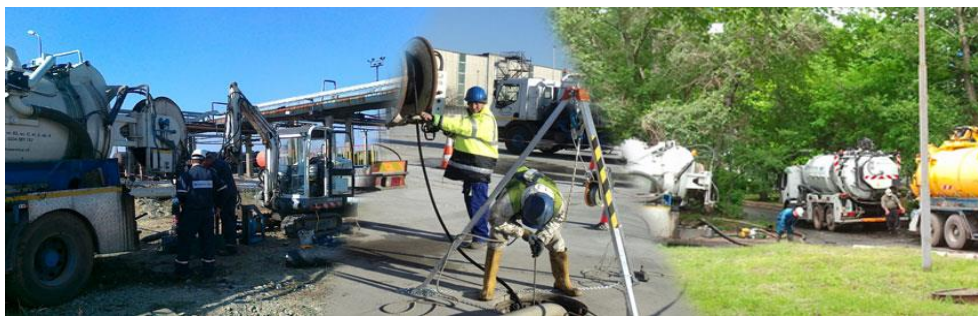
Fig.28 Curățarea rețelei de canalizare
