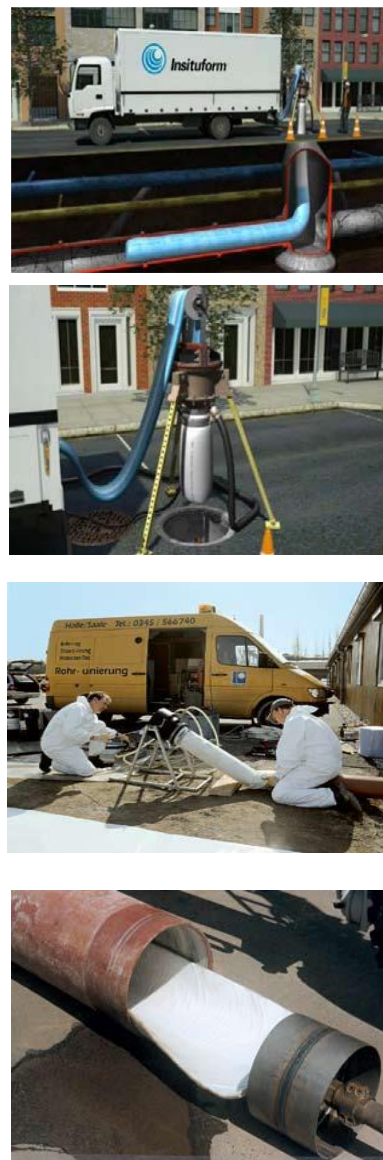
Fig. 34 Faze din tehnologia CIPP
