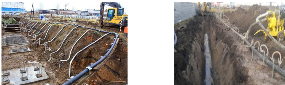
Fig. 37 Vederi generale a instalațiilor de filtre aciculare montate la săpături
