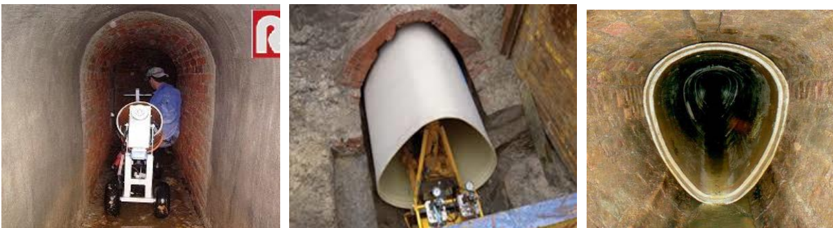
Fig.36 Cochilie din fibră de carbon, poliester armat cu fibră de sticlă așezată în tubul vechi
