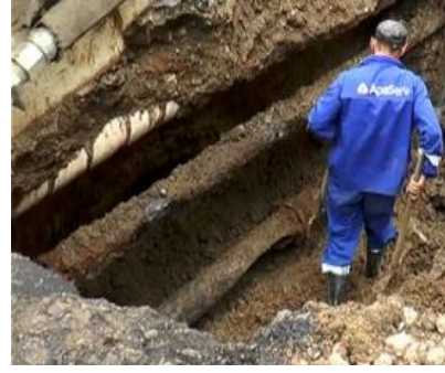
Fig. 11 Tub din fontă expulzat
