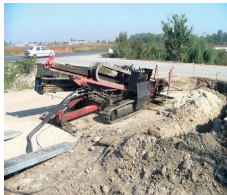
Fig. 42 - Tehnologia de foraj orizontal dirijat
