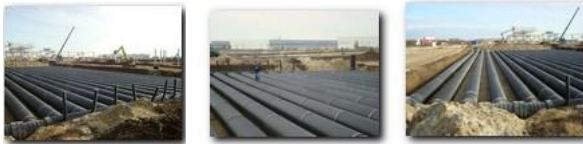
Fig. 105 Vedere generală asupra tuburilor riflante montate pe șantier
