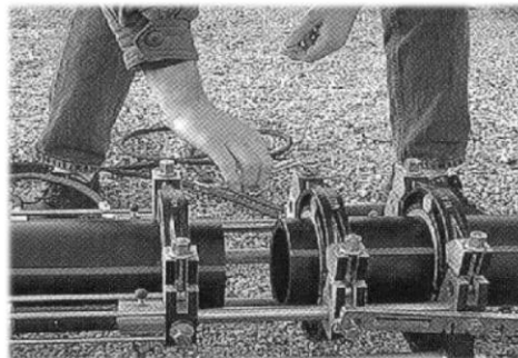
Fig. 72 Prinderea capetelor de conductă în bacurile aparatului de sudare
