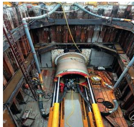
Fig. 44 Tehnologia scutului mecanic
