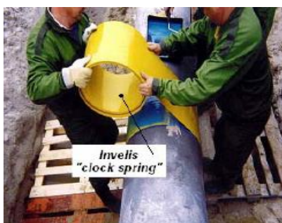
Fig. 10 Repararea conductelor cu material compozit
