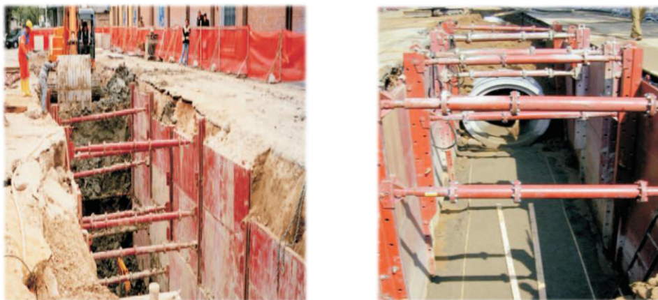
Fig.31 Panouri metalice de inventar (vedere generală)
