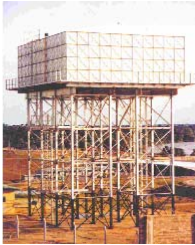
Fig.7.33 Castel de apă din oțel de tip BRAITHWAITE
