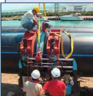
Предназначен для сварки напорных трубопроводов Ø 710–1000 мм (до PN 20), в т. ч. газопроводов, из полипропилена, полиэтилена и других термопластиков.
