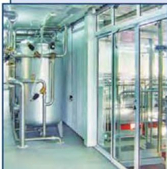
Установка предназначена для очистки хозяйственно-бытовых и близких к ним по составу промышленных сточных вод с доведением показателей качества очищенной воды до нормативов сбросов в рыбохозяйственные водоемы.
