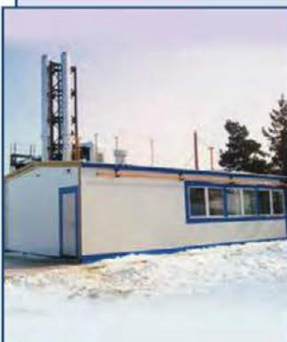
Автоматизированные блочно-модульные котельные "БМТК" мощностью от 100 до 30 000 кВт (климатического исполнения и категории размещения УХЛ 1 по ГОСТ 15150-69). Код ОКП 49 3811 (свидетельство № Т-321, действительно до 17.02.14).
