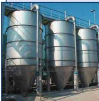
Песчаный фильтр HUBER CONTIFLOW® (Германия) применяется для доочистки коммунальных и промышленных сточных вод, а также водоподготовки.
