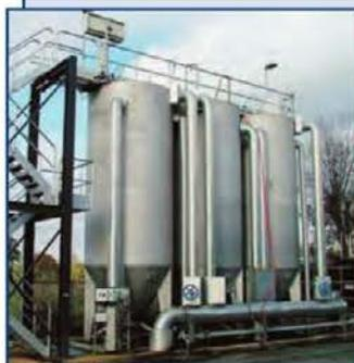
Контактные фильтры непрерывного действия DynaSand применяются на муниципальных и промышленных предприятиях для процессов очистки. Назначение:
