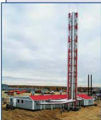
Производство блочно-модульных котельных серии БМК полной заводской готовности для отопления и горячего водоснабжения.
