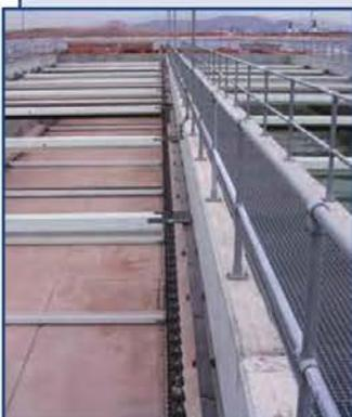
Производство различных типов скребковых систем Finnchain (Финляндия) для сбора донного илового осадка, плавающих веществ и песка. Область применения – водопроводные и канализационные очистные сооружения.
