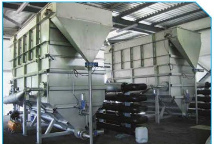
Очистные сооружения Московской пивоваренной компании (7200 м<sup>3</sup>/сут); барабанные сита, шнековые транспортеры, флотаторы, шнековые прессы, дисковые фильтры.
