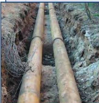
Производство высококачественных теплопроводов в пенополимерминеральной (ППМ) изоляции – разработанных научно-исследовательским институтом ВНИПИЭнергопром и адаптированных к российским условиям.
