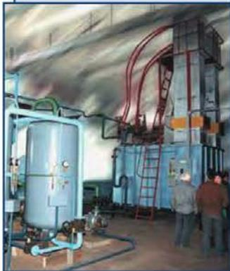
Предназначен для очистки воды из подземных источников до качества, соответствующего требованиям СанПиН 2.1.4.1074-01 "Питьевая вода и водоснабжение населенных мест", придания воде вкусовых качеств, соответствующих природным водам горных рек.
