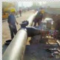
**AL500** – для труб  $\varnothing$  180–500 мм (с комплектом вкладышей (полуколец) на диаметры: 180; 200; 225; 250; 280; 315; 355; 400; 450; 500 мм).
