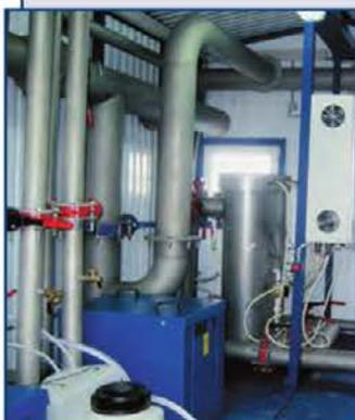
Автоматизированные станции поверхностных сточных вод ЛОС предназначены для приема и очистки поверхностных (ливневых или дождевых) сточных вод до нормативов, предъявляемых к выпуску в рыбохозяйственные водоемы 1-й категории.
