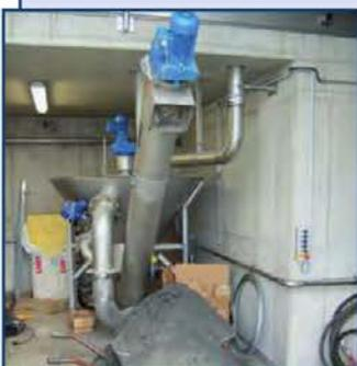
Пескопромыватель HUBER RoSF 4 (Германия) предназначен для сепарации, обезвоживания и промывки песка, задержанного в песколовке.
