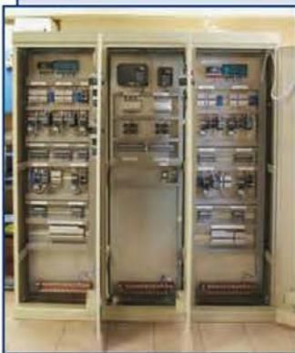
Станция управления частотно-регулируемым приводом насосных агрегатов "СУ-ЧЭ" предназначена для автоматического и ручного управления группой насосных агрегатов с асинхронными электродвигателями, работающих в системах холодного и горячего водоснабжения, и может работать как составная часть системы электрооборудования тепловых пунктов коммунального хозяйства.
