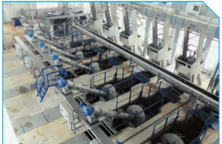
Олимпийский объект: очистные сооружения г. Адлера (100 000 м<sup>3</sup>/сут); решетки грубой, тонкой мехочистки, сепарация песка, дисковые фильтры доочистки
