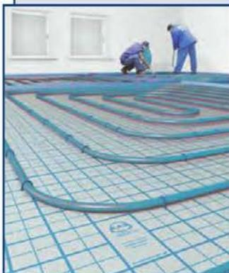
Система KAN-therm "Теплый пол" предназначена для отопления, охлаждения внутри зданий со встроенными в стены, потолки и полы нагревательными элементами, а также подогрева открытых поверхностей (спортивные площадки, коммуникационные трассы, ступеньки в переходах, подъездные пути и террасы и т. п.).
