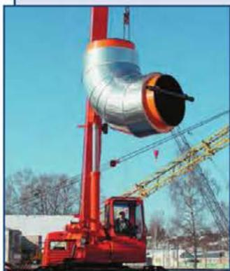
Трубопроводные системы в ППУ изоляции для трубопроводов пара и горячей воды.
