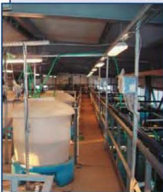
Многоступенчатый биологический способ очистки с обеззараживанием очищенной воды ультрафиолетом и обезвоживанием осадка.
