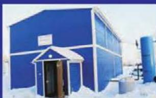
Станция водоподготовки в блок-боксе
