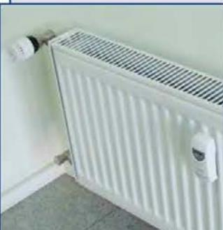
Система автоматизированного учета энергоресурсов INDIV AMR предназначена для индивидуального учета тепловой энергии на базе счетчиков распределителей INDIV-5(5R) в зданиях с вертикальной (стояковой) разводкой системы отопления.
