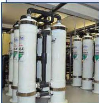
Предназначены для предварительной очистки перед установками обратного осмоса; очистки питьевой воды; очистки воды для бассейнов; фильтрации технологической воды; очистки сточных вод для повторного использования.
