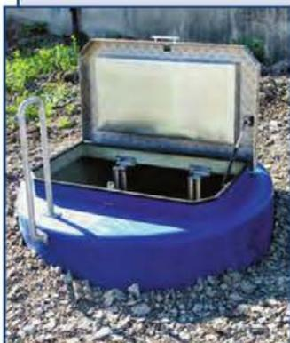
Комплектные стеклопластиковые канализационные насосные станции предназначены для перекачки хозяйственно-бытовых и близких к ним по составу сточных вод, удовлетворяющих Правилам приема сточных вод в систему коммунальной канализации.
