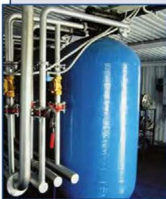
Проектирование и производство станций водоподготовки ВОС для приема и очистки малозагрязненных природных подземных вод до показателей качества очищенной питьевой воды согласно СанПиН 2.1.4.1074. Производительность автоматизированных блочно-модульных станций водоподготовки ВОС – от 50 до 800 м<sup>3</sup>/сут, рассчитывается в зависимости от состава и режима поступления исходной воды из источника.
