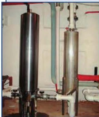
Предназначена для эффективной очистки различных потоков воды (сетевой, подпиточной, оборотной, сточной и др.) от механических взвешенных примесей размером более 10 мкм. Может применяться на объектах ЖКХ (вводы холодной и горячей воды в жилые дома, котельные и ТЭЦ, промышленные предприятия) для обеспечения требуемого качества воды.
