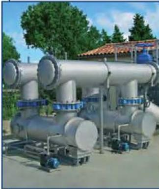
Оборудование для обеззараживания очищенных сточных вод в напорных/безнапорных схемах водоотведения, в т. ч. для систем повторного использования. Группы установок: УДВ (с продольным обтеканием) и УДВ Pro (с поперечным обтеканием). В каждой группе существуют спецсерии оборудования для обеззараживания воды с низким УФ-пропусканием, характерным для сточных вод.
