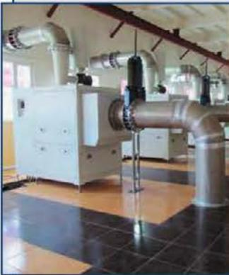
Турбовоздуховодки на бесконтактной опоре – компактное, экономичное воздушноагнетательное оборудование нового поколения, отличающееся низким уровнем шума, вибрации.
