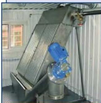
Устройство фильтрующее самоочищающееся предназначено для отделения включений до 2 мм из сточных вод.
