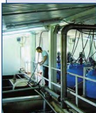
Блочно-модульные станции ЁРШ® биохимической (физико-химической) очистки сточных вод предназначены для приема и глубокой очистки сточных вод (низкоконцентрированных; смешанных; сточных вод, состав которых значительно колеблется при суточных и сезонных колебаниях) до нормативов, предъявляемых к выпуску в рыбохозяйственные водоемы 1-й категории.
