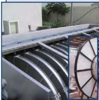
Самопромывной дисковый фильтр HUBER RoDisc® (Германия) предназначен для доочистки стоков после вторичных отстойников, подготовки оборотной и технической воды, предочистки на водозаборах из поверхностных источников. Самотечная безнапорная микрофльтрация с очень высокой эффективностью задержания взвешенных веществ.
