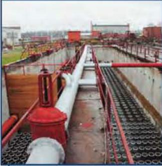
Поставка дисковых и трубчатых мембранных аэротенков различных типоразмеров.
