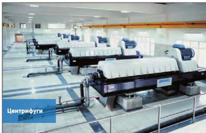
центрифуги имеют полностью закрытую конструкцию и работают непрерывно.
