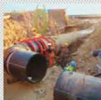
**AL800** – для труб  $\varnothing$  500–800 мм (с комплектом вкладышей (полуколец) на диаметры: 500; 560; 630; 710; 800 мм).
