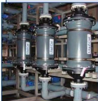
Предназначены для дегазации жидкостей (альтернатива вакуумным дегазаторам, стриппер-колоннам и химическим уловителям кислорода):
