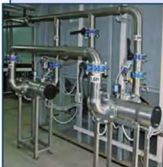
Установки предназначены для обеззараживания воды питьевого и технологического пользования, очищенных сточных вод.
