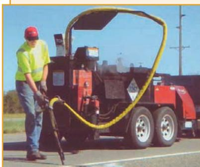
Установка Dura Patcher (США) предназначена для выполнения работ по ямочному ремонту дорожного покрытия путем нагнетания и самоуплотнения ремонтного материала в течение нескольких минут.
