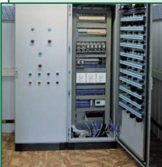
Автоматизированная система предназначена для эффективного контроля и управления, в т. ч. дистанционного, технологическим оборудованием.
