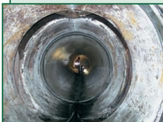
Ремонт канализационных трубопроводов методом установки мягкого полимерного рукава AARSLEFF Ø 200–2500.
