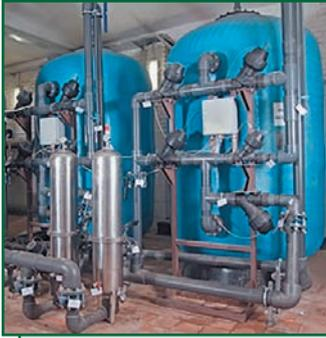
Блочно-модульные установки обезжелезивания предназначены для удаления из воды растворенного и коллоидного железа, марганца, сероводорода, мутности.
