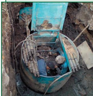
Установка направленного прокальвания УНП-630 предназначена для работы в стесненных условиях, в т. ч. в колодцах диаметром 1,5 м, на глубине более 10 м, без бурового раствора (важно в зимнее время), в водо-насыщенном грунте.
