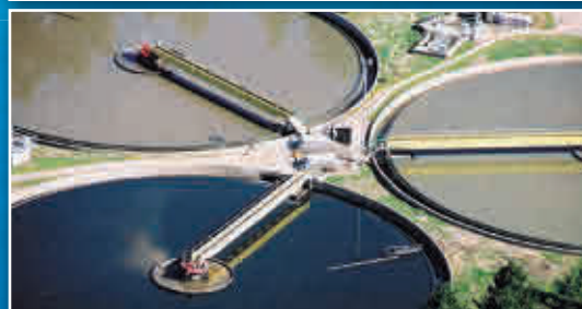
Очистные сооружения Сент-Этьен (Франция)
