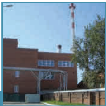
Паровая котельная на ОАО «Белостолбовский кирпичный завод», Московская область
