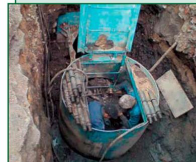
Установка направленного прокальвания УНП-630 работает в очень стесненных условиях, в т. ч. в колодцах диаметром 1,5 м, на глубине более 10 м, без бурового раствора (важно в зимнее время), в водо-насыщенном грунте.
