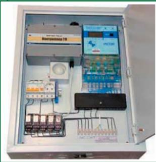
Возможность работы в режиме управления, автоматическом и ручном режимах. Возможность адресного управления как головными, так и каскадными пунктами включения освещения. В случае каскадного включения – контроль включения всего каскада. Контроль целостности общих предохранителей. Коммерческий учет потребления электроэнергии (система сертифицирована как средство измерения).
