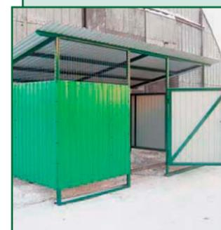
В основе контейнерной площадки – металлический каркас из профильных труб. Сварной способ изготовления каркаса предотвращает возможность несанкционированной частичной разборки площадки в течение всего срока ее эксплуатации. Снабжена крышей согласно требованиям СЭС. Крыша защищает контейнеры от атмосферных осадков, увеличивая тем самым срок их службы. Сборка всей конструкции осуществляется на заводе, что обеспечивает качество и быстрый монтаж площадки. Габариты 2 610 × 2 400 × 2 490 мм.
