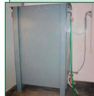
Установка "СОВА" предназначена для очистки сточных вод от механических примесей и нефтепродуктов в замкнутом цикле при мойке автотранспорта. Имеет различную производительность. Очистка моечных стоков осуществляется методом реагентной обработки с тонкослойным отстаиванием и двухступенчатой фильтрацией. Работает в автоматическом режиме. Обеспечивает нормативные показатели очистки. Гигиенический сертификат Госсанэпидслужбы России. На рынке водоочистки 15 лет.
