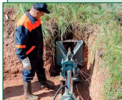
Прокальвающая установка ПУ-2 предназначена для прокладки магистралей методом прокола в грунтах любых типов с одновременным расширением и протяжкой кабеля или трубы ПНД.
