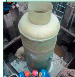
Канализационные насосные станции для отведения сточных и канализационных вод. Корпус изготавливается из прочных полимерных материалов. Выпускаются в полной заводской готовности различного исполнения и комплектации: с лестницей и площадками обслуживания, с рабочими и резервными насосами, креплением насосов, запорной арматурой, трубопроводами
