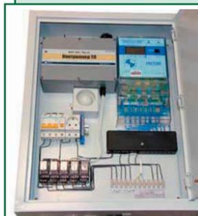
Возможность работы в режиме управления, автоматическом и ручном режимах. Возможность адресного управления как головными, так и каскадными пунктами включения освещения. В случае каскадного включения – контроль включения всего каскада. Контроль целостности общих предохранителей. Коммерческий учет потребления электроэнергии (система сертифицирована как средство измерения).
