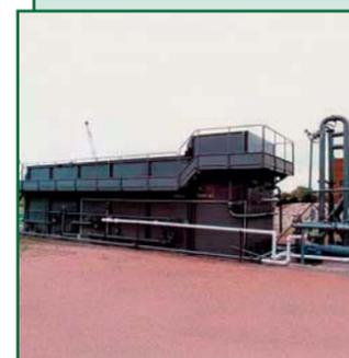
Малые очистные сооружения типа БФ предназначены для очистки хозяйственно-бытовых и биологизируемых промышленных сточных вод. Представляются в виде блоков заводского изготовления. Производительность – 50–360 м<sup>3</sup>/сут.
