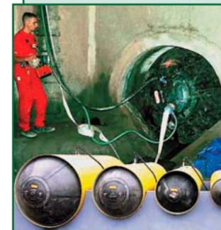
Пневматические заглушающие перекрытия применяются для перекрытия труб сечением от 80 до 2 800 мм.
