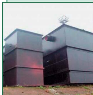
Установка "МУЛ" предназначена для очистки поверхностных нефтесодержащих стоков, устанавливается на дождевом выпуске.
