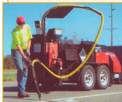
Плавильно-заливочные машины Cimline (США) серии MAGMA предназначены для разогрева и поддержания требуемой температуры мастики, подачи ее под давлением в герметизируемый участок трещины или шва. Нагрев мастики производится через термальное масло. Постоянное перемешивание и равномерный разогрев по всему объему бака. Подогрев в шлангах.
