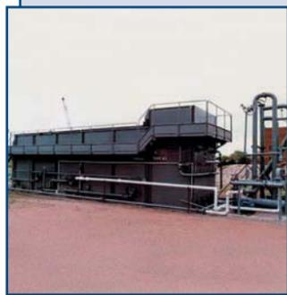
Малые очистные сооружения типа БФ предназначены для очистки хозяйственно-бытовых и биологически очищенных промышленных сточных вод. Поставляются в виде блоков заводского изготовления.
