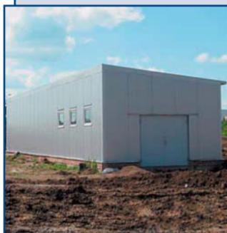
Блочно-модульные установки серии "УЛВ" предназначены для очистки дождевых и талых вод от нефтепродуктов и взвешенных веществ до норм, которые предъявляются к стокам, сбрасываемым в водоемы хозяйственно-питьевого и рыбохозяйственного назначения.
