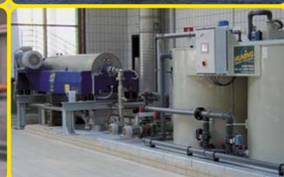
Установка комплексных обезвоживающих машин, включая станцию подачи полимеров и центрифугу.
