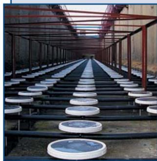
Поставка дисковых и трубчатых аэраторов различных типоразмеров. Основные преимущества:
