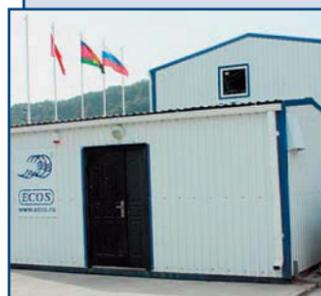
Станции блочно-модульного типа серии "ЕРШ" предназначены для физико-химической и биологической очистки различных сточных вод:
