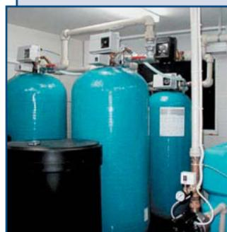
Промышленные фильтры применяются для обработки потоков воды по заданным параметрам (котельные, объекты теплоэнергетики, ЖКХ и различных отраслей промышленности).
