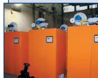
Автоматизированные малогабаритные котлоагрегаты “УТМ” вертикальной компоновки с верхним расположением горелки и встроенной системой прокачки и рециркуляции, адаптированные к работе на общий дымоход.
