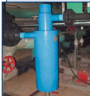
Активатор предназначен для обработки артезианской воды в быту и промышленности.
