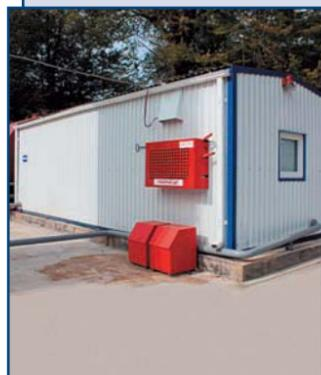
Станции водоподготовки блочно-модульного типа серии "ВОС" предназначены для приема и очистки артезианской воды от соединений общего железа концентрацией до 10 мг/дм<sup>3</sup>.
