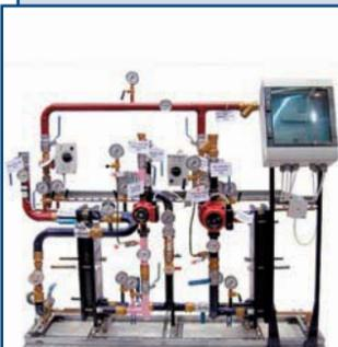
Проектирование, комплектация, монтаж современных индивидуальных тепловых пунктов для систем отопления, горячего водоснабжения, вентиляции промышленных и жилых объектов, офисов, коттеджей, а также других помещений и строений площадью от 50 м².
