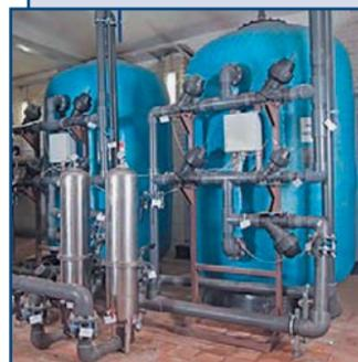
Блочно-модульные установки обезжелезивания предназначены для удаления из воды растворенного и коллоидного железа, марганца, сероводорода, мутности.
