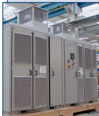
Решение для управления высоковольтными двигателями на базе высоковольтного преобразователя частоты (ВПЧ) серии Robicon Perfect Harmony фирмы Siemens, выполненного по принципу многоуровневого инвертора напряжения с ШИМ на IGBT-транзисторах.
