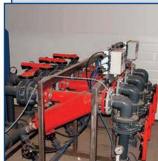
Автоматические самоочищающиеся фильтры AMIAD предназначены для удаления из воды механических загрязнений. Применяются в котельных, системах охлаждения, градирнях, на водозаборах; для предварительной фильтрации перед станциями водоочистки и т. д.
