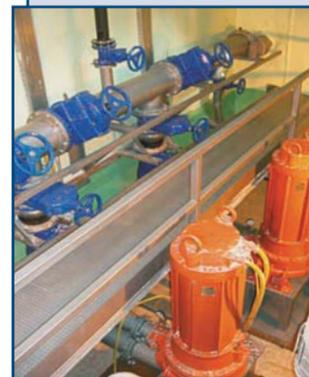
Реконструкция существующих насосных станций. При реконструкции применяются насосные агрегаты ведущих мировых производителей, устанавливаются современные системы автоматизации и КИП, устройства плавного пуска и частотной регулировки насосных агрегатов.
