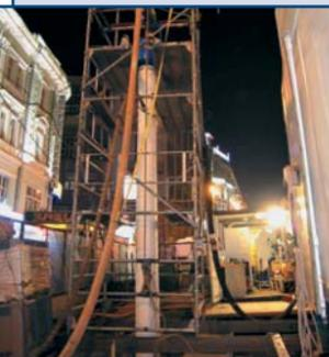
Ремонт водопроводных сетей мягким полимерным рукавом AARSLEFF CIPP Ø 400–1500 мм.
