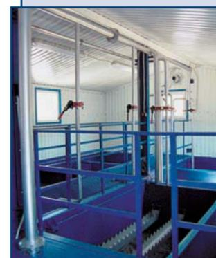
Автоматизированные компактные станции блочно-модульного типа серии "ЕРШ" предназначены для биологической и биохимической очистки хозяйственно-бытовых и сточных вод.
