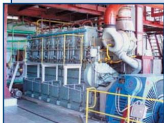
Дизель-электрические агрегаты с двигателями ряда 32/40 служат источником электроэнергии для населенных пунктов в районах, удаленных (отключенных) от централизованных энергосистем, резервным источником питания на предприятиях с непрерывными технологическими процессами.
