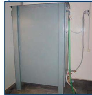
Установка "СОВА" предназначена для очистки сточных вод от механических примесей и нефтепродуктов в замкнутом цикле при мойке автотранспорта. Имеет различную производительность. Очистка моечных стоков осуществляется методом реагентной обработки с тонкослойным отстаиванием и двухступенчатой фильтрацией.
