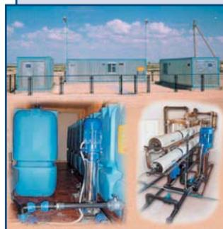
Предназначены для обеспечения качественной питьевой водой населенных пунктов при отсутствии централизованного водоснабжения, а также районов, расположенных в труднодоступных и удаленных местах или с низкой плотностью населения. Устанавливаются в непосредственной близости к потребителю и служат локальным источником питьевого водоснабжения. В состав комплекса входят блоки предварительной подготовки воды, очистки, накопления и раздачи.
