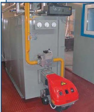
На базе водогрейных газовых котлов КСВа "ЭКО" производятся автоматизированные водогрейные котельные установки теплопроизводительностью от 0,63 до 12,6 МВт.
