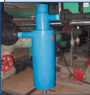
Активатор для защиты и очистки от накипи бойлеров, пластинчатых теплообменников, водогрейных котлов. Заменяет станцию химводоподготовки, обезжелезивания, деаэрации.
