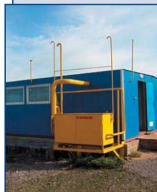
Блочно-модульные котельные полной заводской готовности мощностью от 0,1 до 10 МВт.
