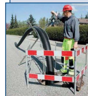
Технология Flexogen®. Внутренняя облицовка трубопроводов (Ø 100–300 мм) путем протаскивания гибкой полиэтиленовой трубы с гофрированной наружной и идеально гладкой внутренней поверхностью.
