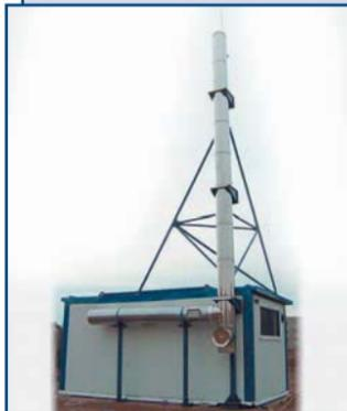
Котельные "АКМА" модульной компоновки в контейнерном исполнении с высокими техническими параметрами производятся на базе высокоэффективных и экологичных котлоагрегатов серии "УМТ". Теплопроизводительность – от 0,5 до 3,0 МВт.
