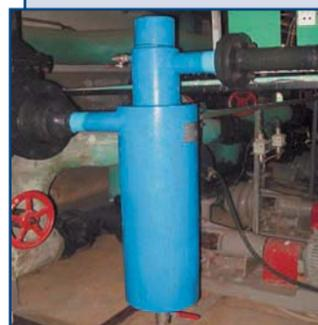
Активатор для защиты и очистки от накипи бойлеров, пластинчатых теплообменников, водогрейных котлов. Заменяет станцию химводоподготовки, обезжелезивания, деаэрации.
