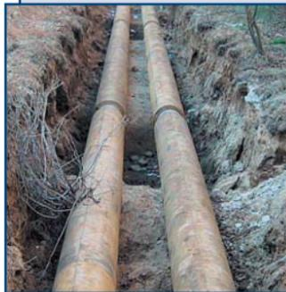
Производство высококачественных теплопроводов в пенополимерминеральной (ППМ) изоляции – разработанных научно-исследовательским институтом ВНИПИЭнергопром и адаптированных к российским условиям.
