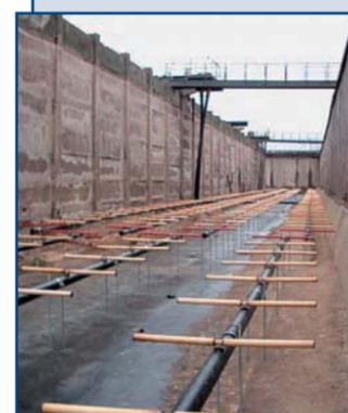
Пористые аэраторы «КРЕАЛ» применяются на станциях биологической очистки. Обеспечивают мелкопузырчатую аэрацию ( $d_n = 3$  мм). По эффективности насыщения воды кислородом не уступают лучшим зарубежным аналогам, отличаясь более низкой стоимостью. Монтируются на придонном воздуховоде, выполненном из труб ПНД с наружным диаметром 110, 160 и 225 мм.
