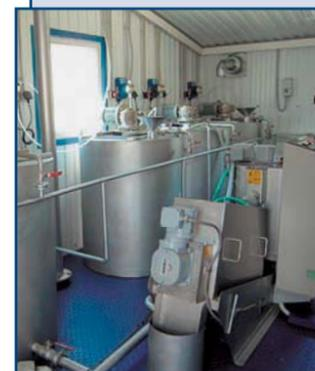
Цех обработки осадка на шнековых дегидраторах предназначен для циклического обезвоживания стабилизированного избыточного ила сооружений биологической очистки хозяйственно-бытовых и близких к ним по составу сточных вод с применением флокулянта.
