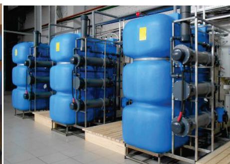
Электролизные установки ЭПМ производительностью 150 кг а.х. в сутки
