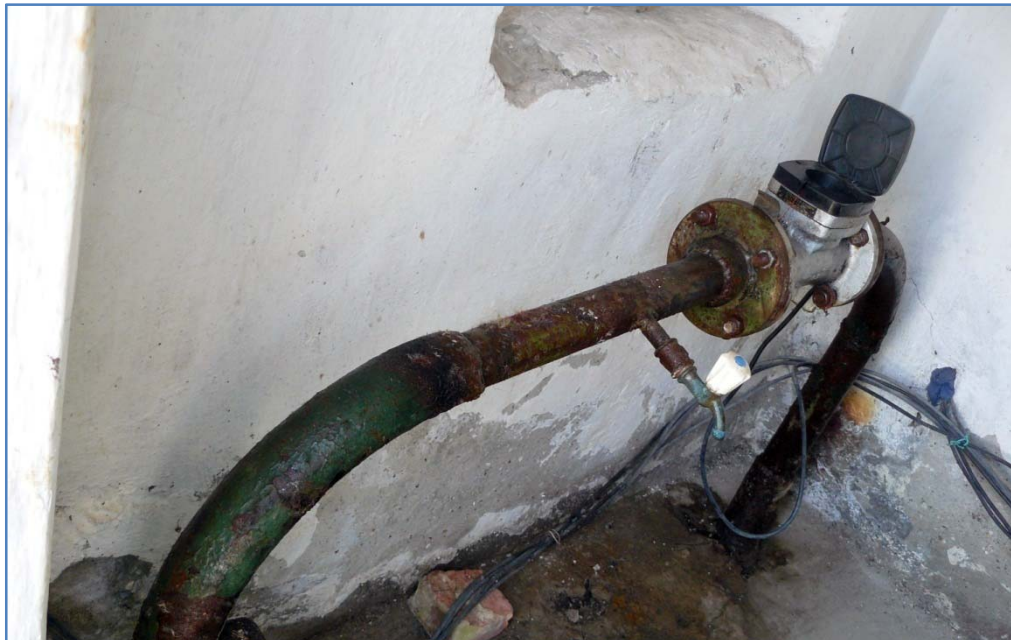
Poza nr.5,nr.6. Stația de pompare a apei din puțul nr.3
