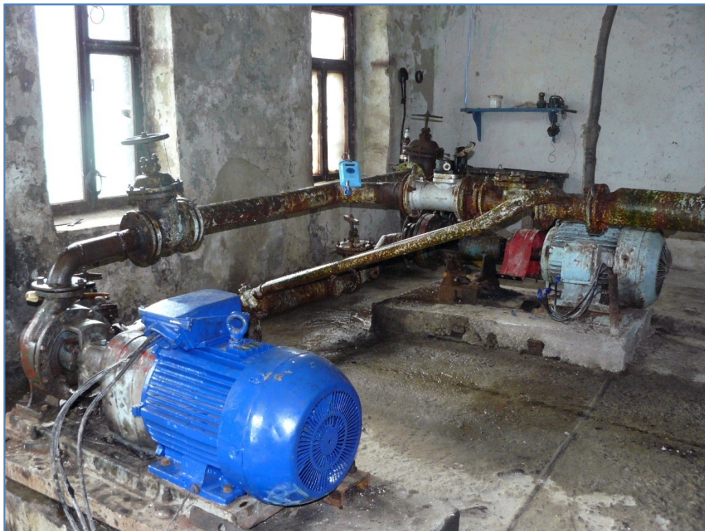
Poza nr.11,nr.12. Stația de pompare a apei SP „Izvorul Subteran”
