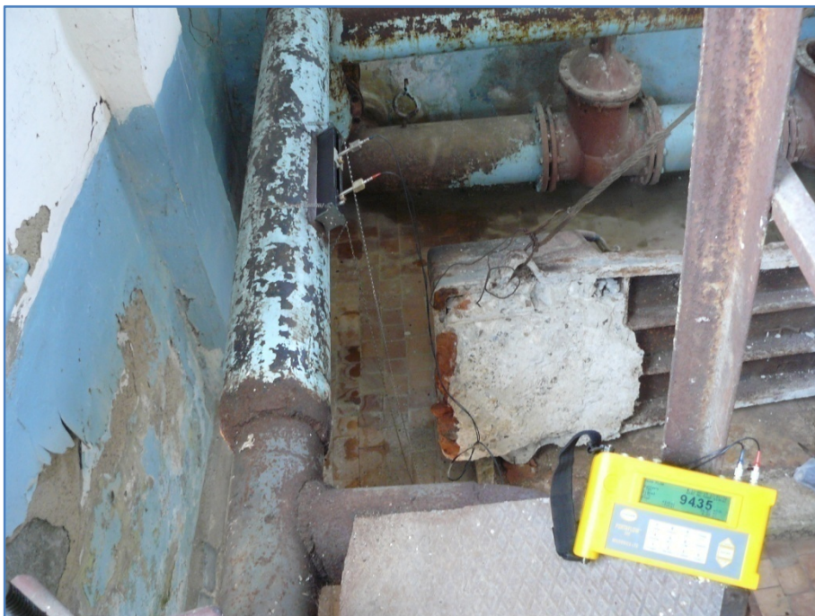
Poza nr.7,nr.8. Stația de pompare a apei nivelul doi SP-2
