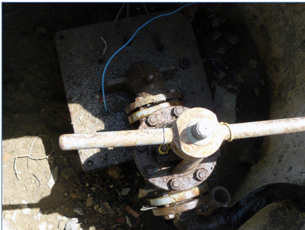
Poza nr.1,nr.2. Stația de pompare a apei din puțul nr.1
