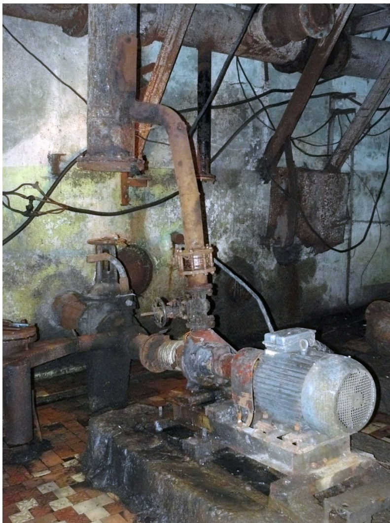
Poza nr.15,nr.16. Stația de pompare a apelor uzate principală SPPC
