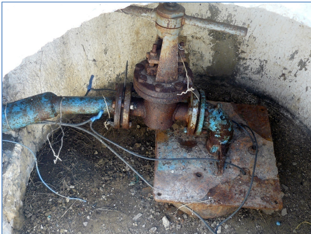
Poza nr.3,nr.4. Stația de pompare a apei din puțul nr.2
