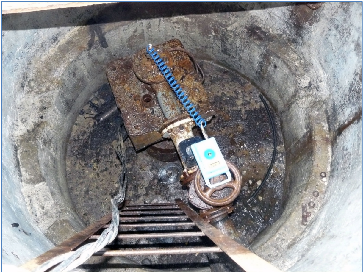
Poza nr.5. Stația de pompare a apei din puțul nr.9
