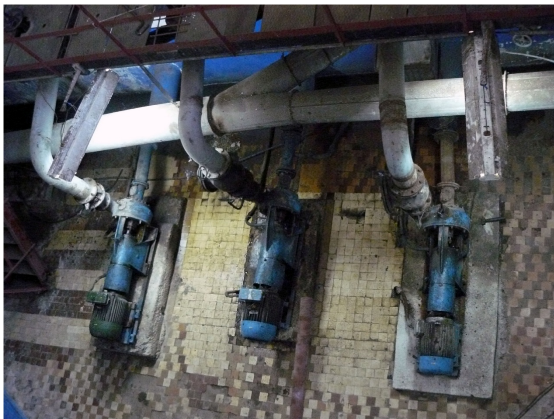
Poza. nr.1, nr.2 Stația de pompare a apelor uzate raională SPC „SCULENI”
