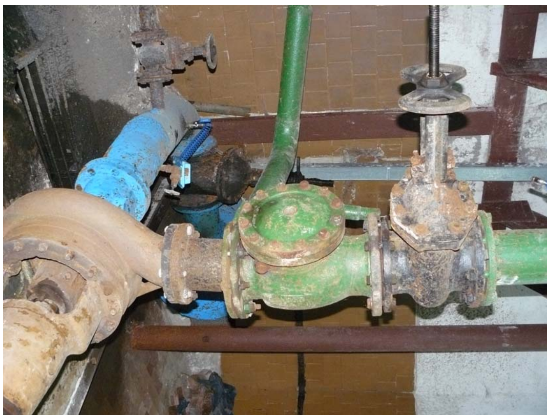
Poza nr.3,nr.4 Sală de mașini. Măsurarea presiunii și debitului în conducte
