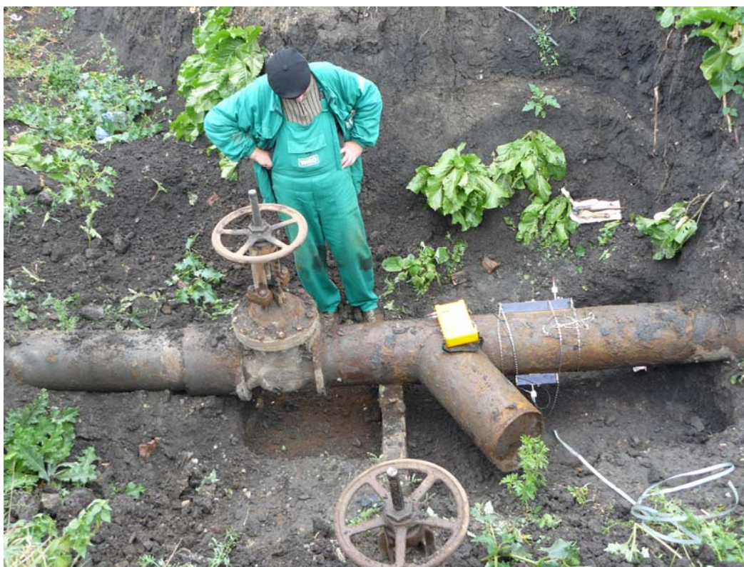
Poza nr.2. Măsurarea debitului în conducta de refulare
