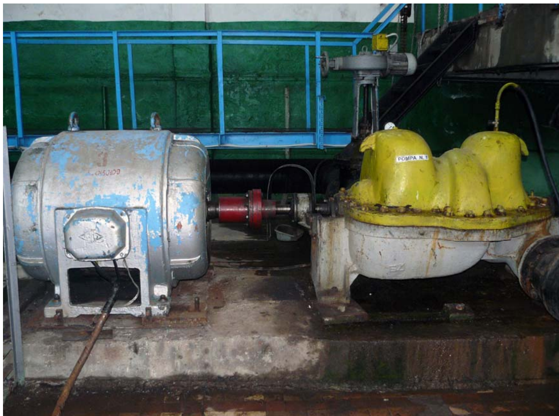
Poza nr.4 și nr.5. Stația de pompare a apei nivelul doi (SP-2).
