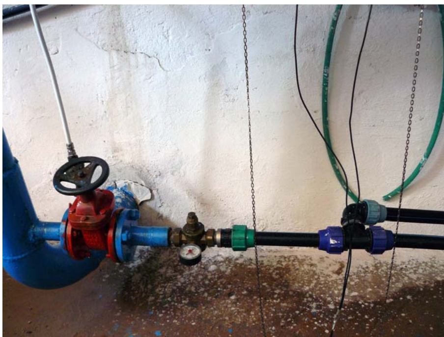
Poza nr.7, nr.8. Stația de pompare a apei nivelul doi (SP-2)
