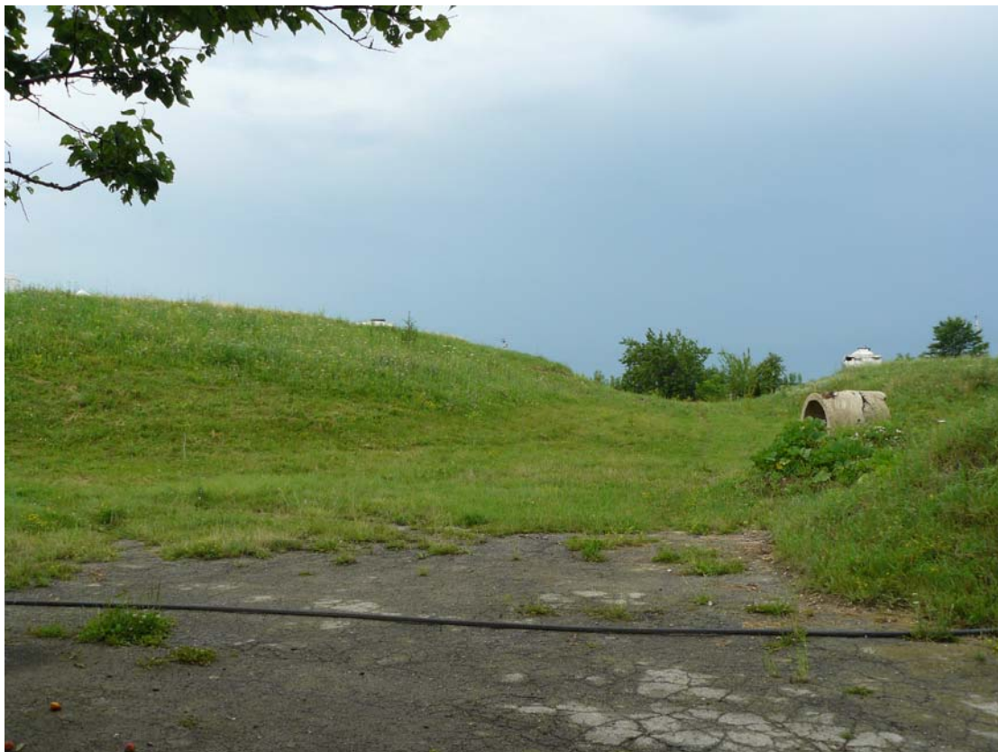
Pozele nr.9, nr.10 Stația de pompare a apei din sectorul „Ciorna” și contrrezervoarelor la cota geodezică + 198,0
