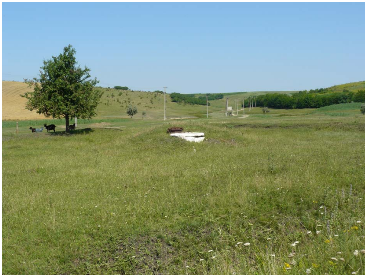
Poza nr.5 Stația de pompare a apei din puțul nr.8 (nr.inventar 1291)
