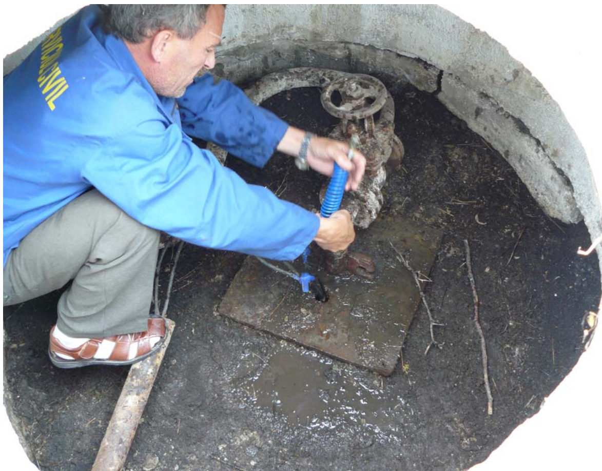
Poza nr.2 Stația de pompare a apei din puțul nr.
