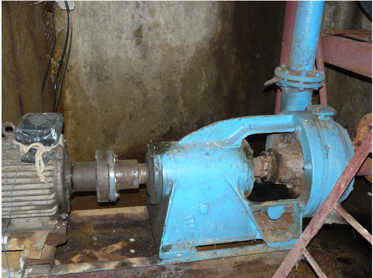
Poza nr.8 Stația raională de pompare a apelor uzate SPC
