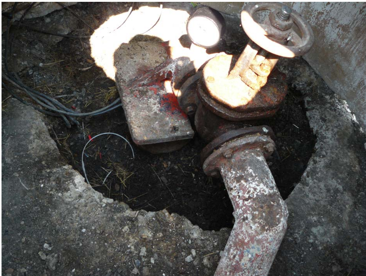
Poza nr.6. Stația de pompare a apei din puțul nr.3 (nr.inventar 3698)
