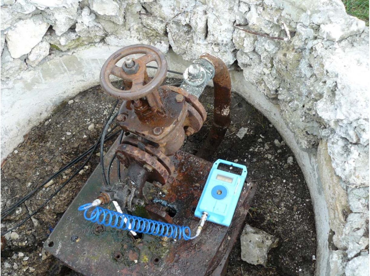
Poza nr.1 Stația de pompare a apei din puțul nr.19
