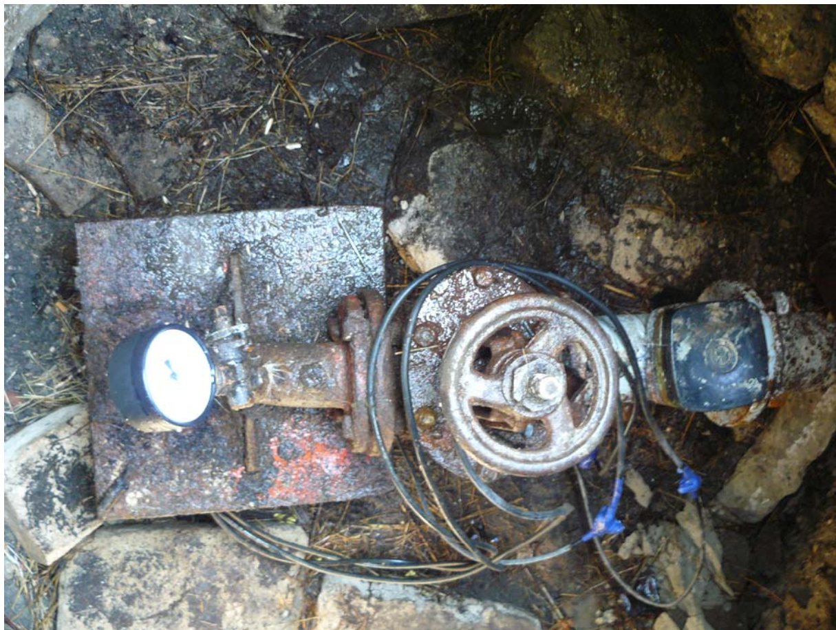
Poza nr.4 Stația de pompare a apei din puțul nr.7 (nr.inventar 1301)
