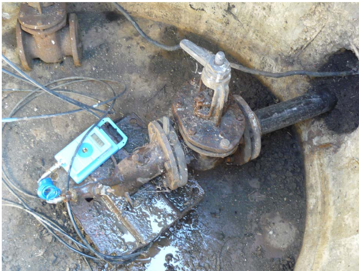
Poza nr.3 Stația de pompare a apei din puțul nr.6 (nr.inventar 1219)
