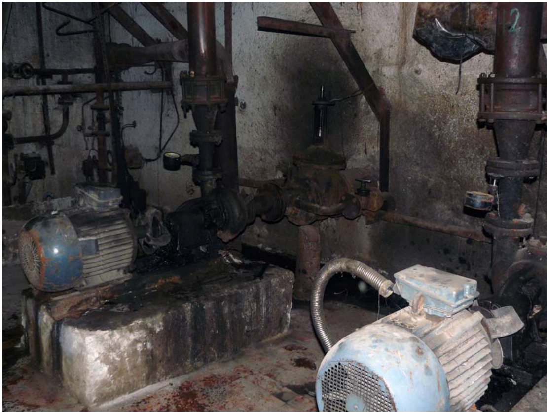
Poza nr.5. Stația de pompare a apelor uzate SPC din com. Floreni.
