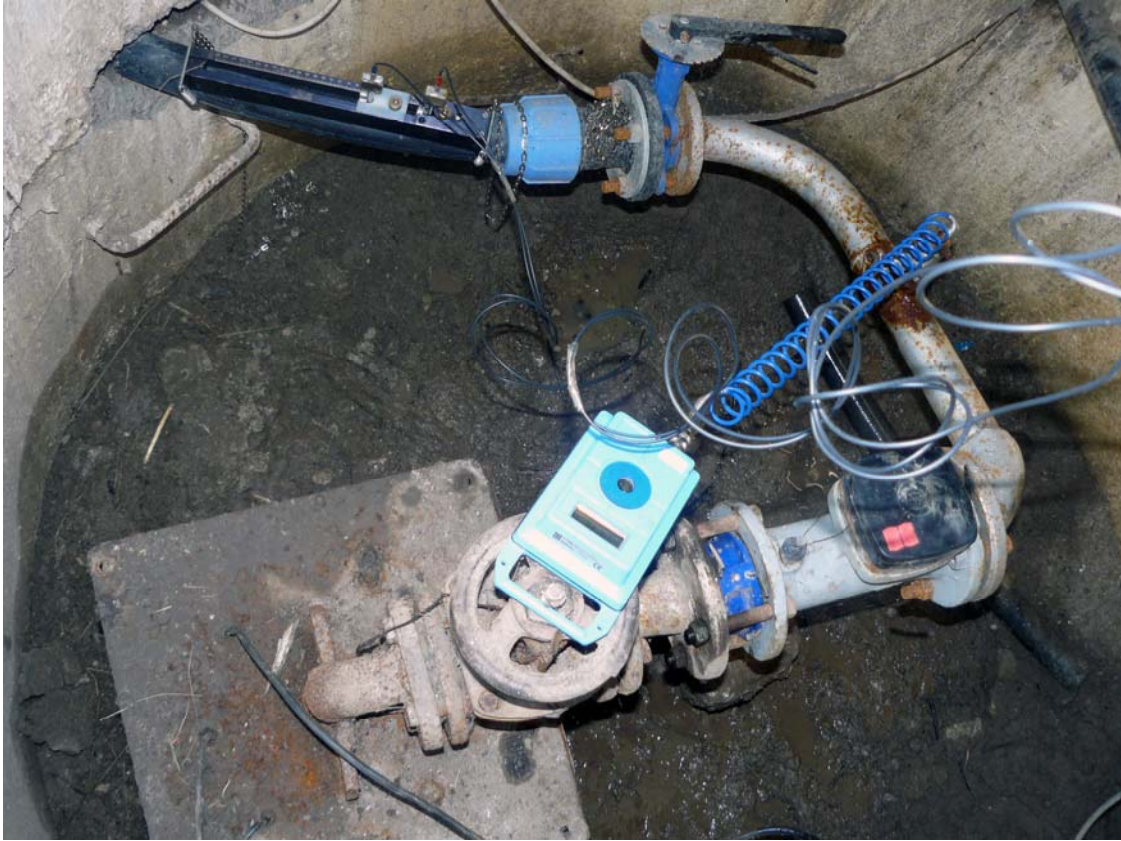
Poza nr.4. Stația de pompare a apei din puțul nr.4 (nr.inventar 3688)
