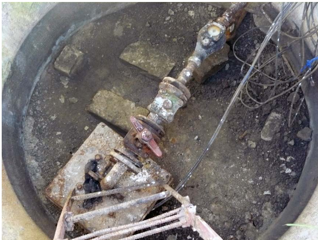
Poza nr.2. Stația de pompare a apei din puțul nr.2 (nr.inventar 4158)
