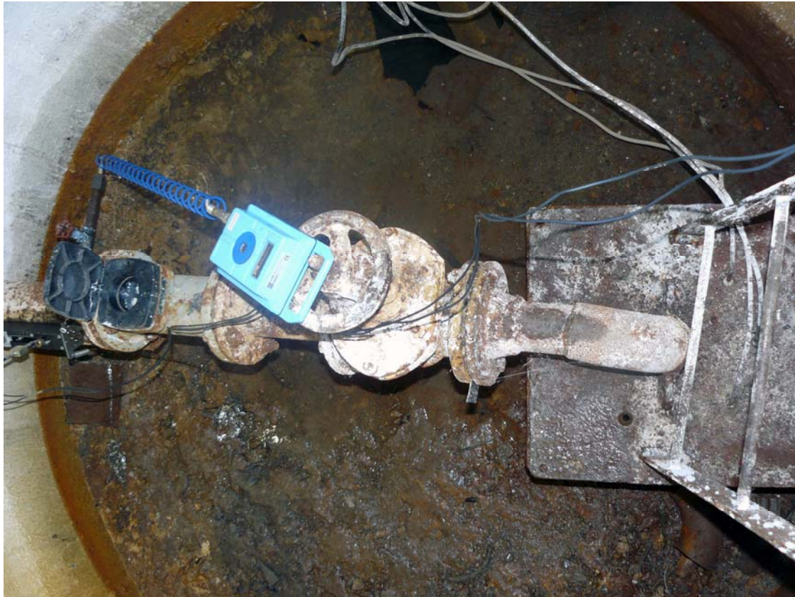
Poza nr.3. Stația de pompare a apei din puțul nr.3 (nr.inventar 4159)
