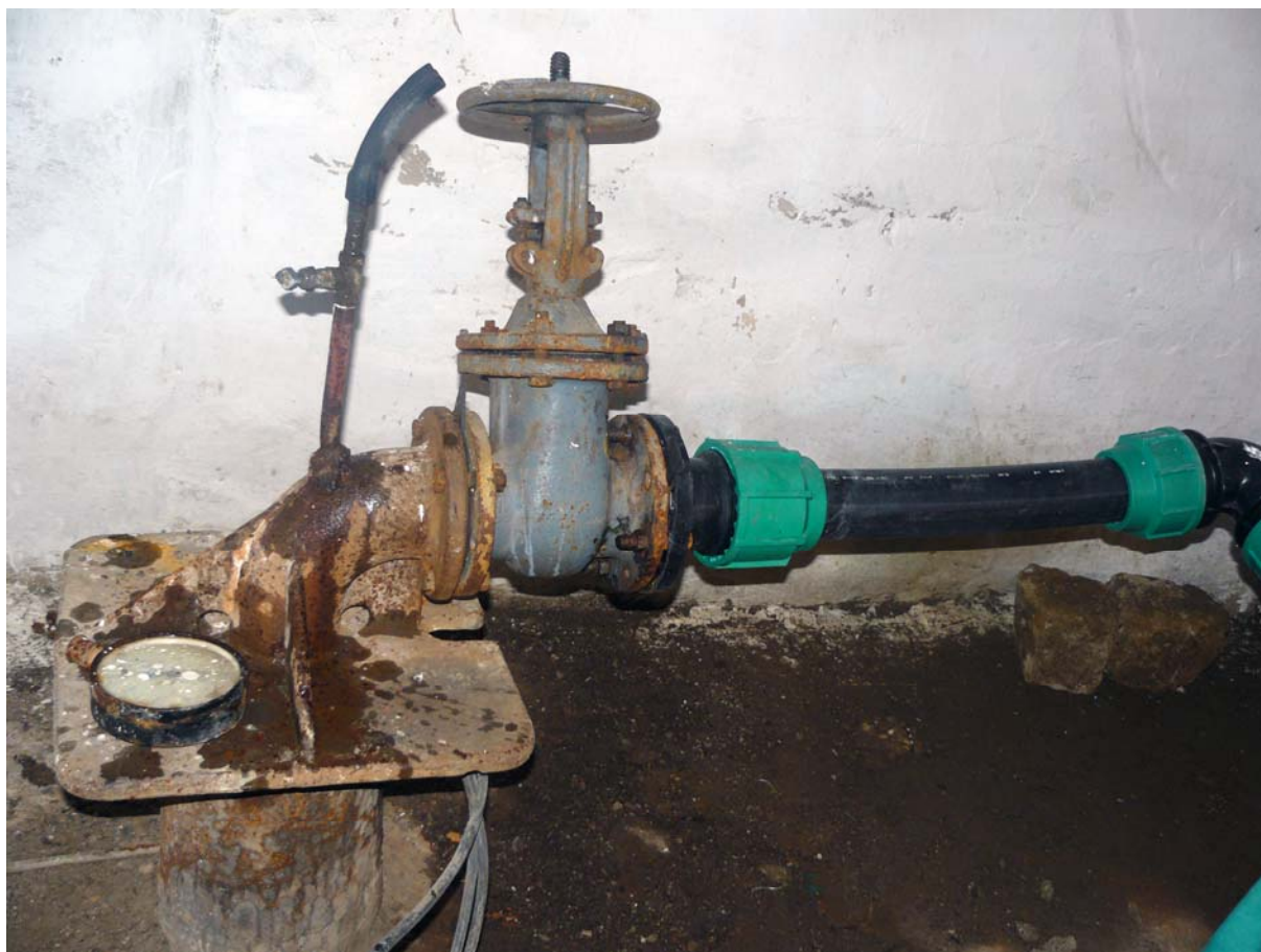
Poza nr.1. Stația de pompare a apei din puțul nr.1 (nr.inventar 2297)
