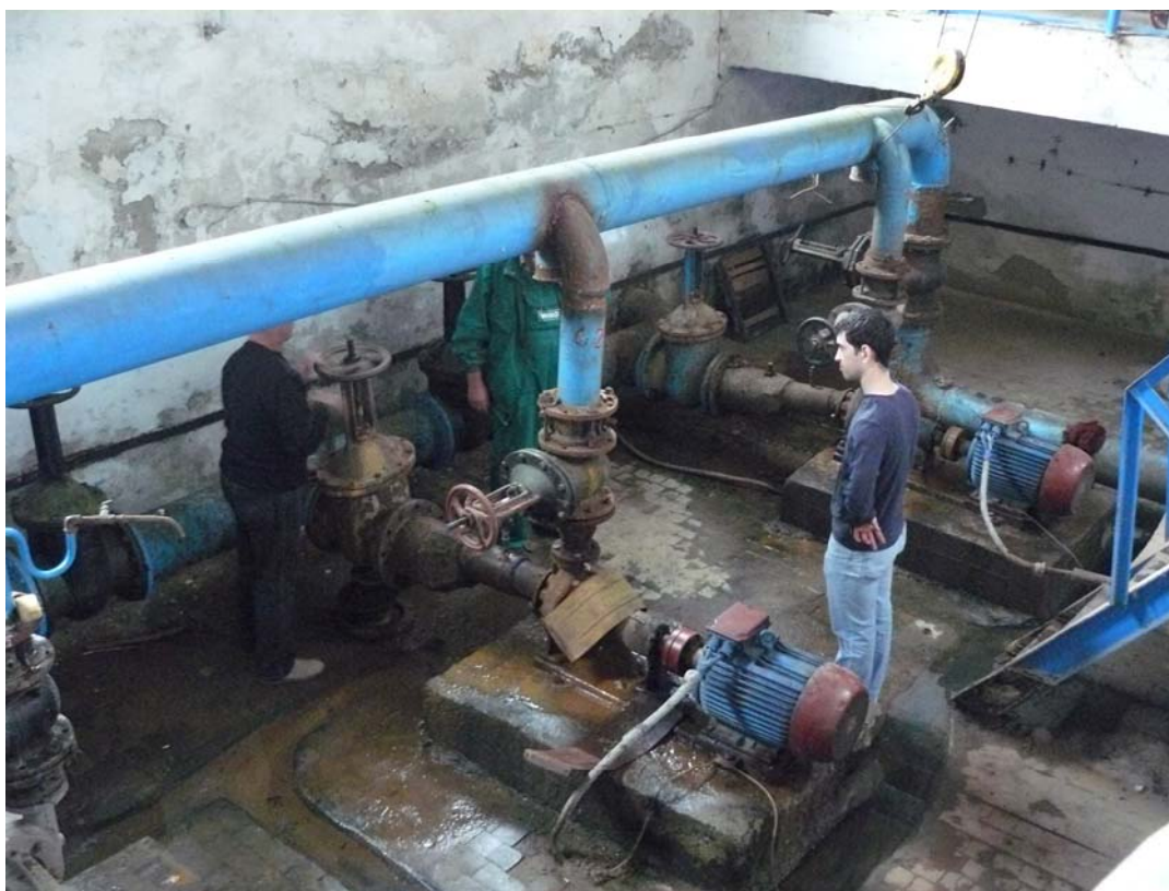
Poza nr.16, nr.17. Stația de pompare a apei nivelul 2 SP-2
