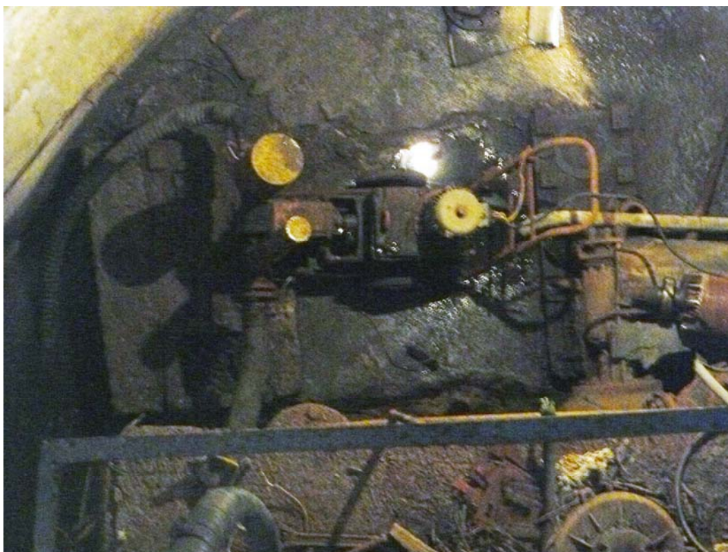
Poza nr.20. Stația raională de pompare a apelor uzate SPC
