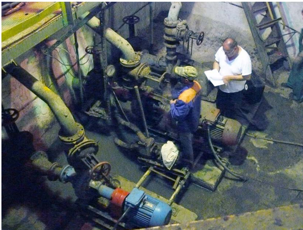
Poza nr.21. Stația principală de pompare a apelor uzate SPC
