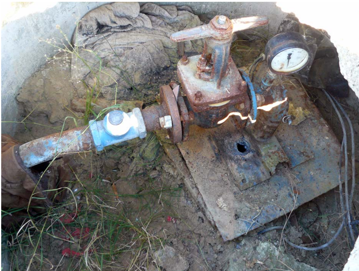
Poza nr.15. Stația de pompare a apei din captajul nr.5
