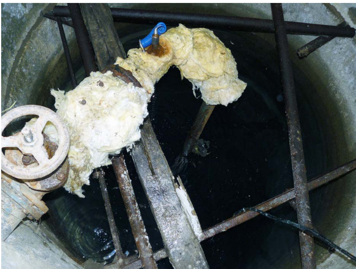
Poza nr.14. Stația de pompare a apei din captajul nr.3
