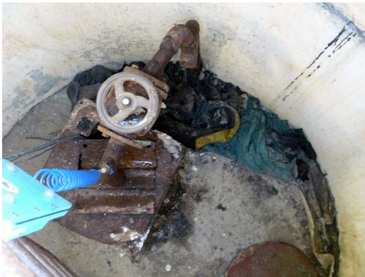
Poza nr.13. Stația de pompare a apei din captajul nr.2
