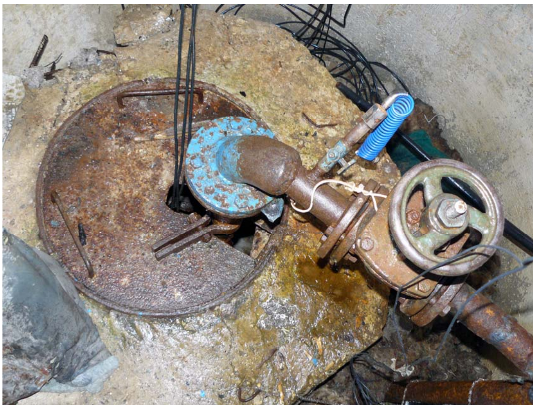
Poza nr.11, nr.12. Stația de pompare din captajul nr.1
