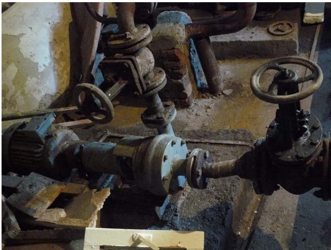
Poza nr.18,nr.19. Stația de pompare și ridicare a presiunii SRP „Casa cu 9 etaje”
