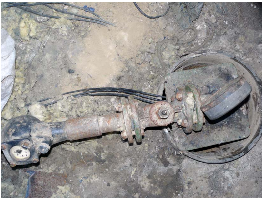
Poza nr.8, nr.9. Stația de pompare a apei din puțul nr.1
