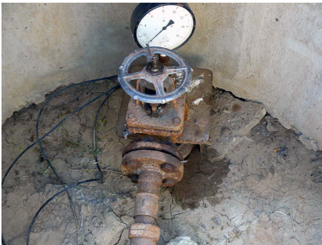
Poza nr.10. Stația de pompare a apei din puțul nr.2
