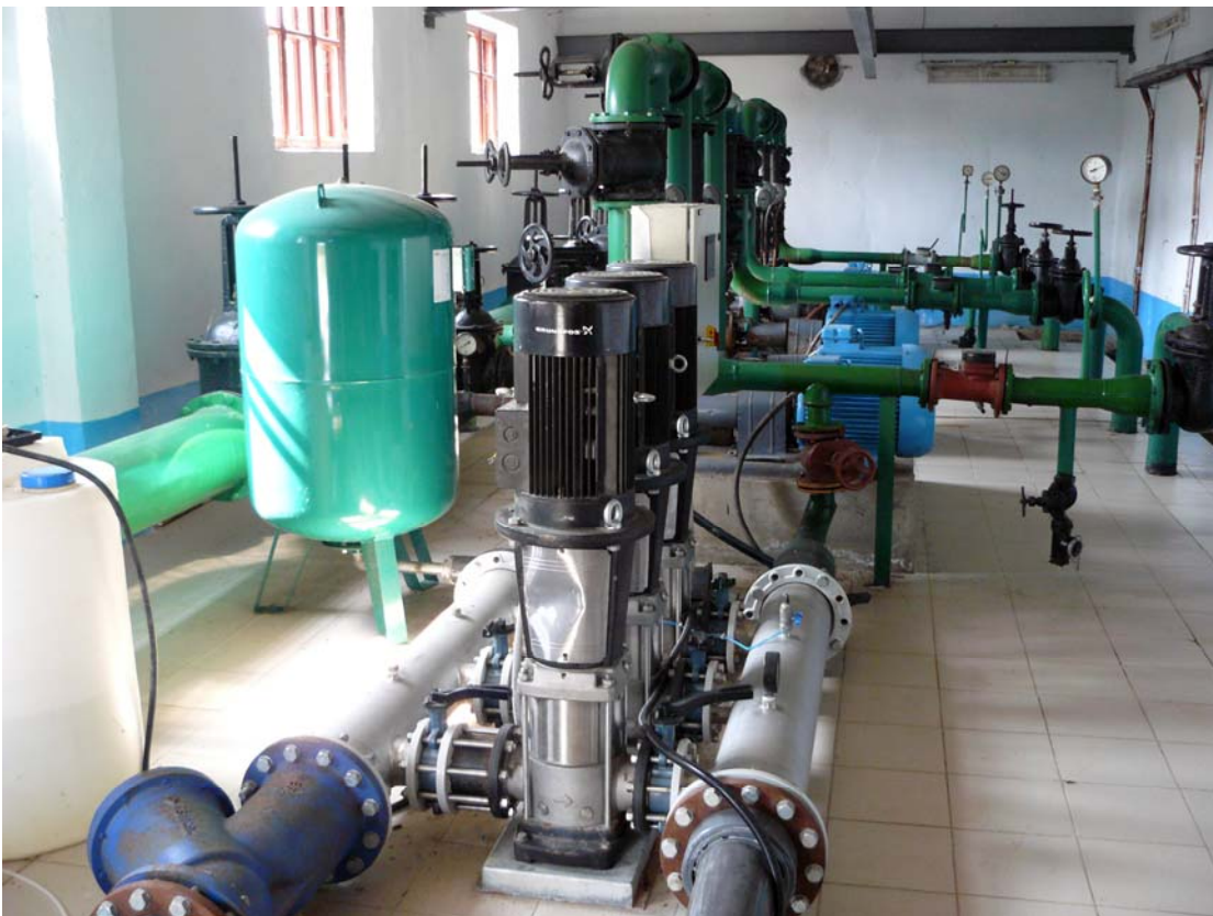
Poza nr.17,nr.18. Stația de pompare a apei nivelul 2 SP-2
