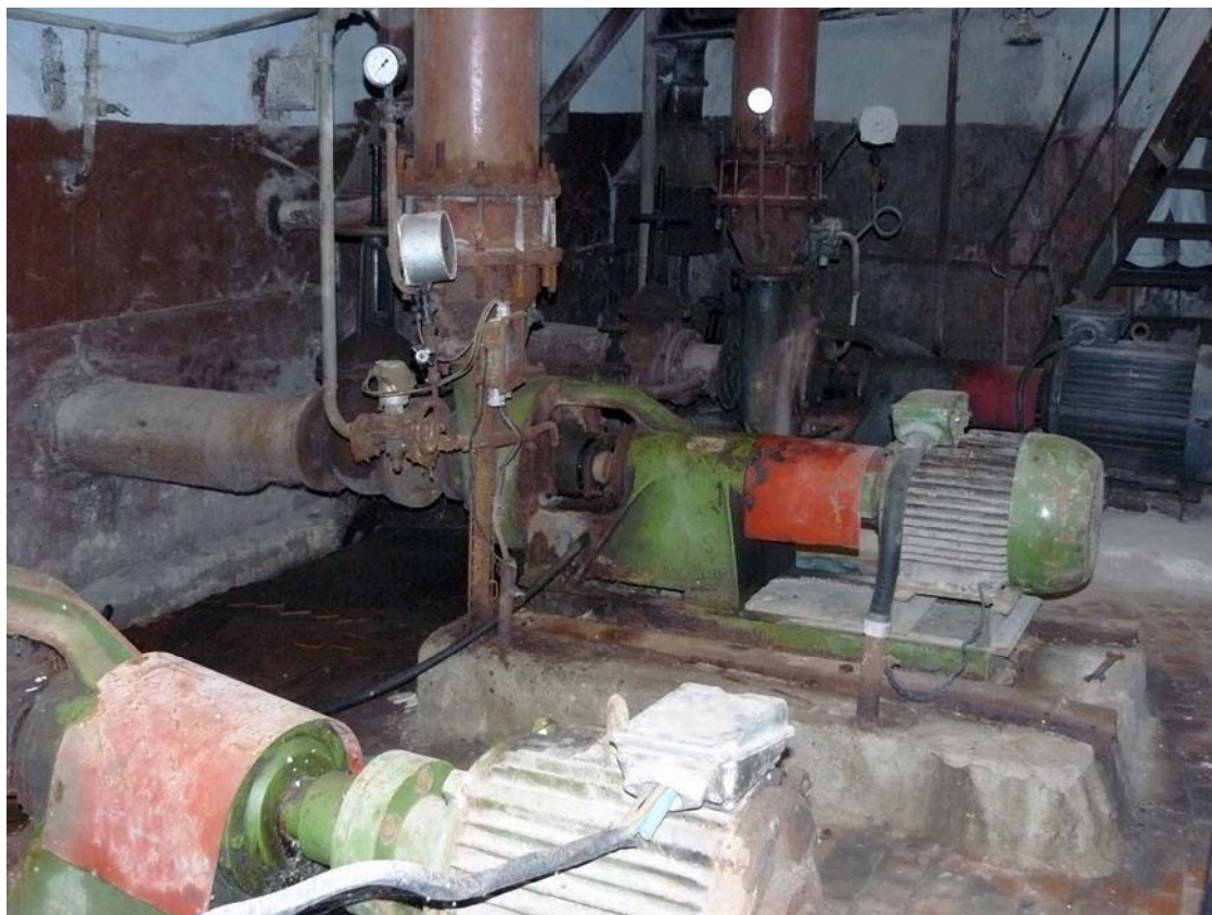
Poza nr.21. Stația raională de pompare a apelor uzate SPC
