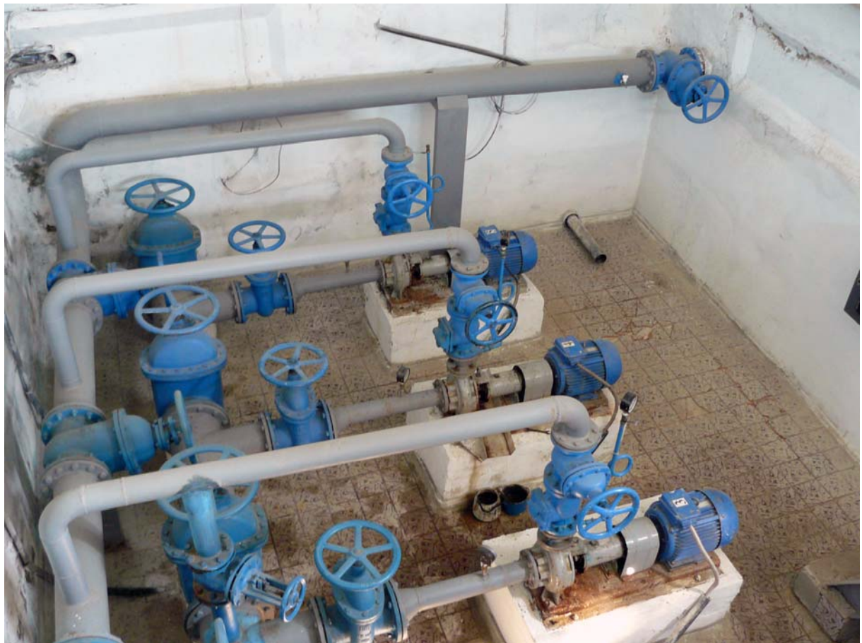
Poza nr.19. Stația de pompare nivelul 3 SP-3 „Combinatul de carne”
