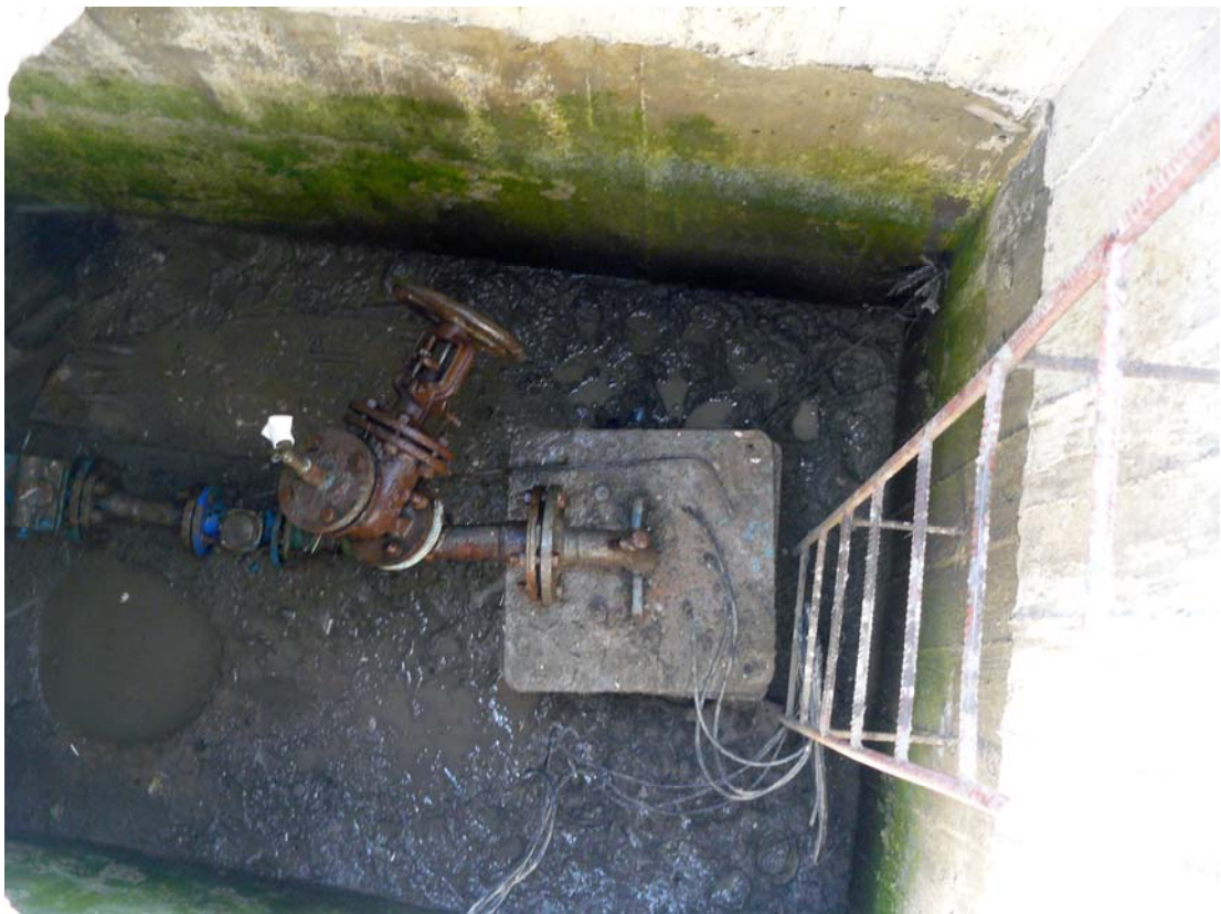
Poza nr.10,nr11. Stația de pompare a apei din puțul nr.11
