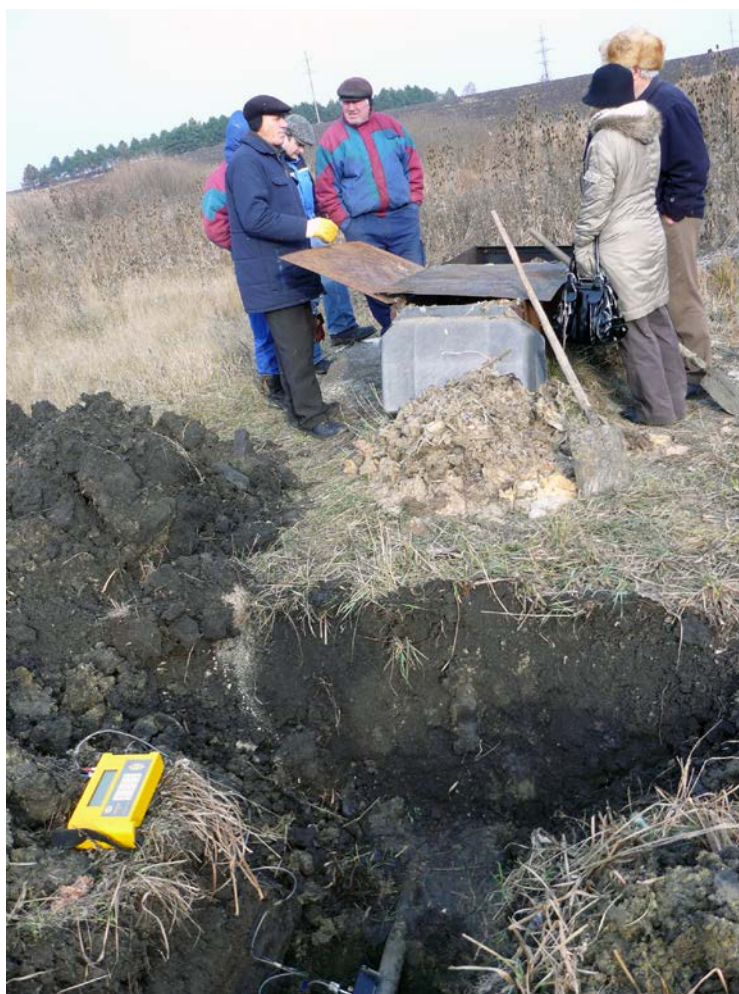
Poza №8-9. Stația de pompare cu puți № 15.
