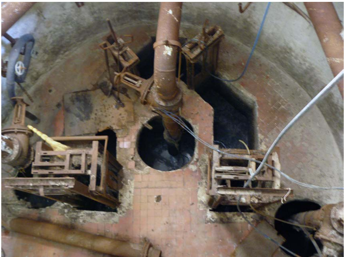
Poza №12-13. Stația de canalizare raională SPCG.
