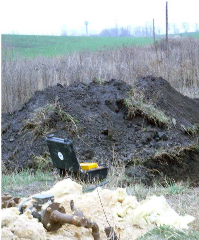
Poza №10. Stația de pompare cu puți № 16.
