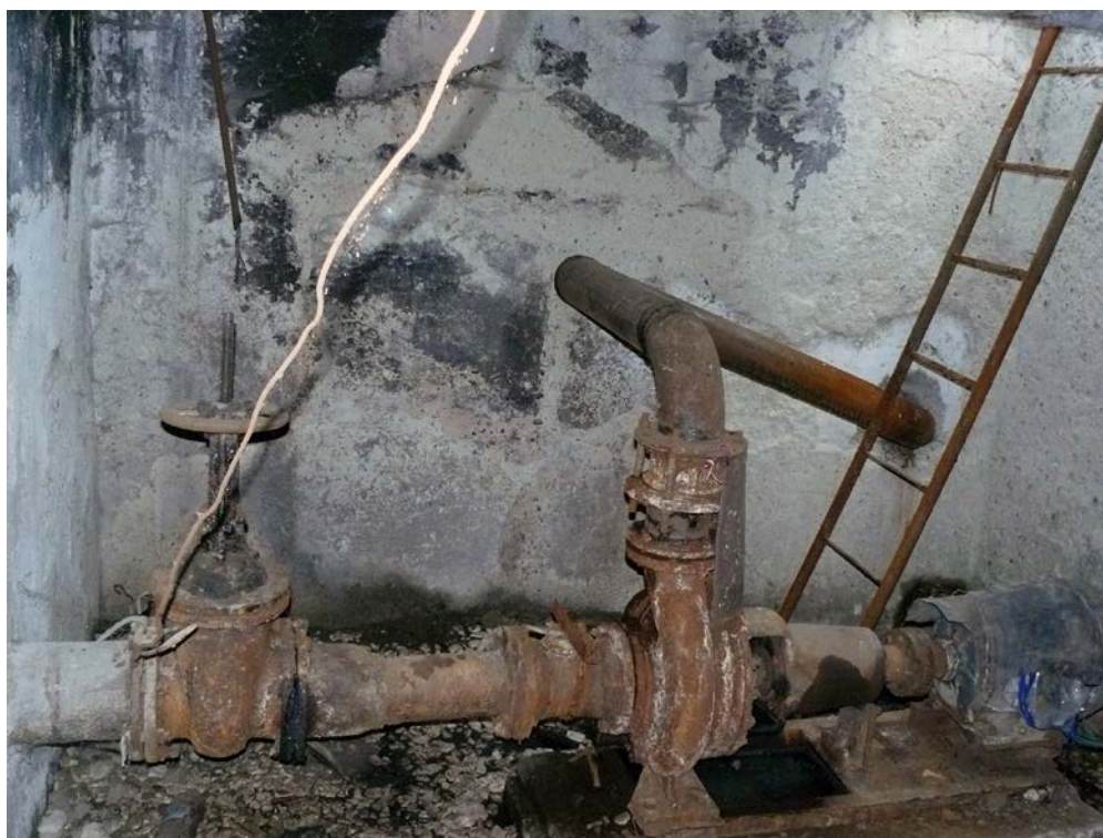
Poza №11. Stația de canalizare raională SPCR.
