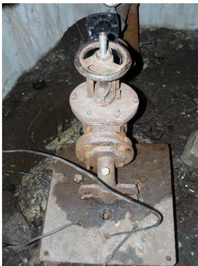
Poza №4-5. Stația de pompare cu puți №5.
