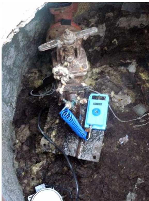
Poza №6-7. Stația de pompare cu puți № 9.
