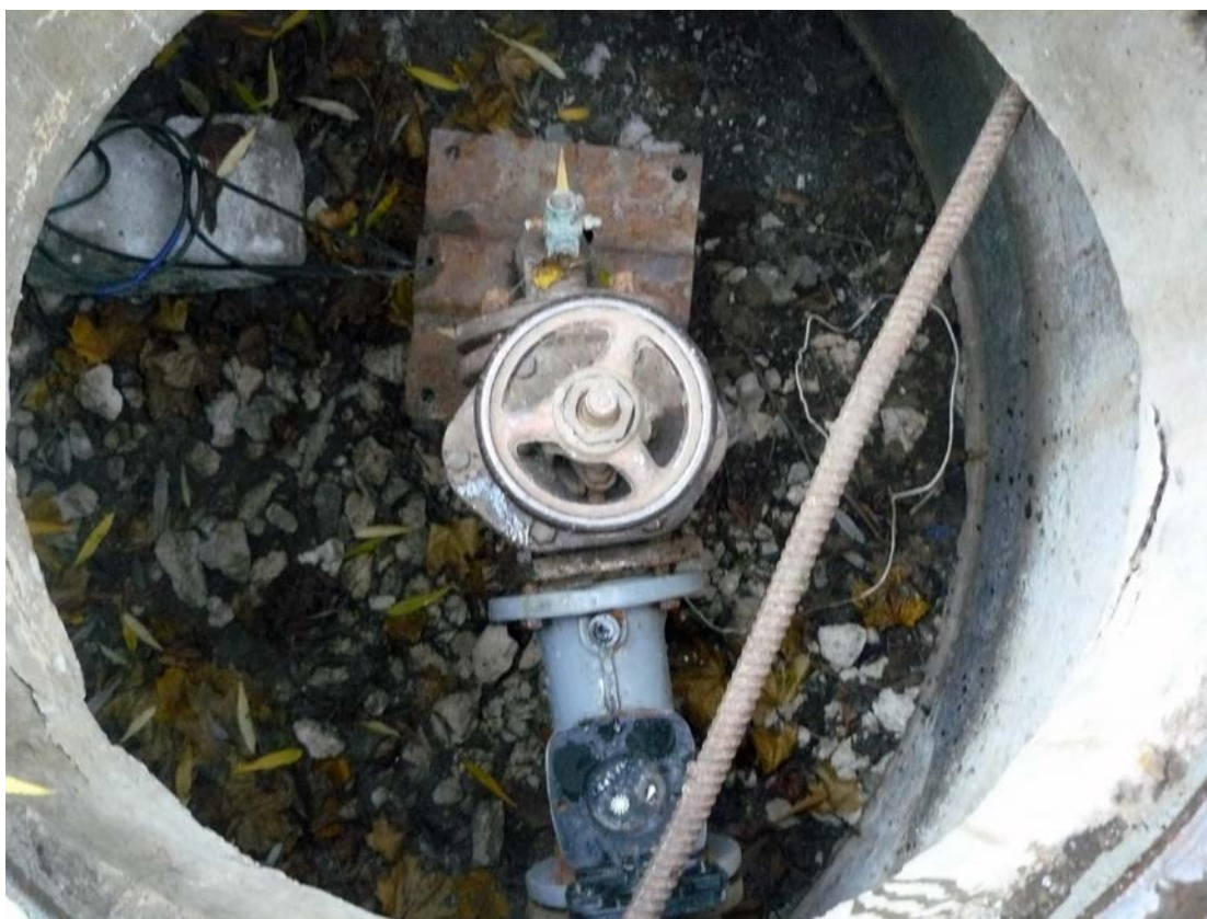
Poza №3. Stația de pompare cu puți №3.
