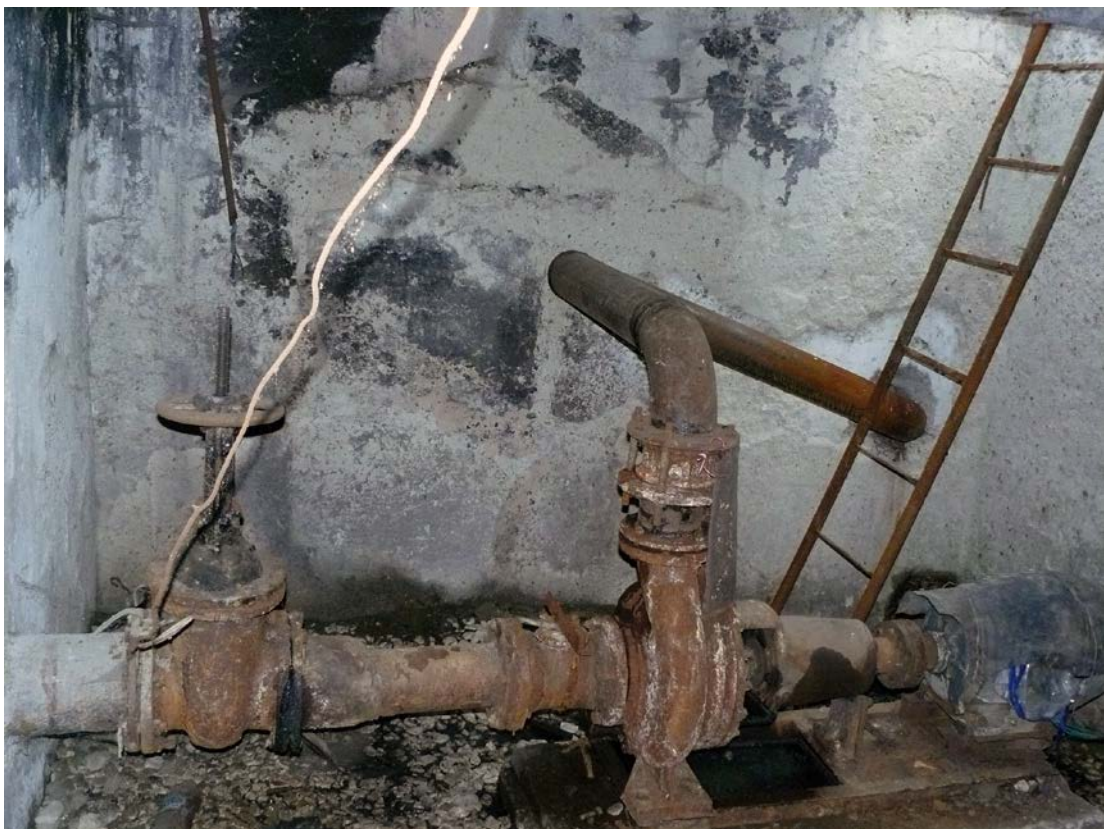
Poza №11. Stația de canalizare raională SRPC.
