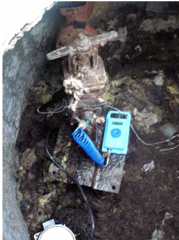
Poza №6-7. Stația de pompare cu puți № 9.
