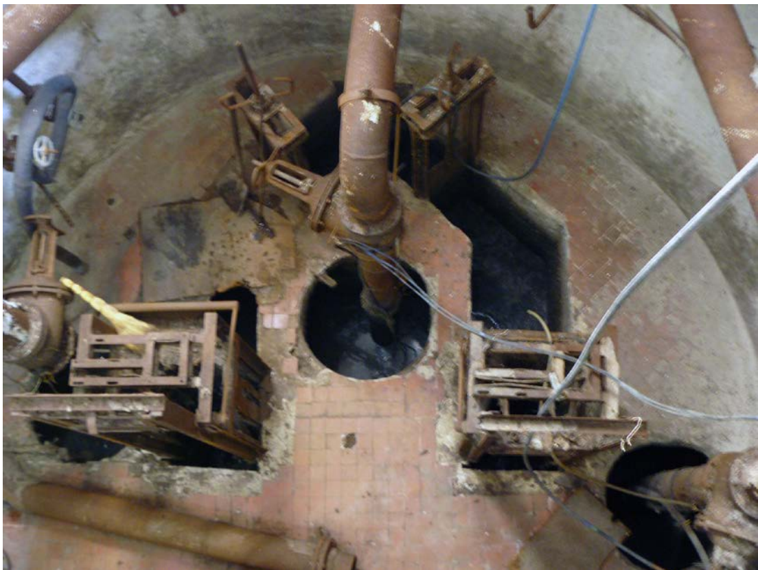
Poza №12-13. Stația de canalizare raională SPPC.
