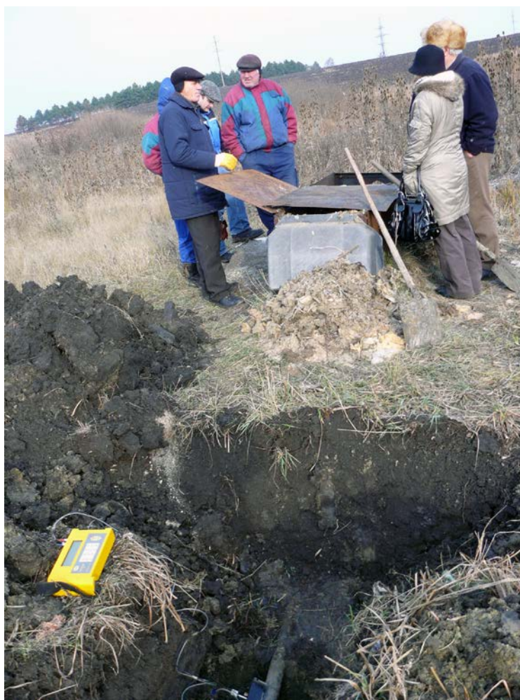
Poza №8-9. Stația de pompare cu puți № 15.
