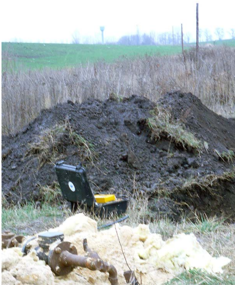
Poza №10. Stația de pompare cu puți № 16.
