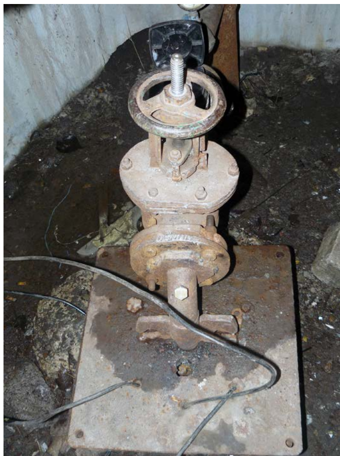
Poza №4-5. Stația de pompare cu puți №5.
