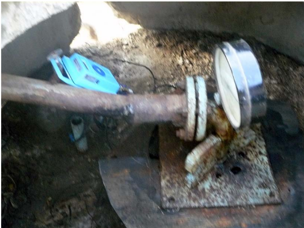
Poza №6-7 . Stația de pompare cu puți №5.
