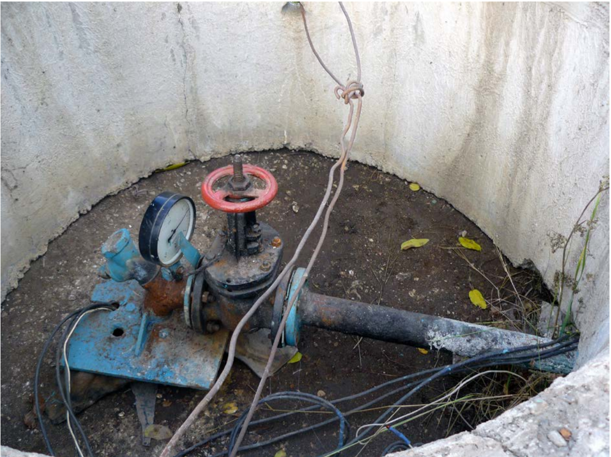
Poza №10-11. Stația de pompare cu puți № 12.
