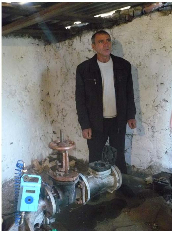
Poza №5 . Stația de pompare cu puți №4
