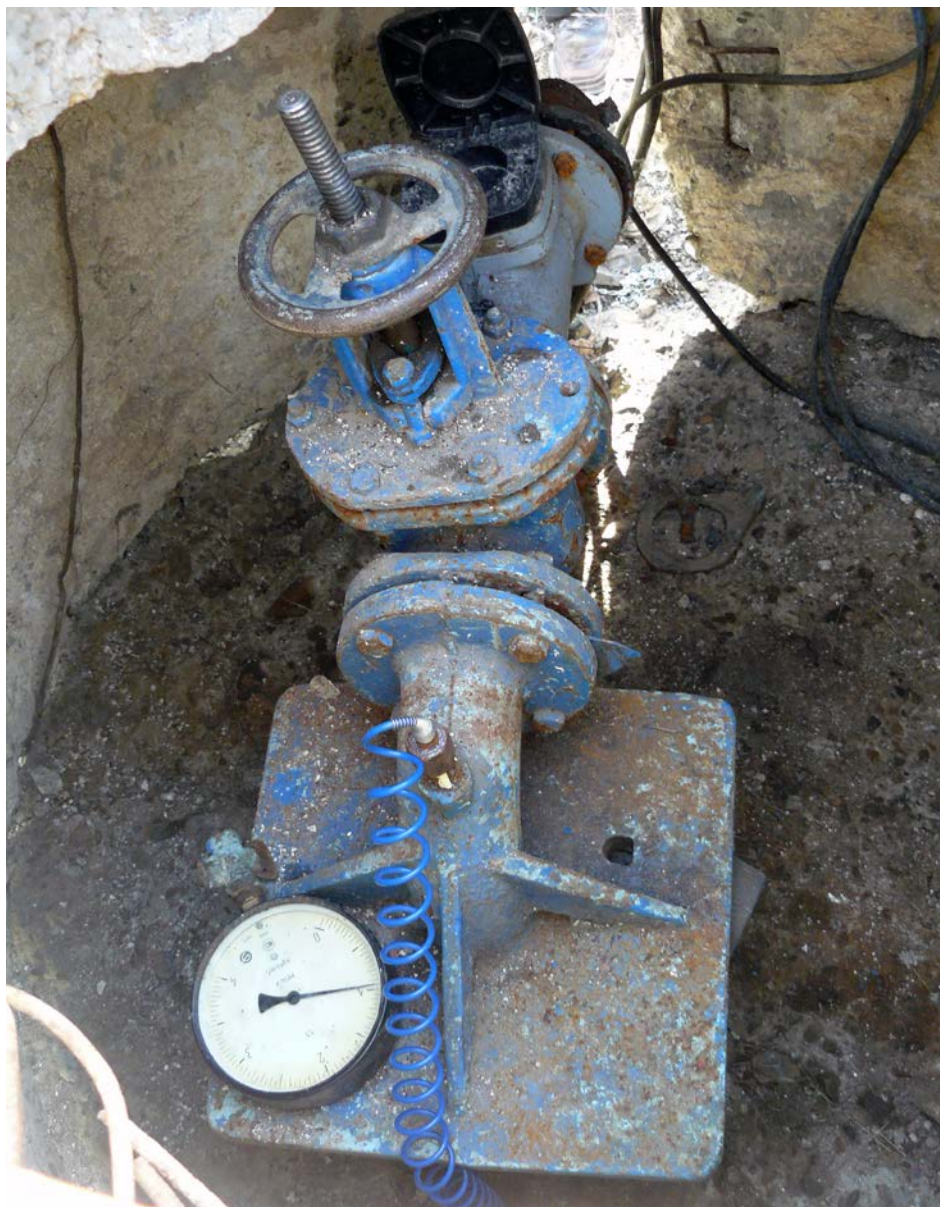
Poza №9 . Stația de pompare cu puți № 7.
