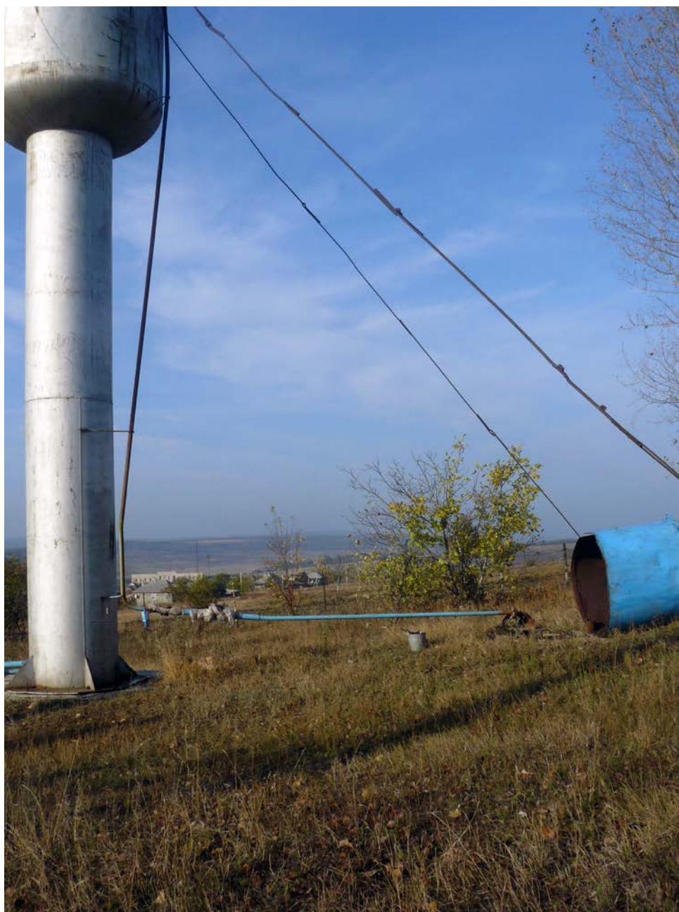
Poza №8. Stația de pompare cu puți № 6.
