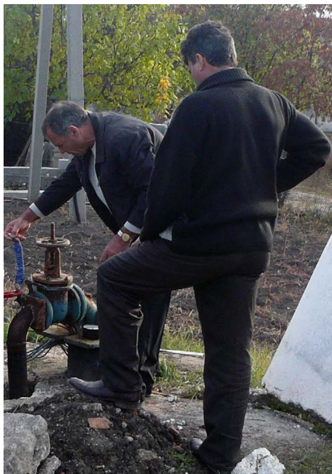
Poza №1. Stația de pompare cu puți №1.
