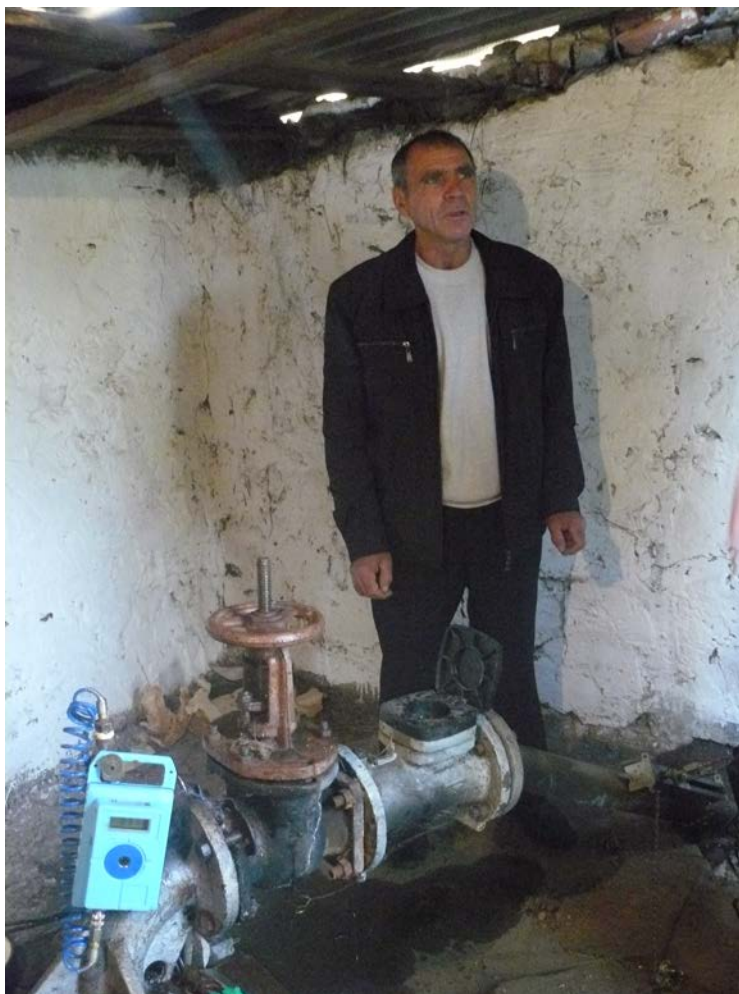
Poza №5 . Stația de pompare cu puți №4
