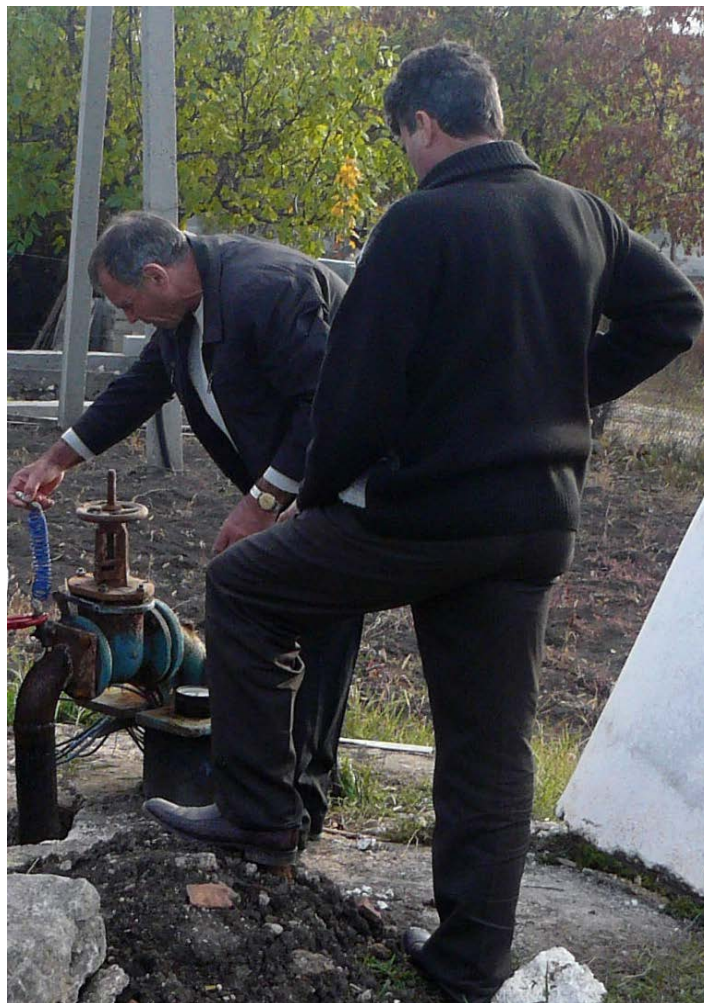
Poza №1. Stația de pompare cu puți №1.
