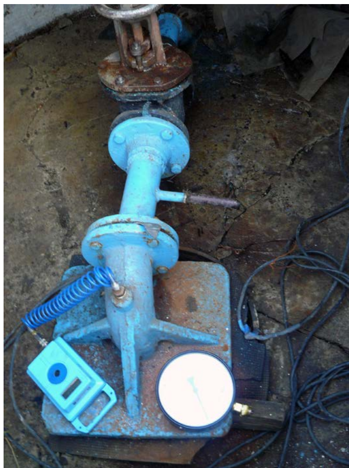
Poza №4 . Stația de pompare cu puți №3.
