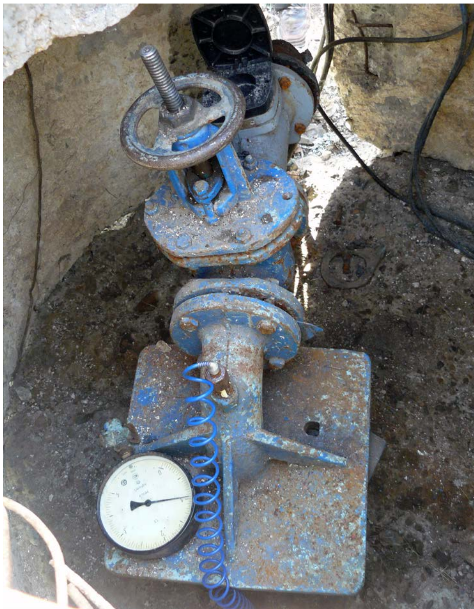
Poza №9. Stația de pompare cu puți № 7.
