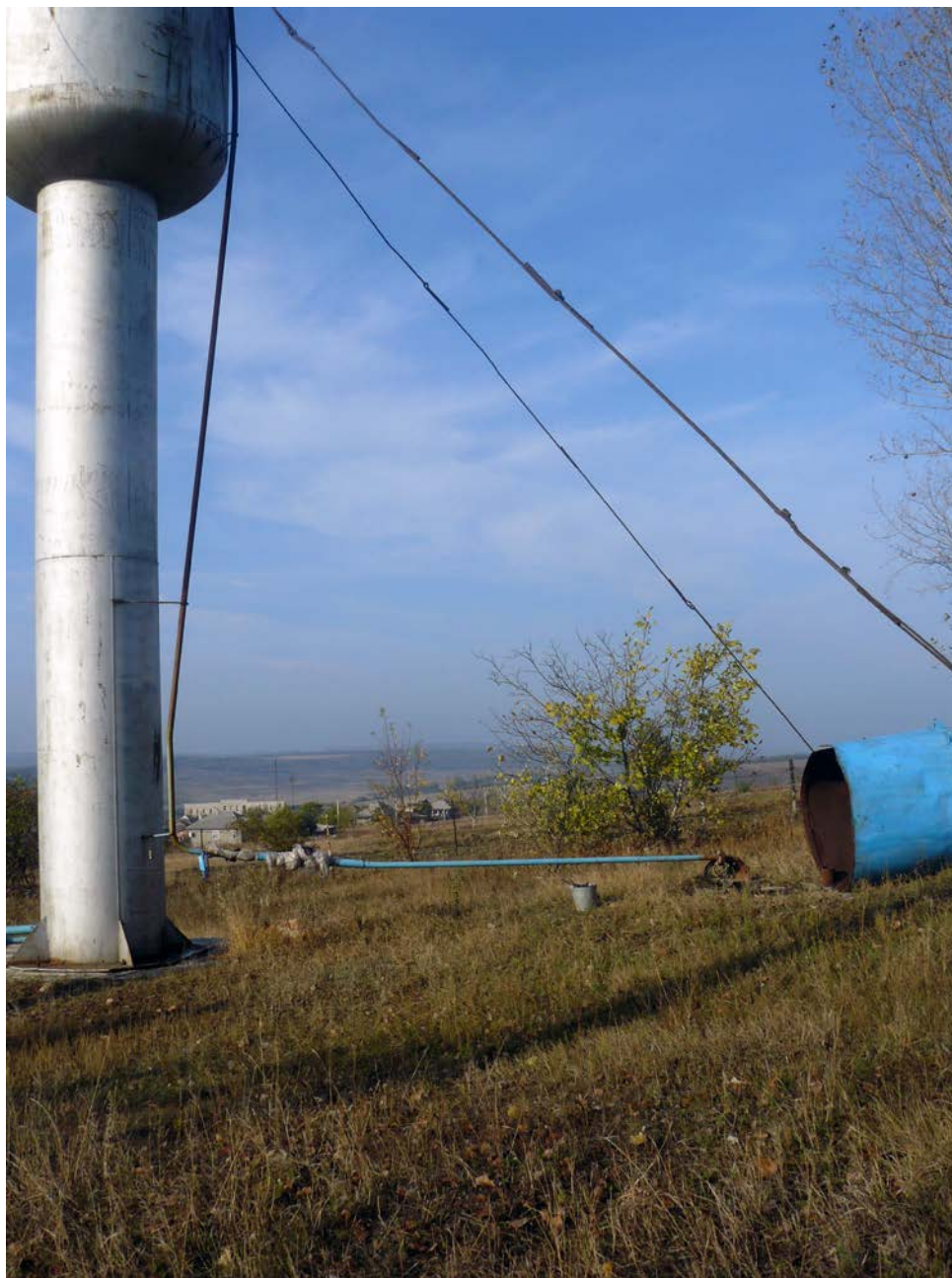
Poza №8. Stația de pompare cu puți № 6.
