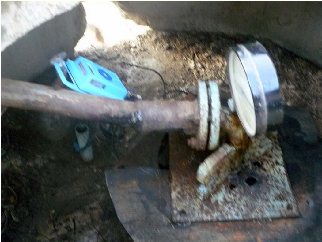
Poza №6-7 . Stația de pompare cu puți №5.
