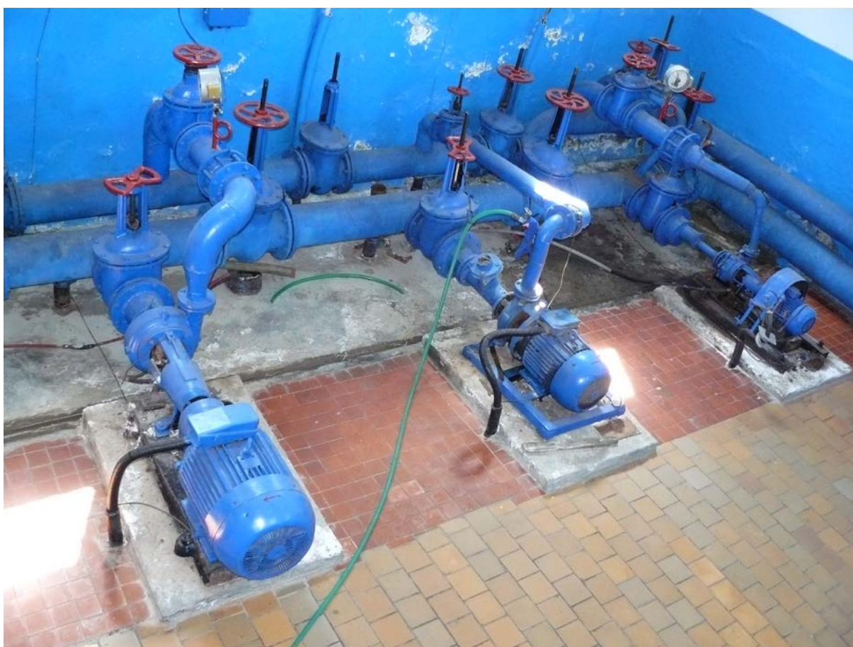
Poza № 6. Stația de pompare treapta II (SP-II)
