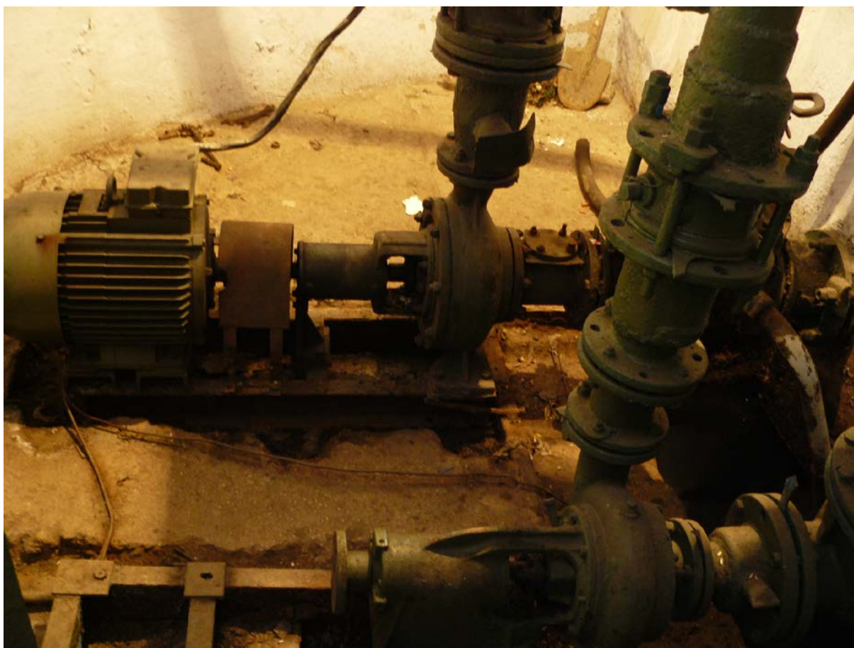
Poza № 7. Stația de canalizare № 1(SPC 1)
