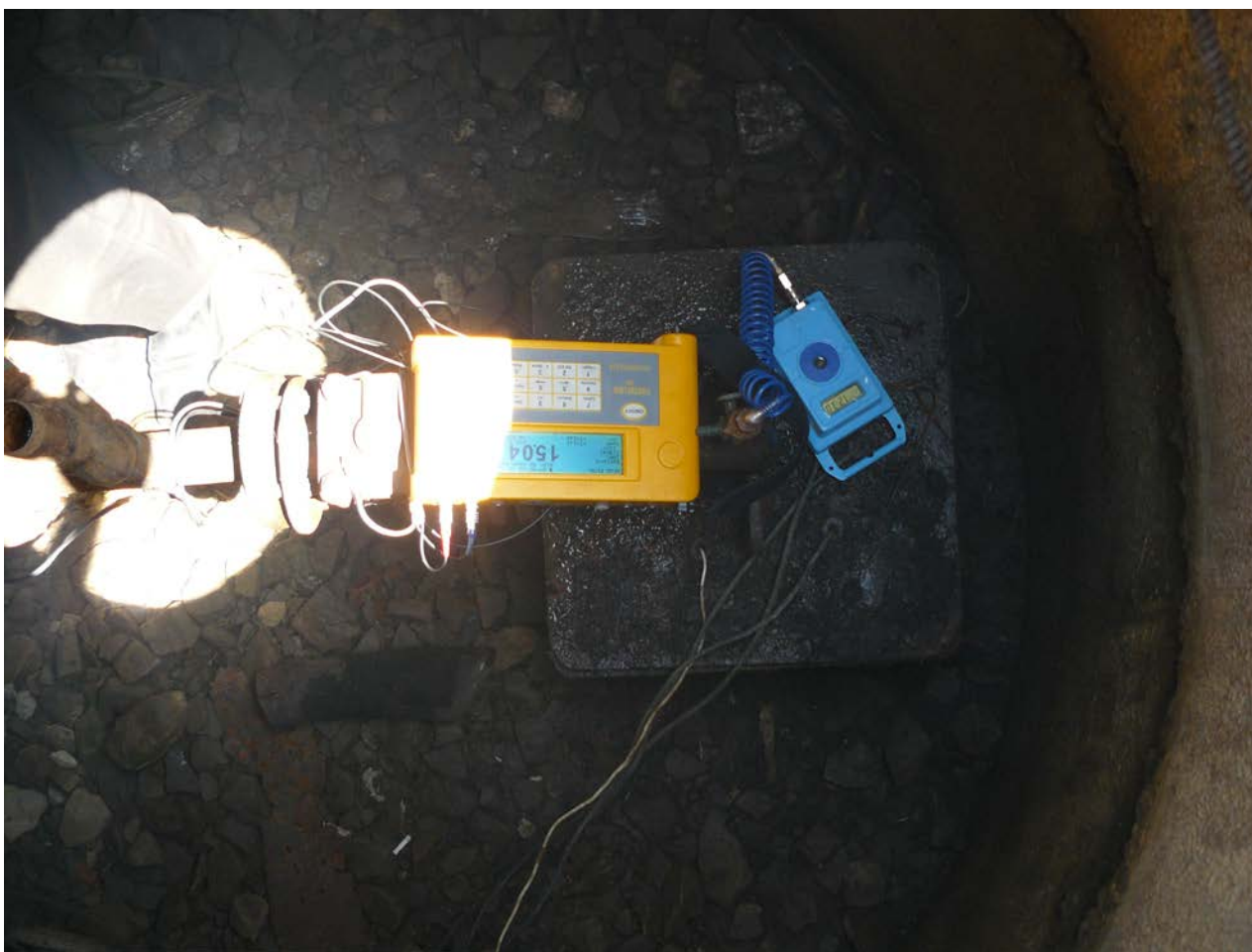
Poza №2. Stația de pompare cu puț №4
