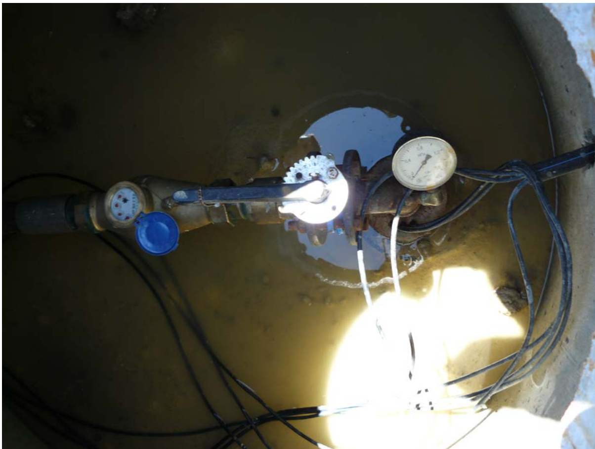
Poza №5. Stația de pompare cu puț № 11
