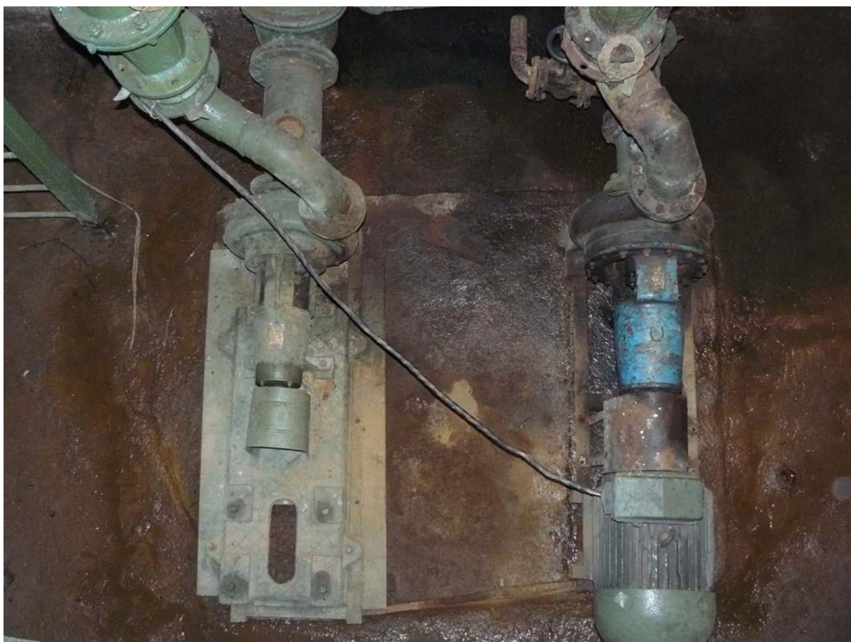
Poza № 9. Stația de canalizare № 4 (SPC 4)
