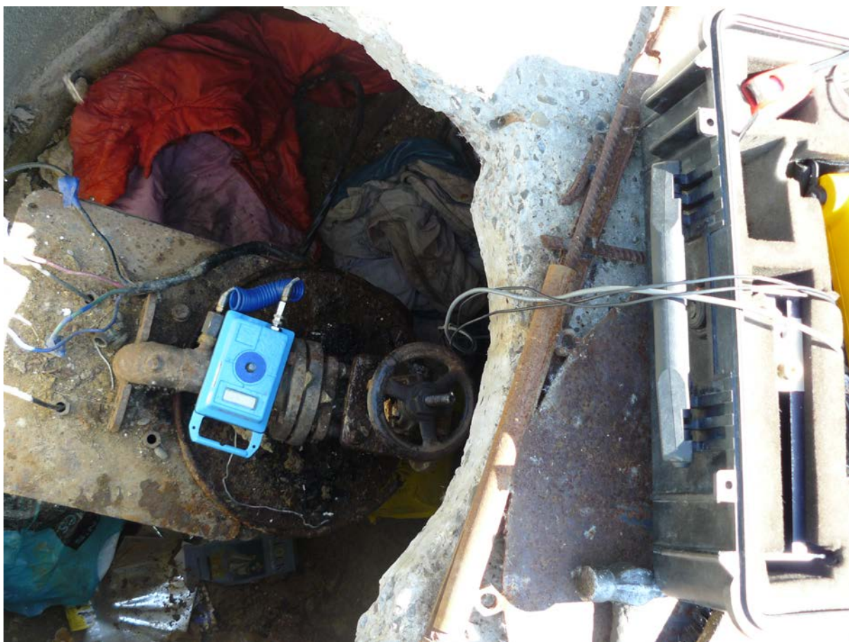
Poza №1. Stația de pompare cu puț №1
