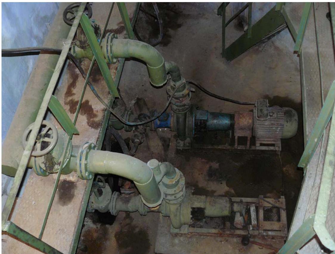
Poza №8. Stația de canalizare № 3 (SPC 3)
