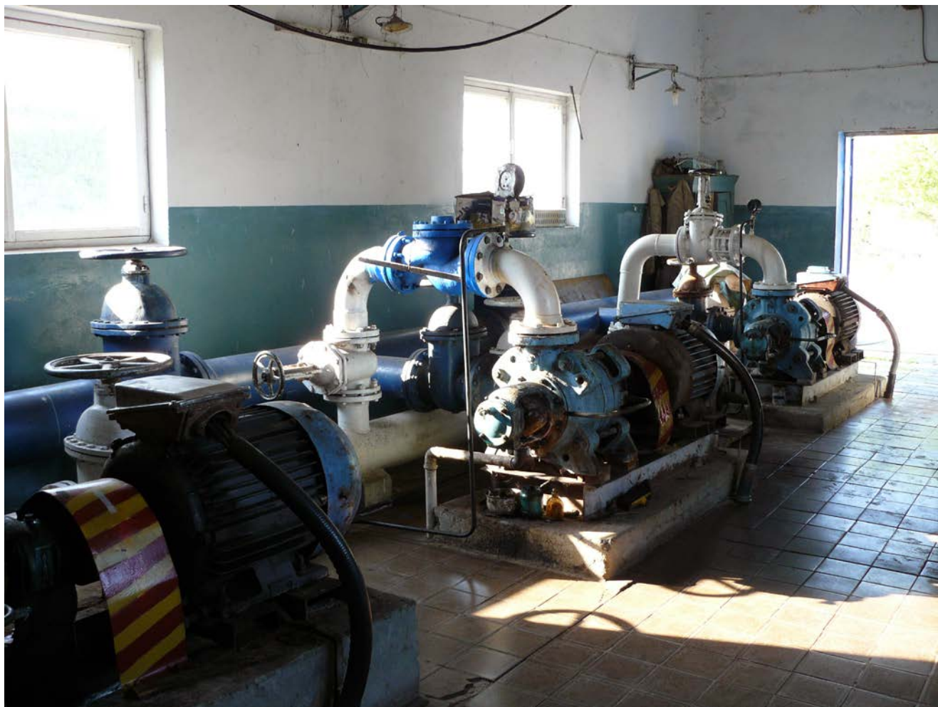
Фото № 3. Насосная станция II-го подъема.
