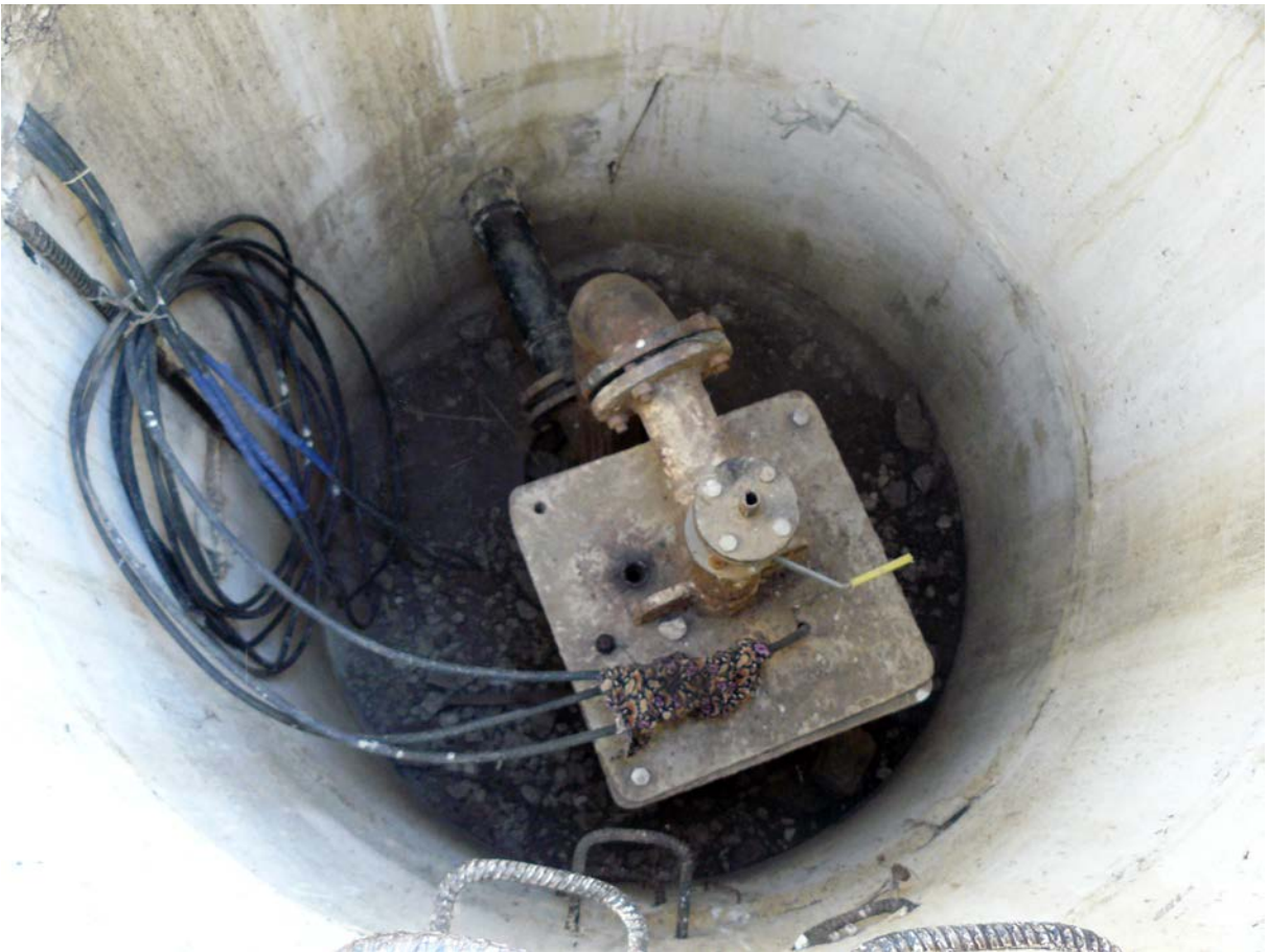
Фото №1-№ 2. Насосная станция над артскважиной.
