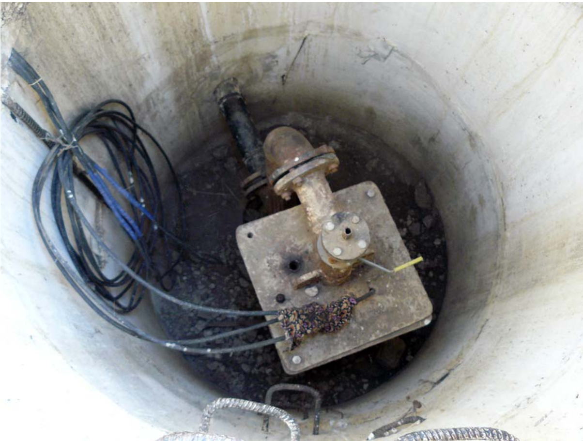
Poza №1-№2. Stația de pompare cu puț
