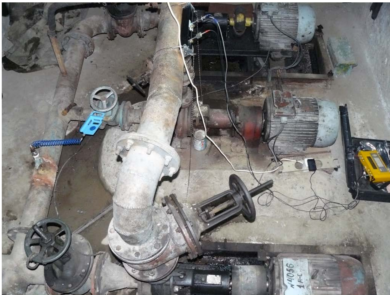
Poza №4. Stația de pompare SP-II.
