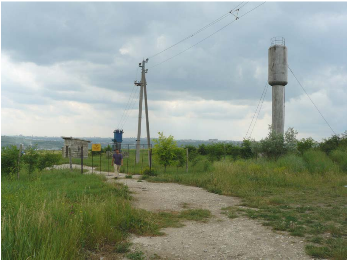
Foto № 1. Vederea principală a stației de pompare cu puț №1
