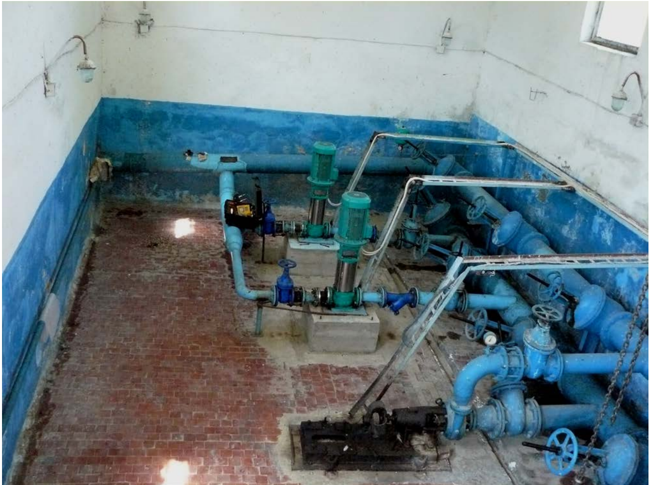
Foto 3. Stația de pompare SP-II.
