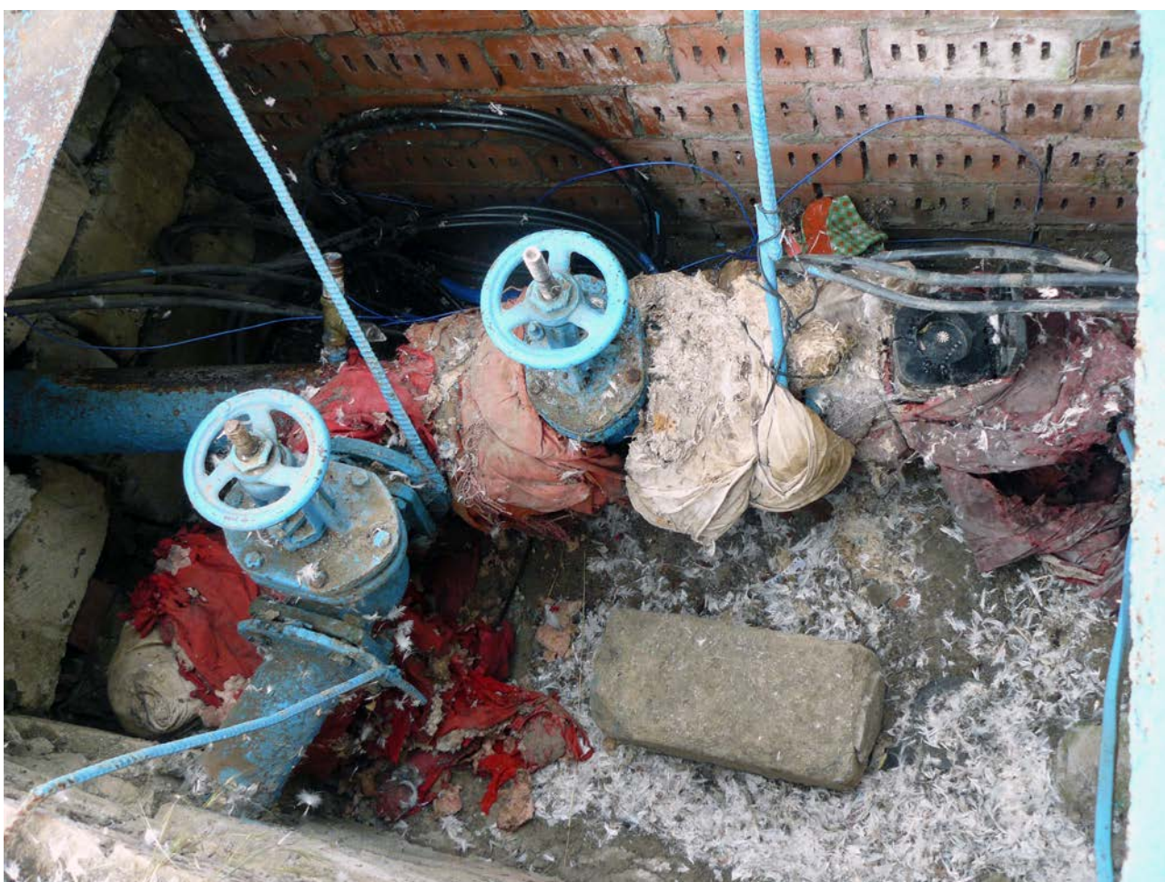
Foto 4. Stația de pompare cu puț № 1
