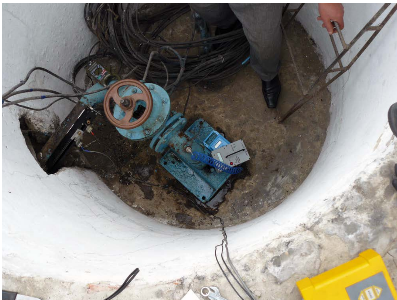
Foto 7. Stația de pompare cu puț № 9
