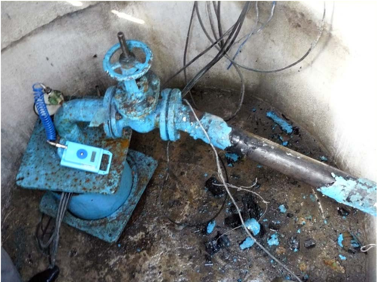
Foto 2. Stația de pompare cu puț № 4
