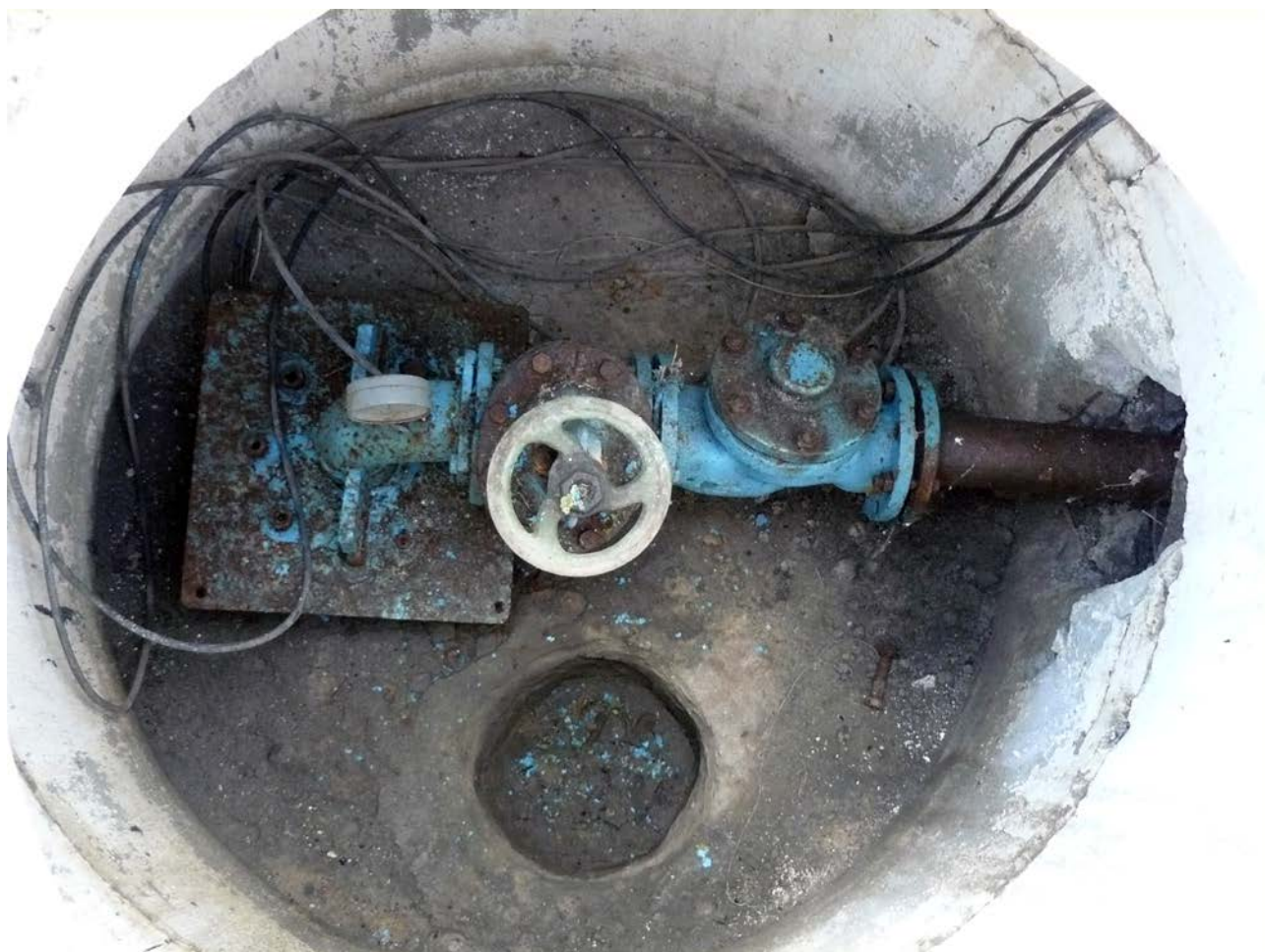
Foto 1. Stația de pompare cu puț № 3
