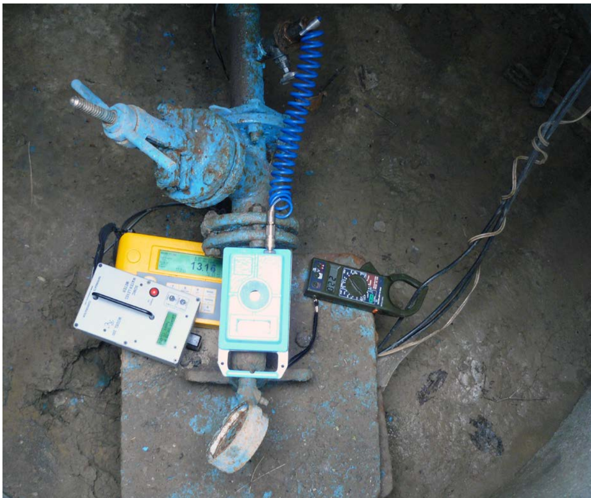
Foto 6. Stația de pompare cu puț № 2
