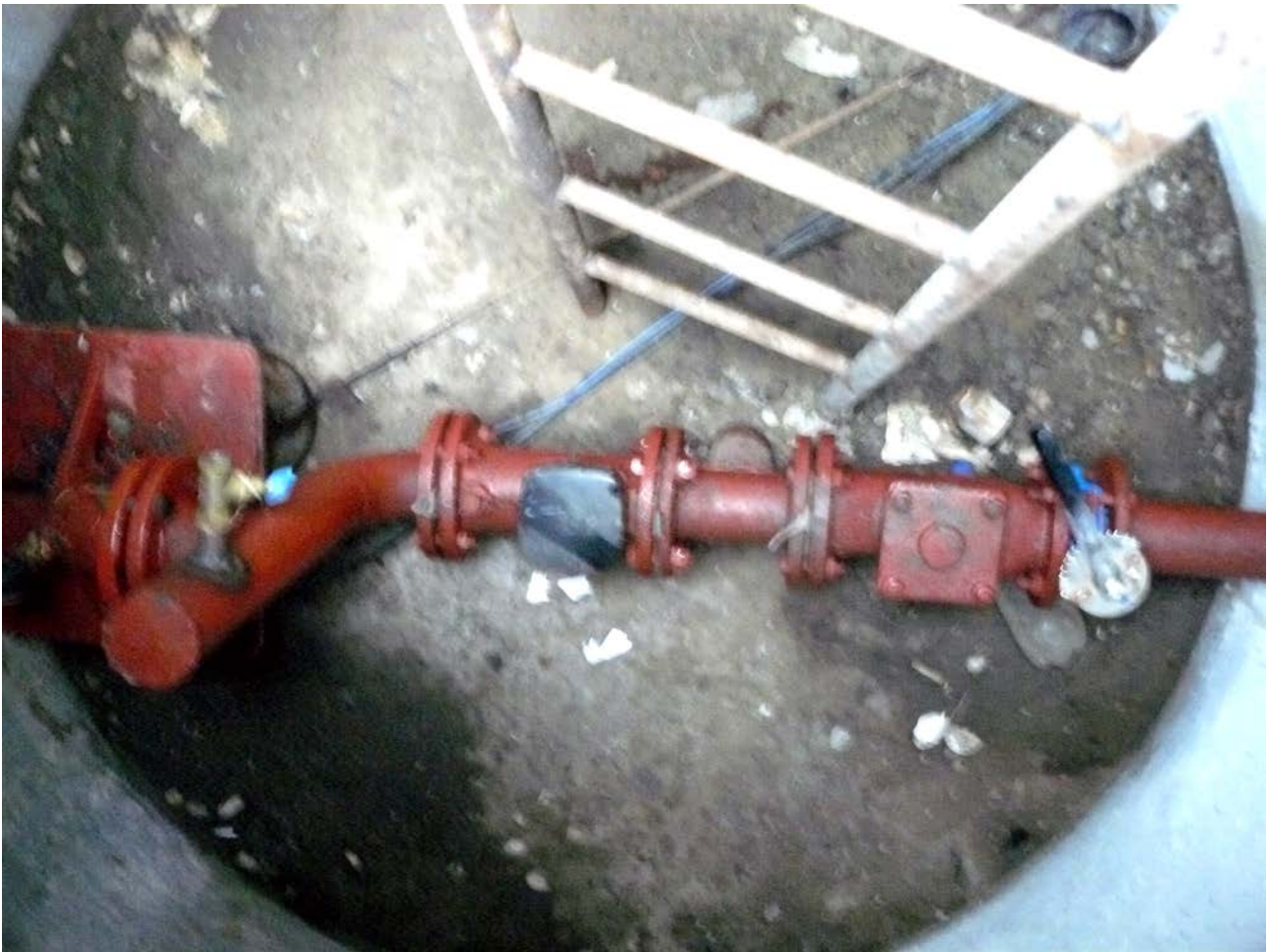
Foto 8. Stația de pompare cu puț № 10
