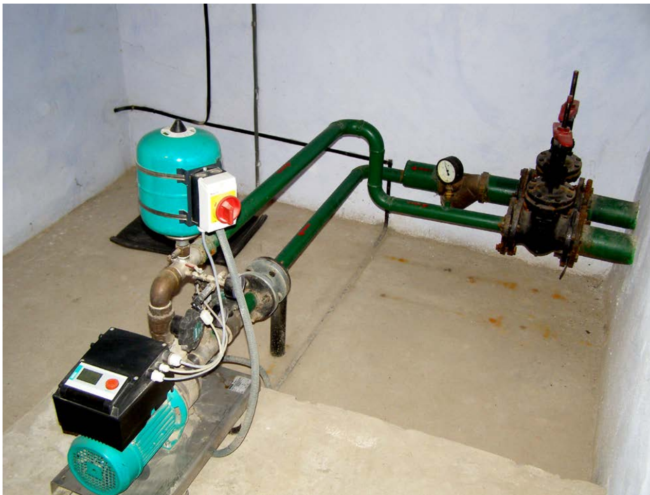
Фото 9. Повысительная водопроводная насосная станция «Унгуриану - 7».
