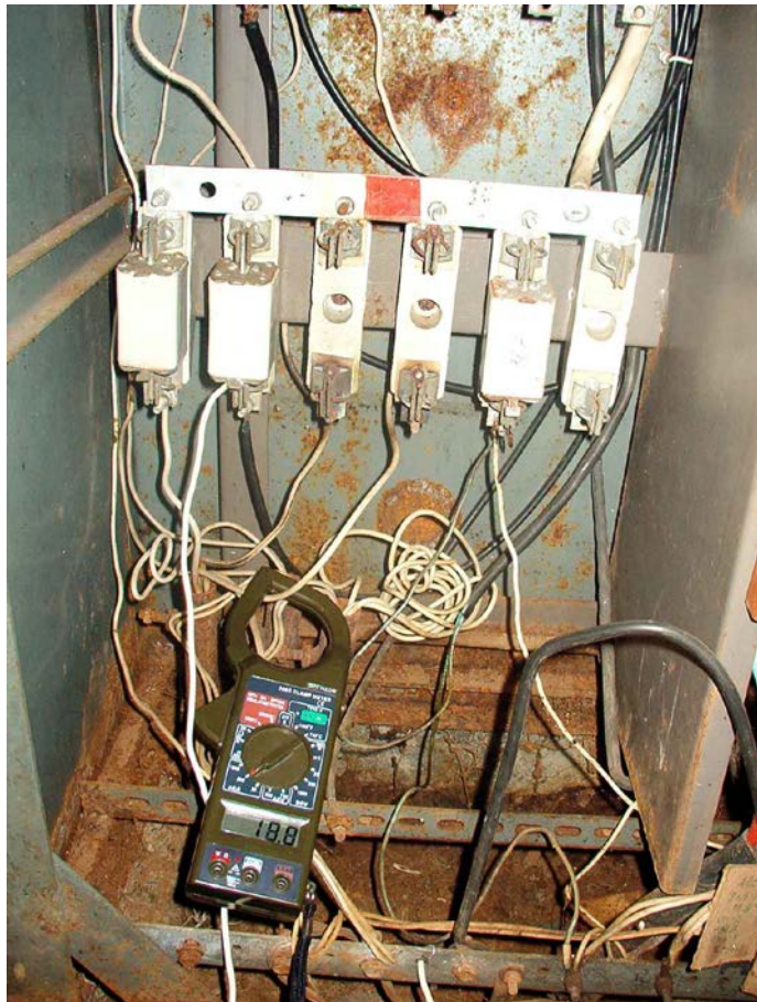
Фото 2. Замеры напряжения и силы тока в распределительном щите насосной станции.
