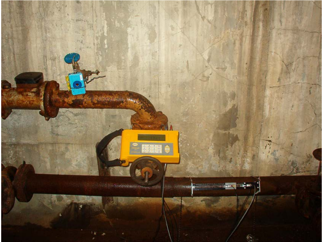
Фото1. Замеры давления и расхода воды в напорном трубопроводе насосной станции
