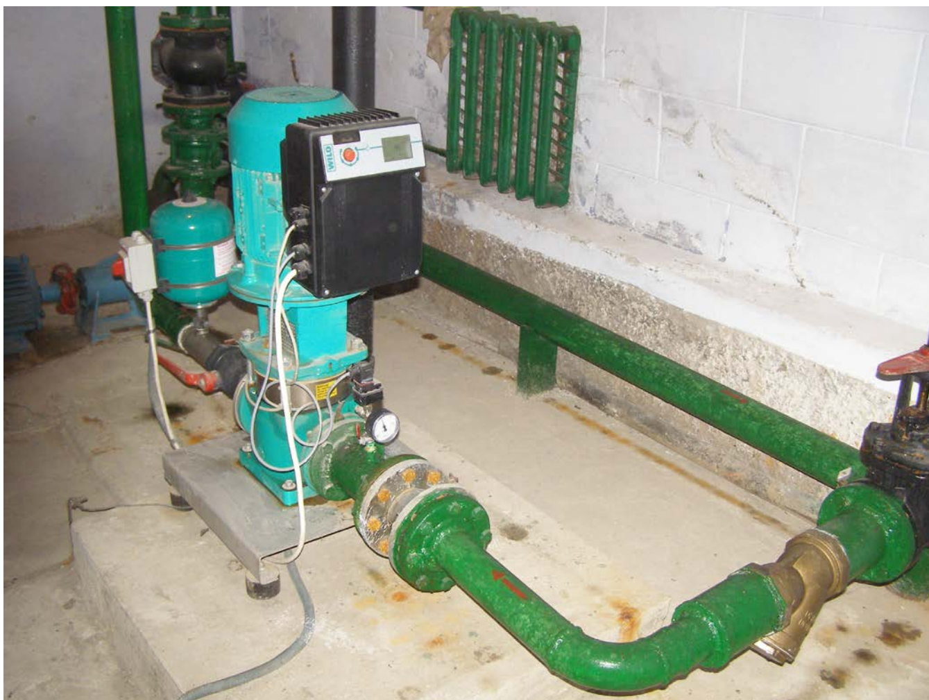
Фото 8. Повысительная водопроводная насосная станция «Бойко-7».
