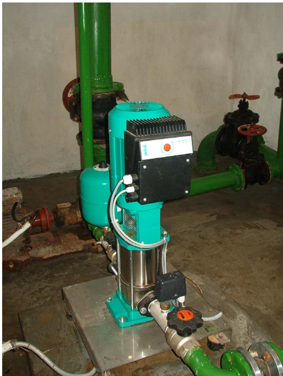
Фото 6. Повысительная водопроводная насосная станция «Романэ-26».
