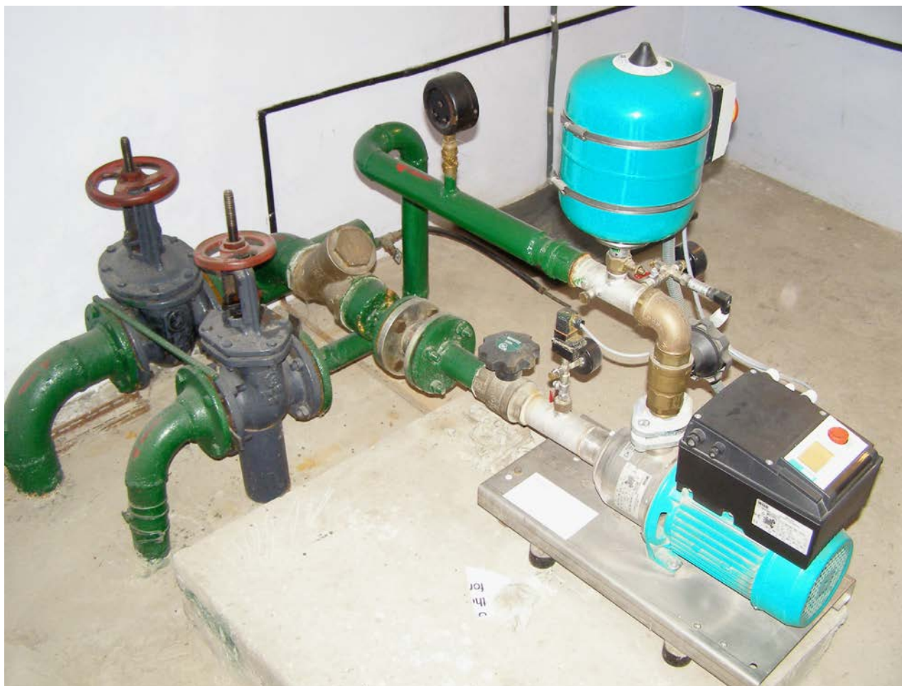
Фото 10. Повысительная водопроводная насосная станция «Порумбеску - 3».
