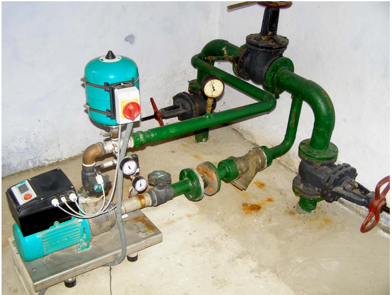
Фото 11. Повысительная водопроводная насосная станция «Дечебал-64» («Романэ-66»).
