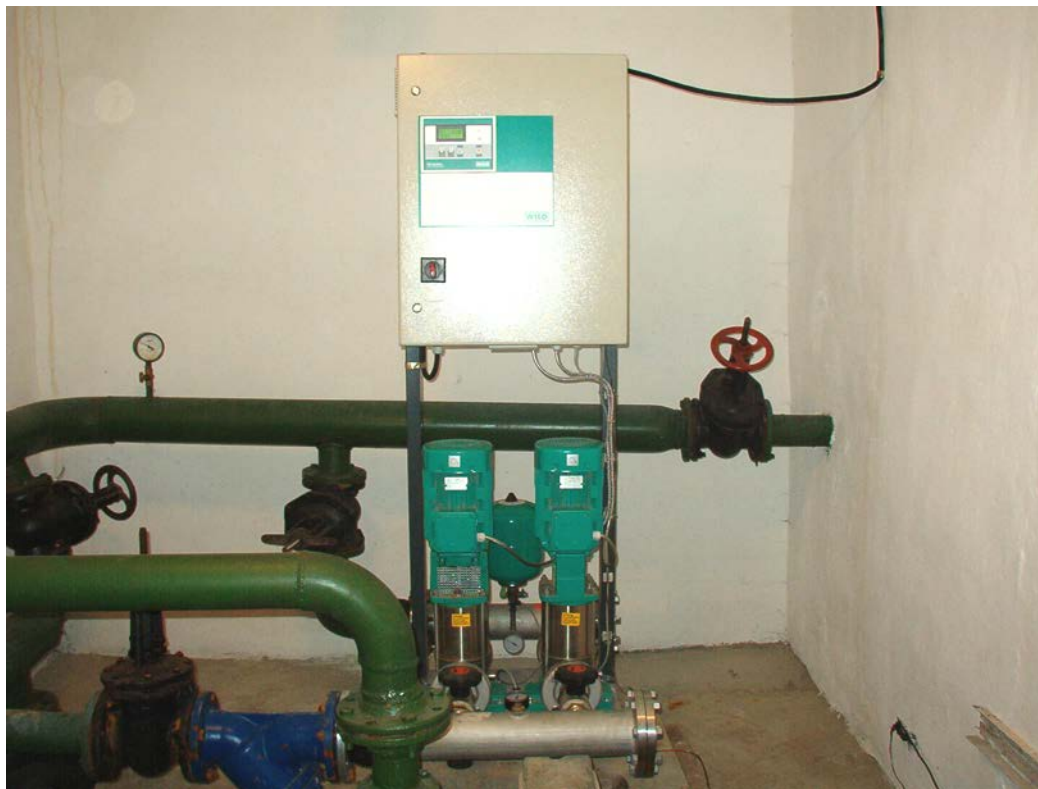
Фото 7. Повысительная водопроводная насосная станция «Кристюк-11».
