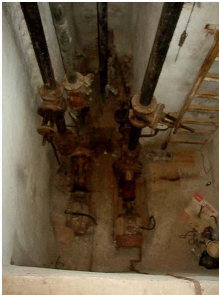
Foto 3. Stația de pompare de canalizare „Ungureanu – 15”
