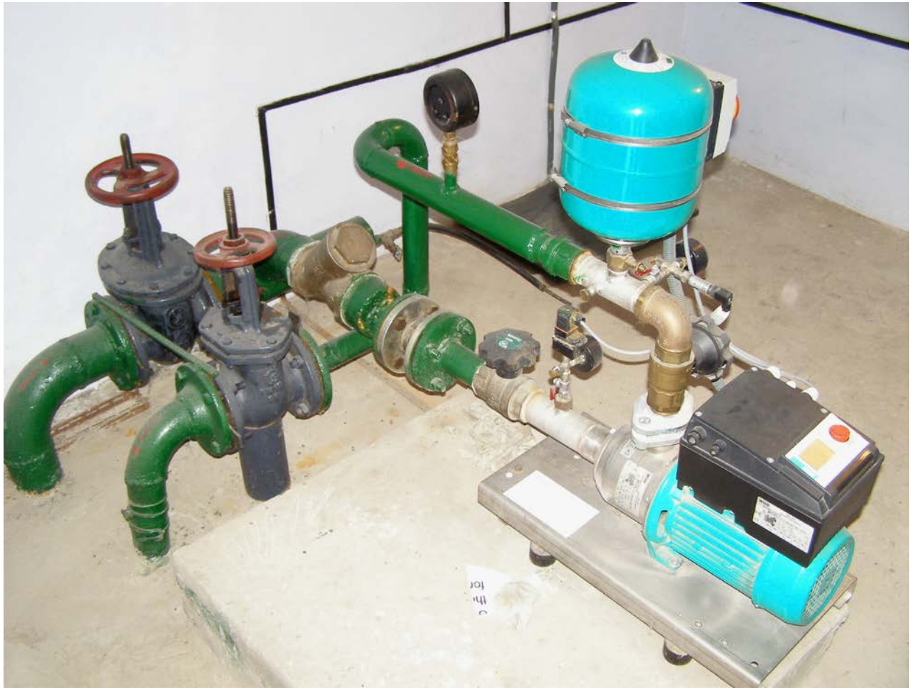
Foto 10. Stația de pompare de ridicare a presiunii „Porumbescu-3”.
