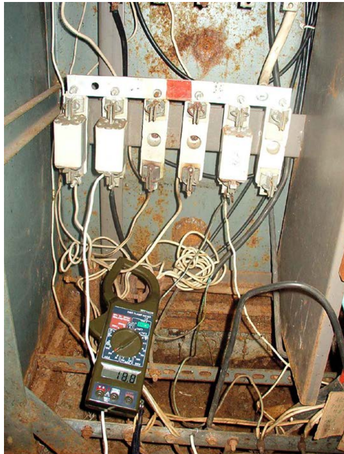
Foto2. Măsurarea tensiunii și curentului în panoul de distribuție a stațiilor de pompare
