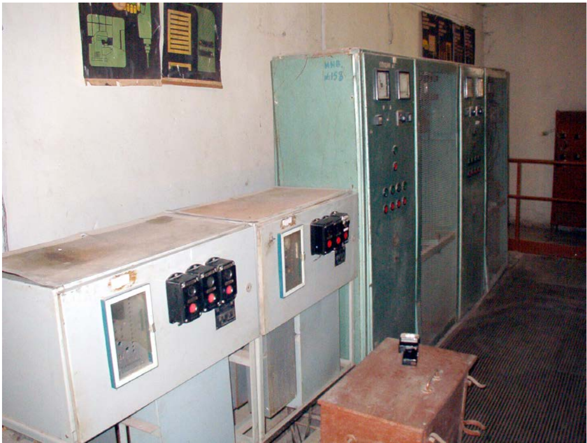
Foto №4-5 . Stația de pompare principală SPPC . Camera de panouri 0.4 kV.
