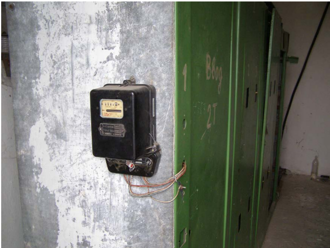
Foto №8-9 . Stația de pompare str. Caragiali .Camera de panouri 0.4 kV.
