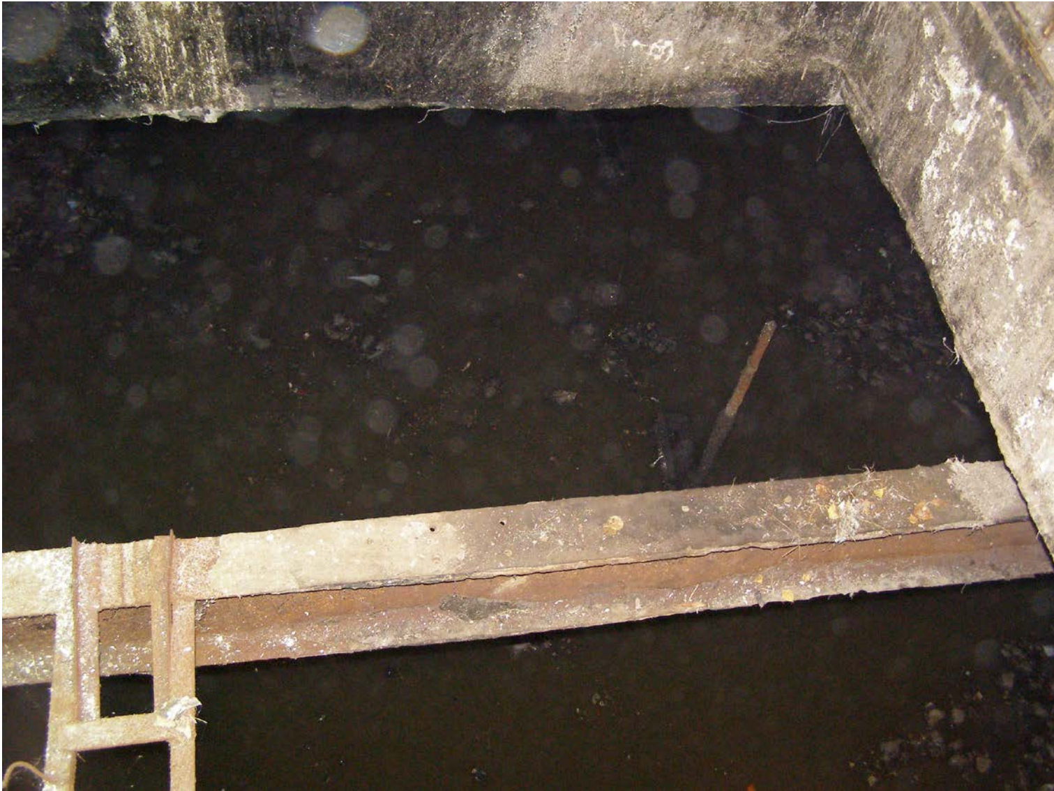
Foto №3. SPPC. Stația de pompare principală . Sala cu gratare .
