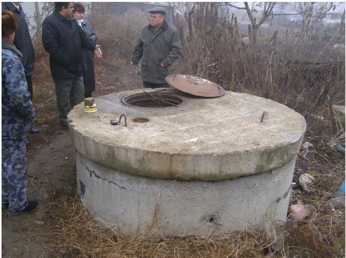
Foto № 6-7. SPPC. Stația de pompare str. Caragiali .
