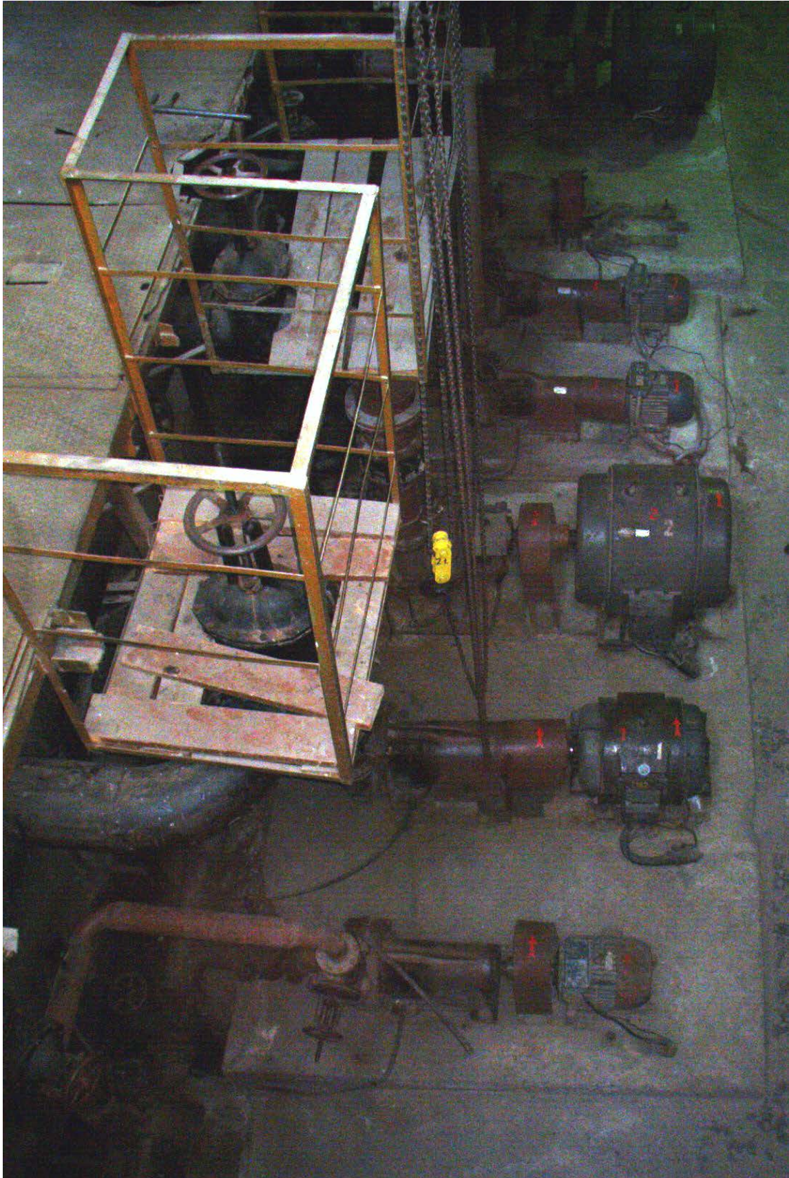
Foto №1. SPPC. Stația de pompare principală . Sala de mașini
