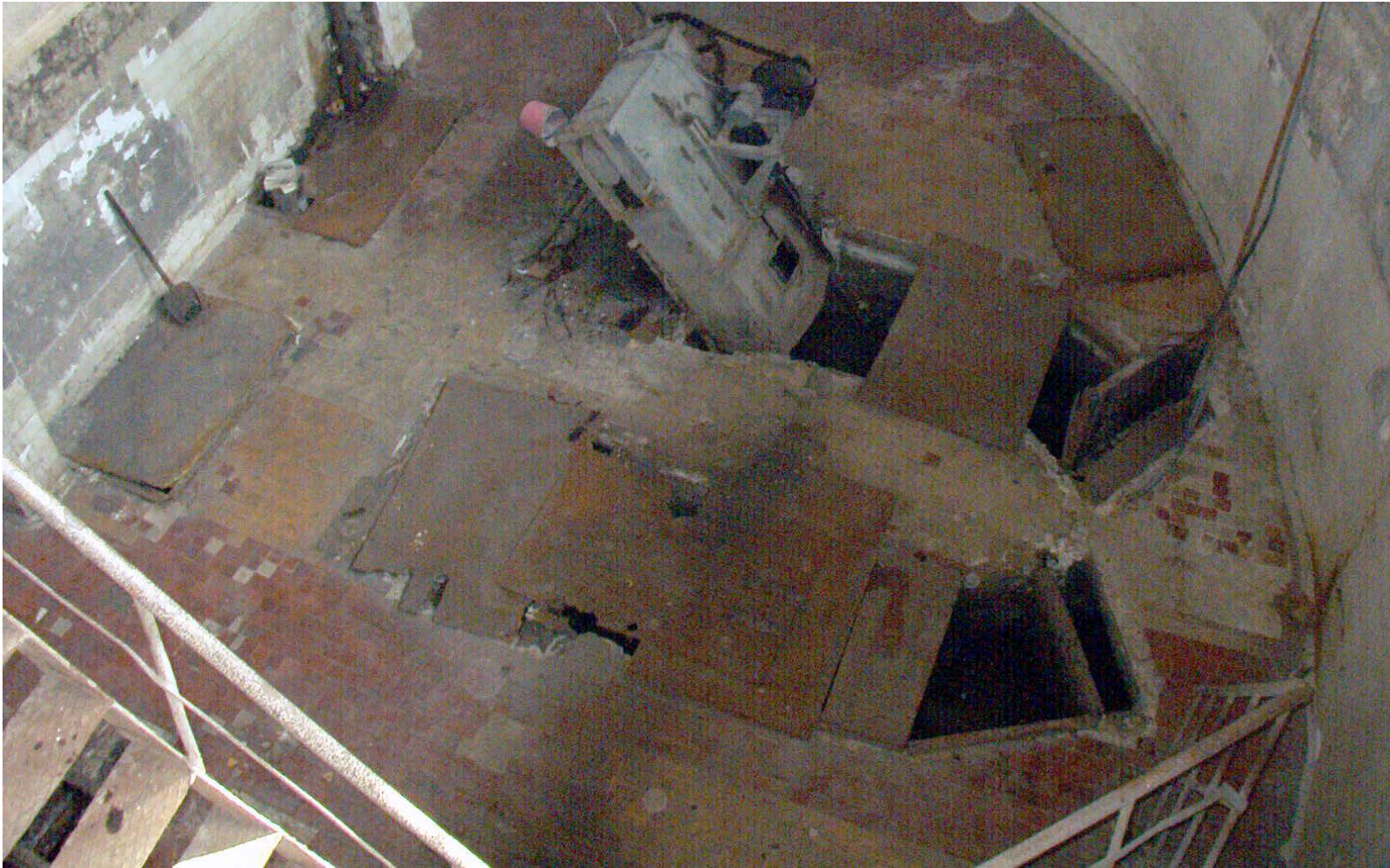
Foto №4 . SPP. Stația de pompare principală .Cameră cu gratar .
