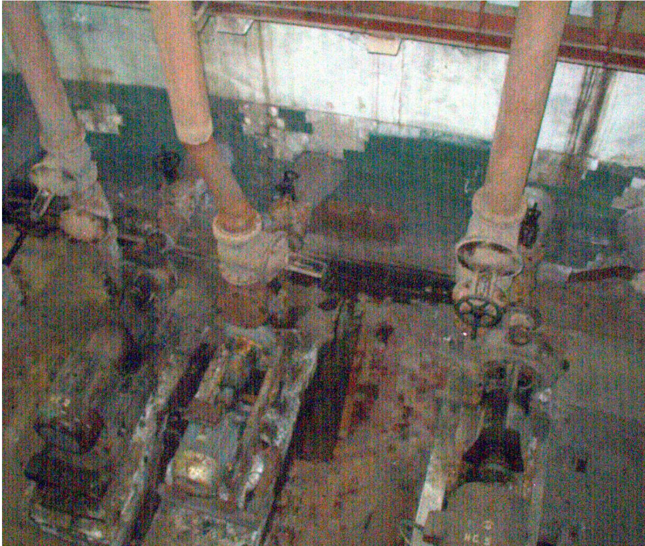
Foto №3 . SPP. Stația de pompare principală . Sala de mașini .
