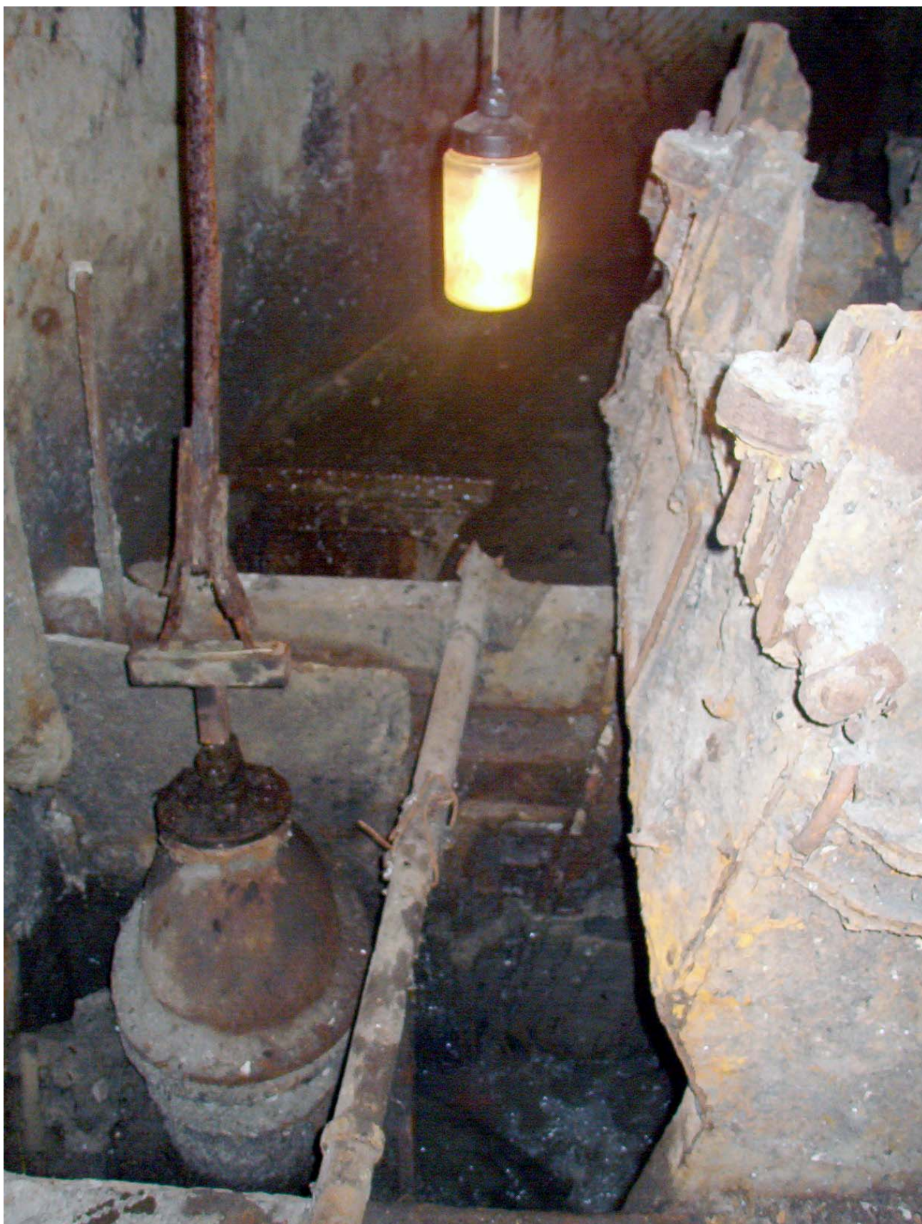
Foto №2 . SPR. Stația de pompare raională . Cameră cu gratar .
