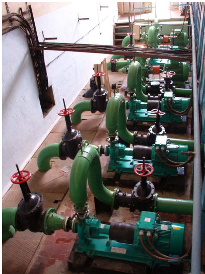
Фото 5. Насосная станция II-го подъема после модернизации
