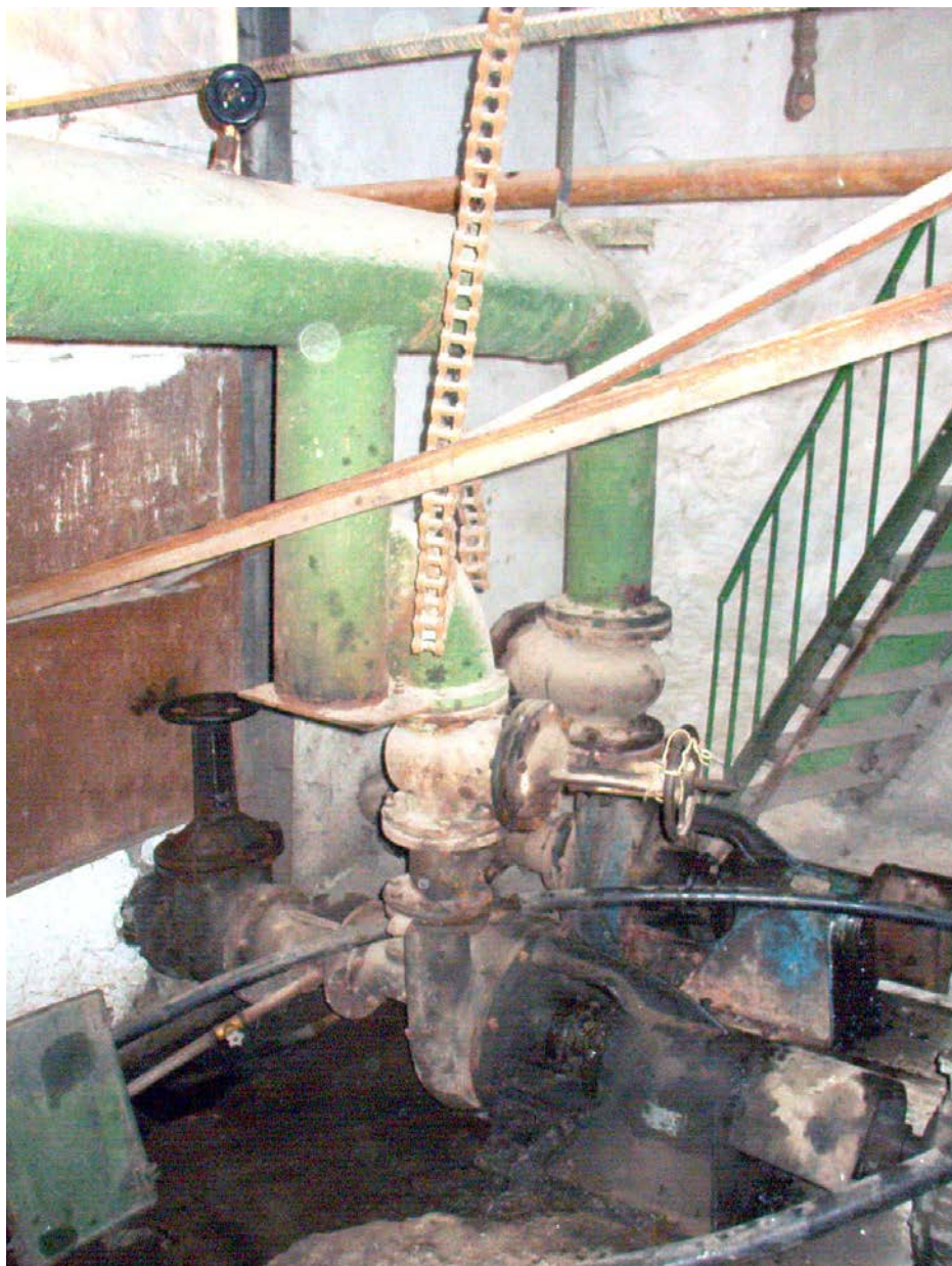
Фото № 11. Насосная станция РКНС до реконструкции
