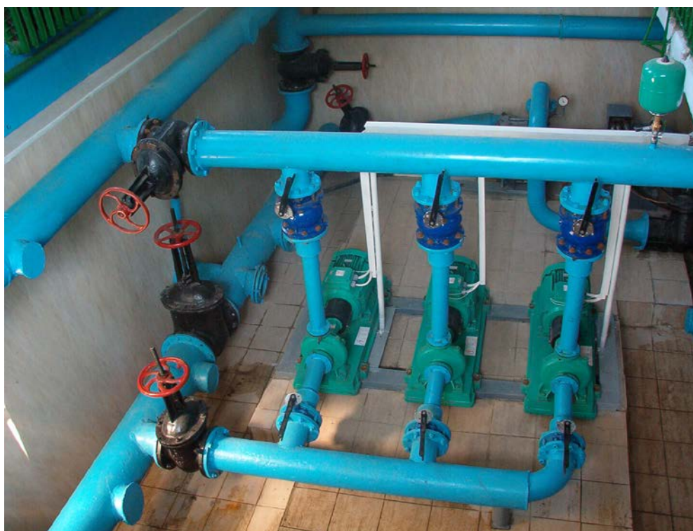
Фото № 10. Насосная станция НС-2 пуск в эксплуатацию
