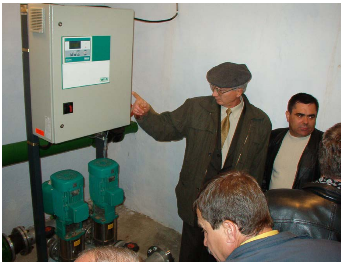
Фото 6. Насосная станция «Крестюк-7» после модернизации.
