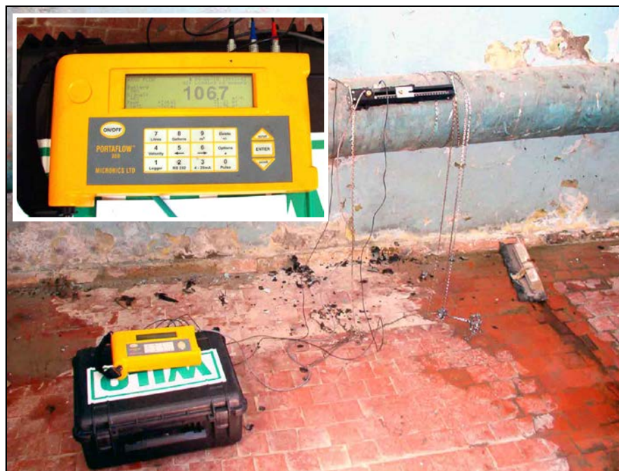
Фото .1. Замеры расхода воды в напорном трубопроводе насосной станции
