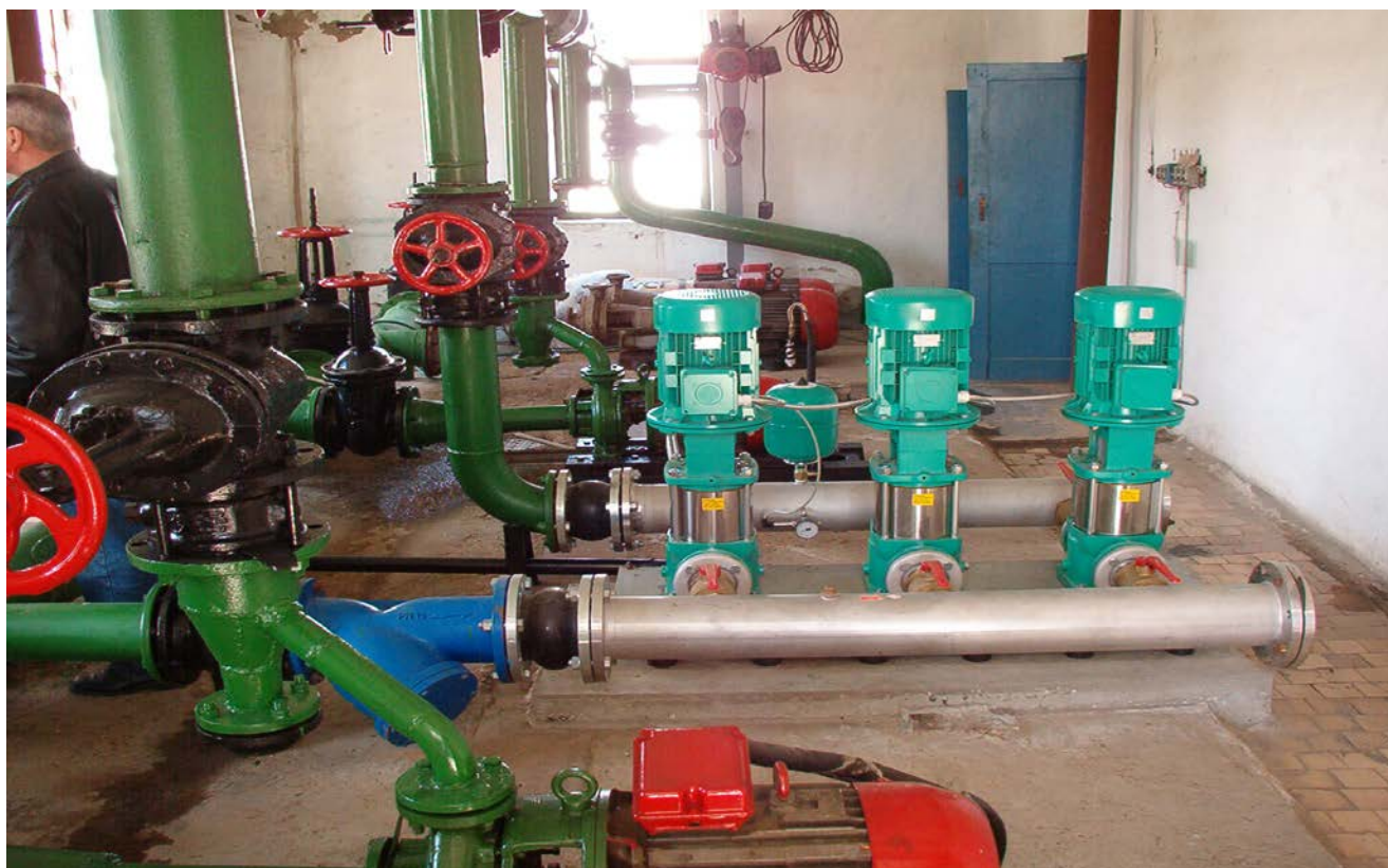
Фото № 8. Насосная станция НС-4 после модернизации
