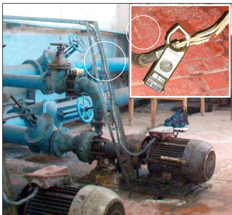
Фото 3. Замеры напряжения и силы тока на электродвигателе насосного агрегата
