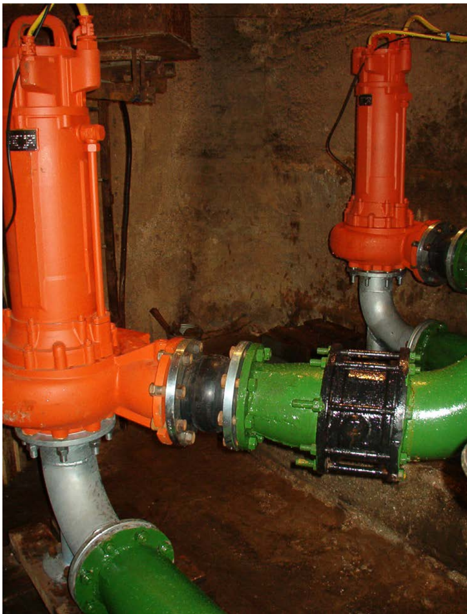
Фото 4. Насосная станция I-го подъема после модернизации
