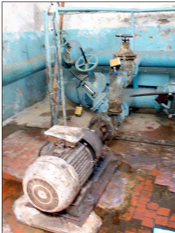
Фото 2. Замеры давления воды в напорном и всасывающем трубопроводе насосной станции
