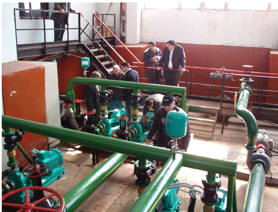
Фото № 7. Насосная станция НС-3 после модернизации
