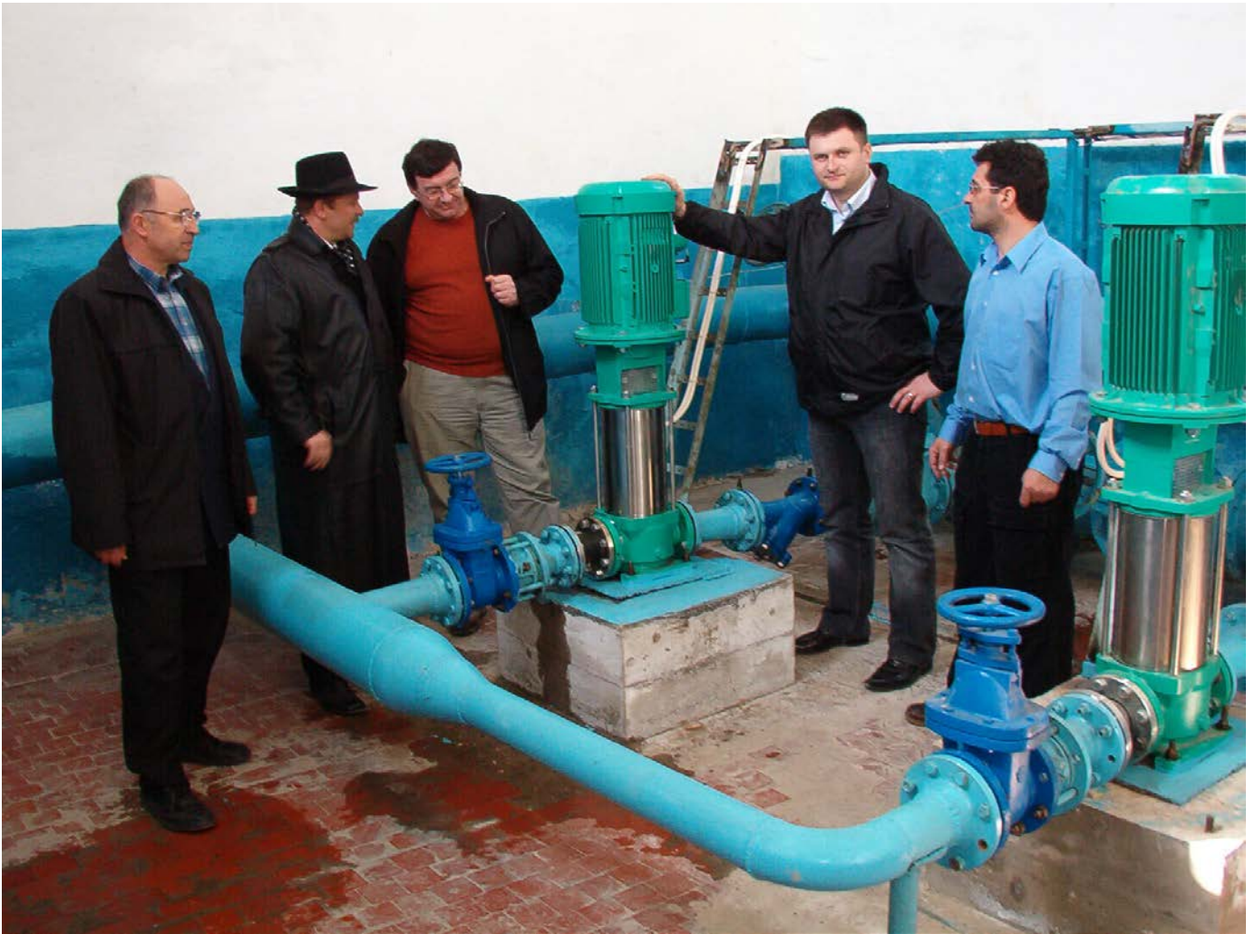
Poza № 9. SP-2 după modernizare (punerea în funcțiune)
