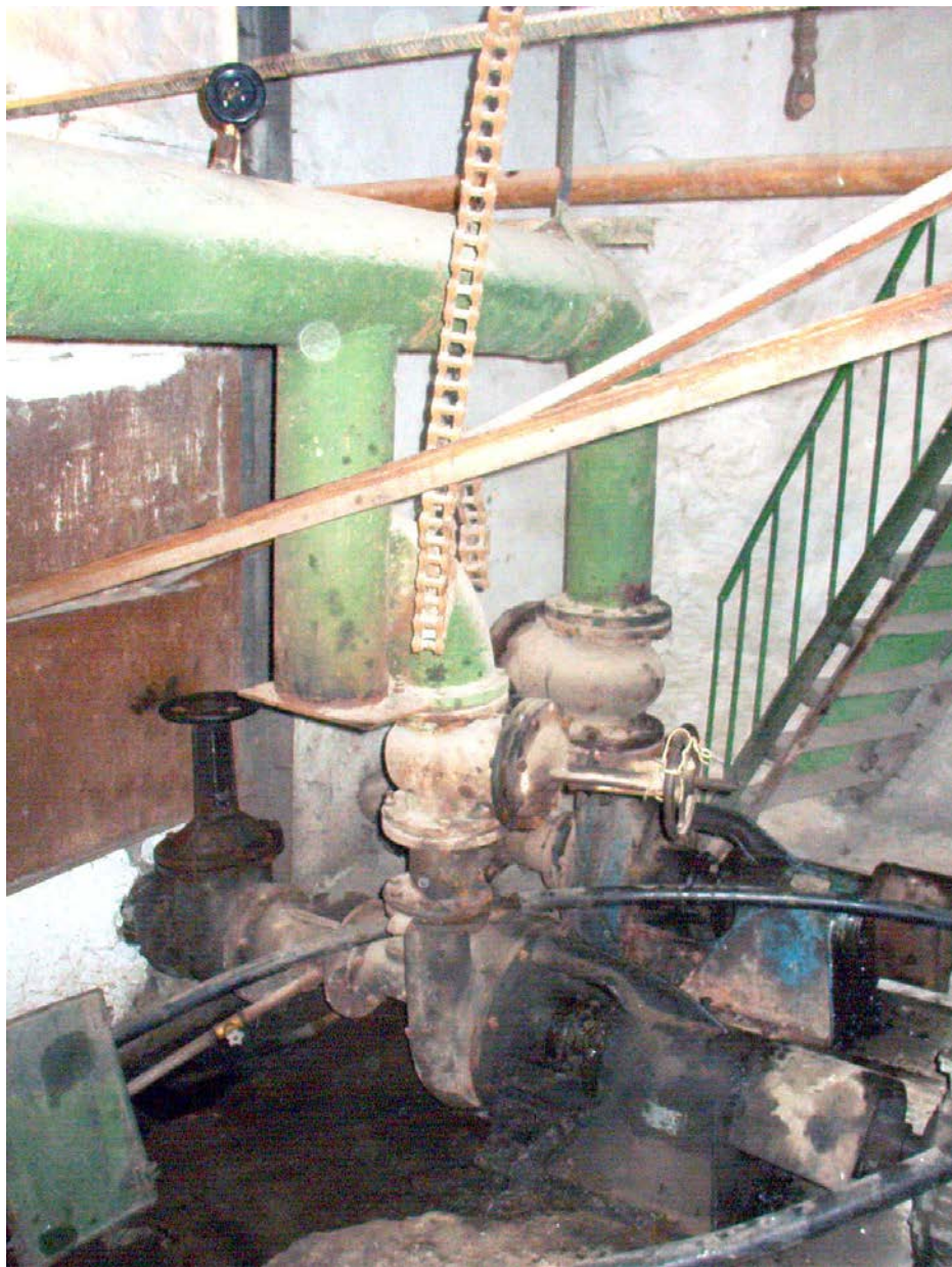
Poza № 11. Stația SPRC pînă la renovare
