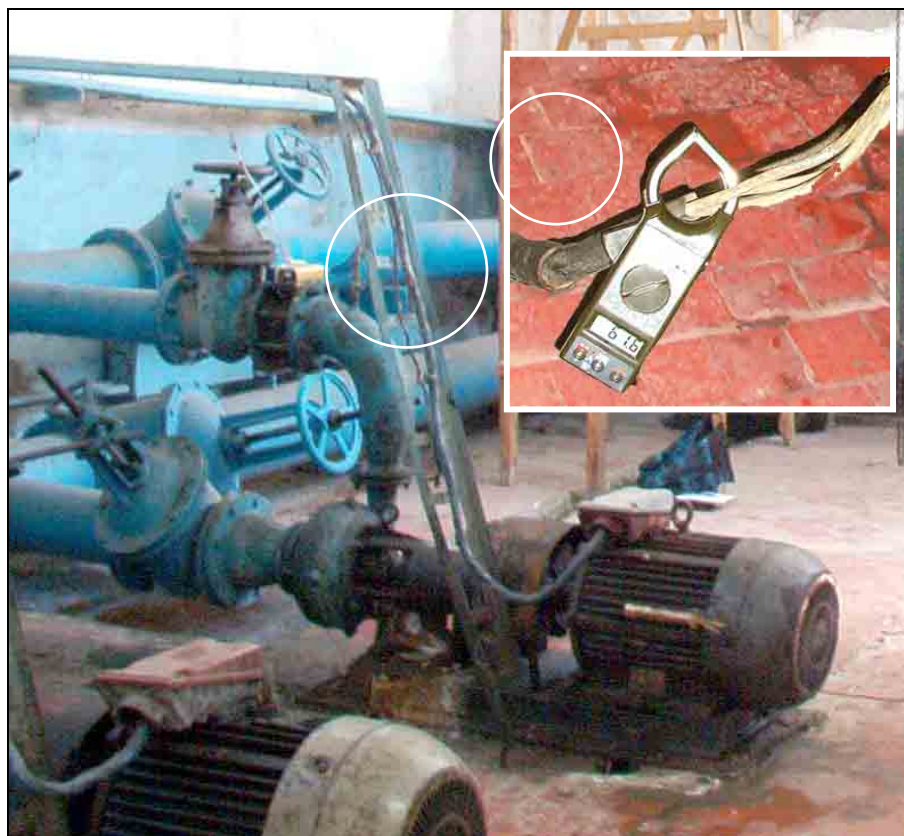
Poza 3. Măsurarea tensiunii și curentului la electromotorul agregatului de pompare
