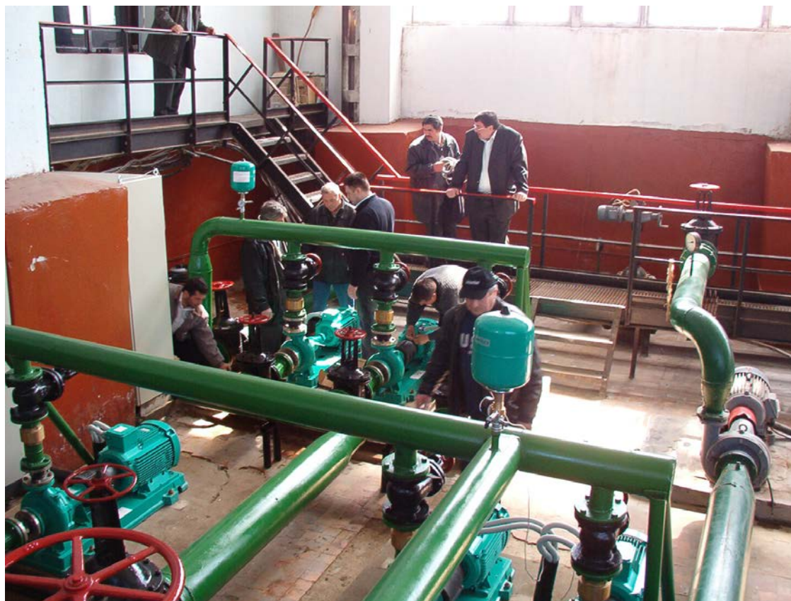
Poza № 7. Stația de pompare SP-3 după modernizare
