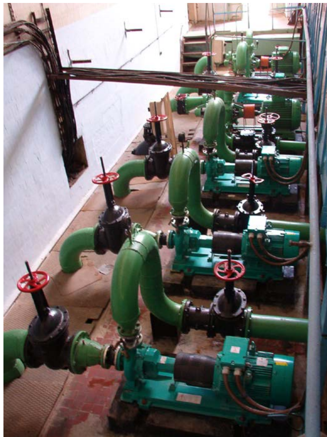
Poza 5. Stația de pompare nr.2 după modernizare
