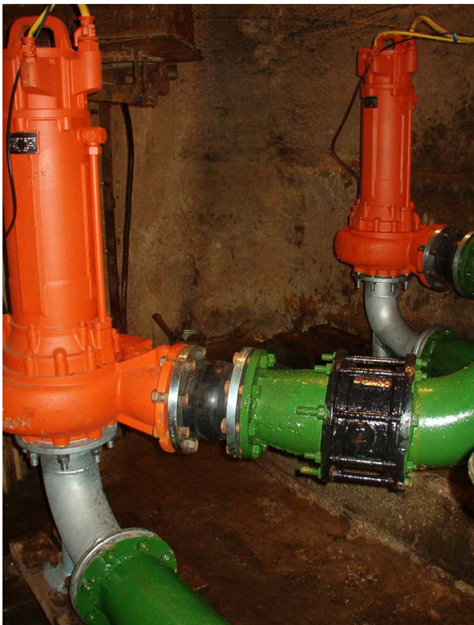
Poza 4. Stația de pompare nr.1 după modernizare
