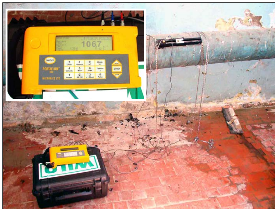
Poza 1. Măsurarea debitului de apă la o țevă de refulare
