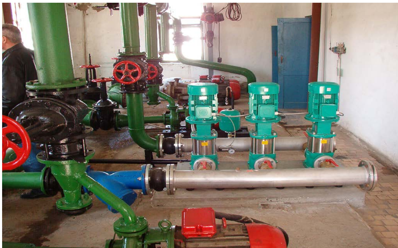
Poza № 8. Stația de pompare SP-4 după modernizare
