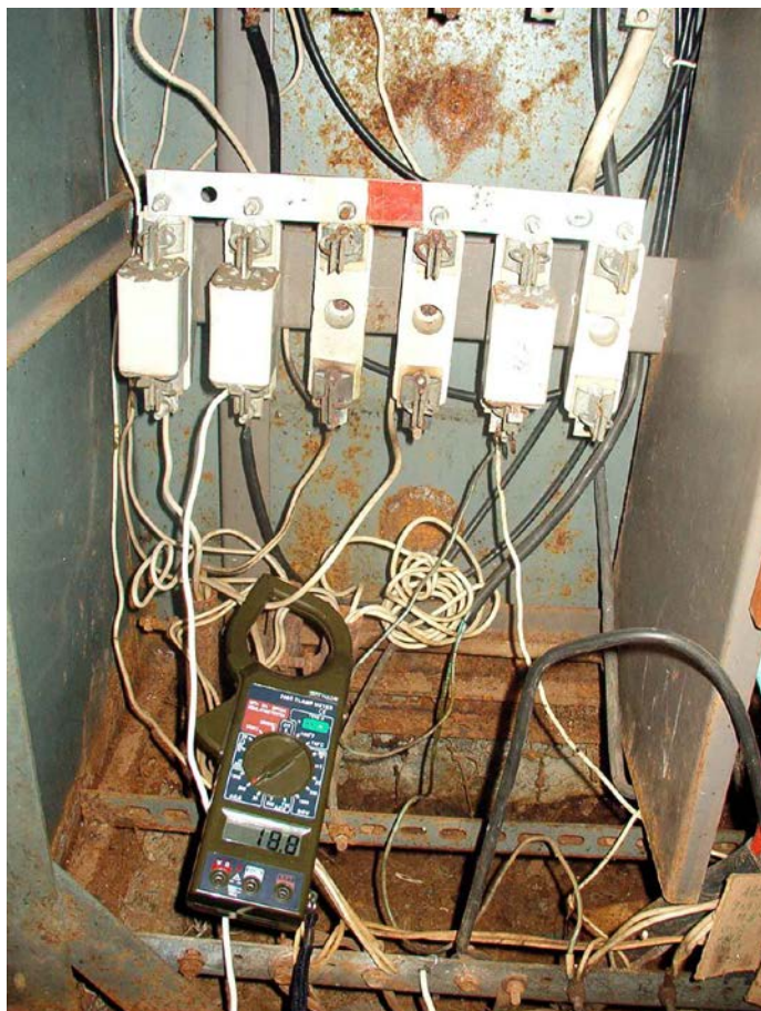
Фото 3. Замеры напряжения и силы тока в распределительном щите насосной станции.
