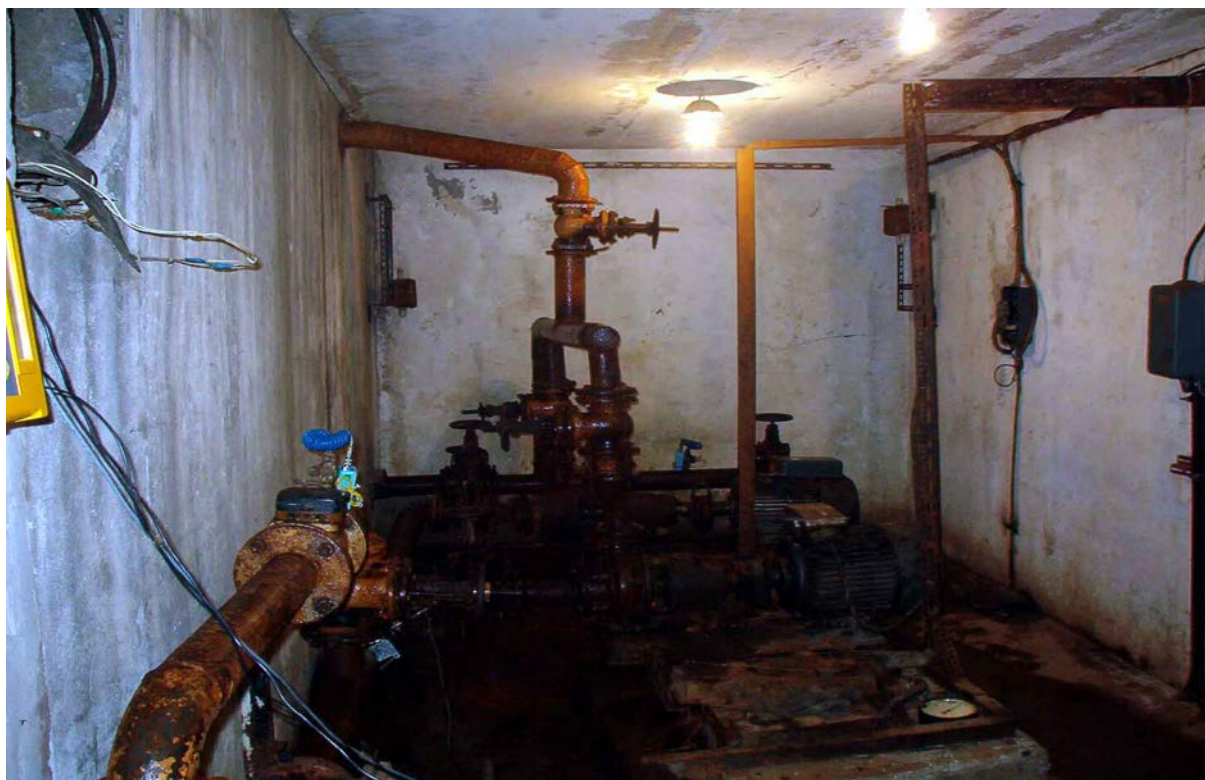
Фото1. Замеры давления и расхода воды в напорном трубопроводе насосной станции.
