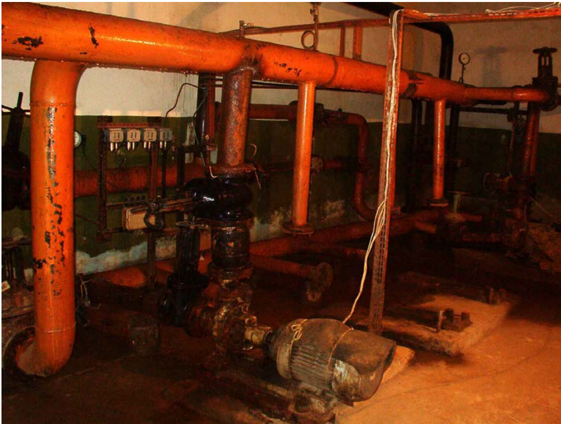
Foto 4. Stația de pompare de ridicare a presiunii str. Zapadnii,19 .
