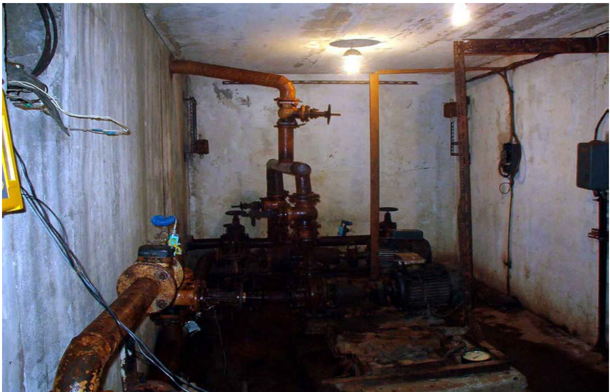
Foto 2.1. Măsurările presiunii și debitului de apă în țeava de refulare stației de pompare .
