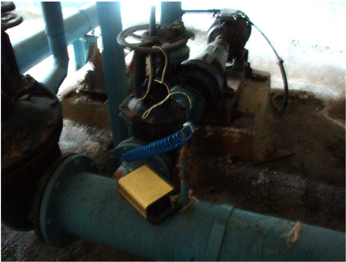
Фото 1.2. Замеры давления в напорном трубопроводе насосной станции.
