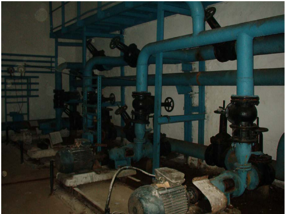
Фото 6 . Повысительная насосная станция Заднипру 2
