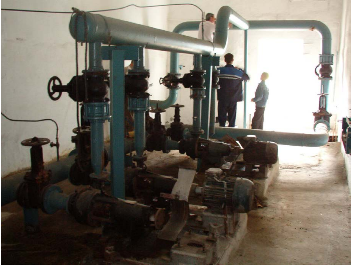
Фото 5 . Повысительная насосная станция Виеру За
