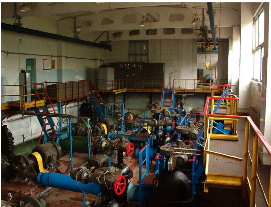
Foto 1 .Stația de pompare raională .
