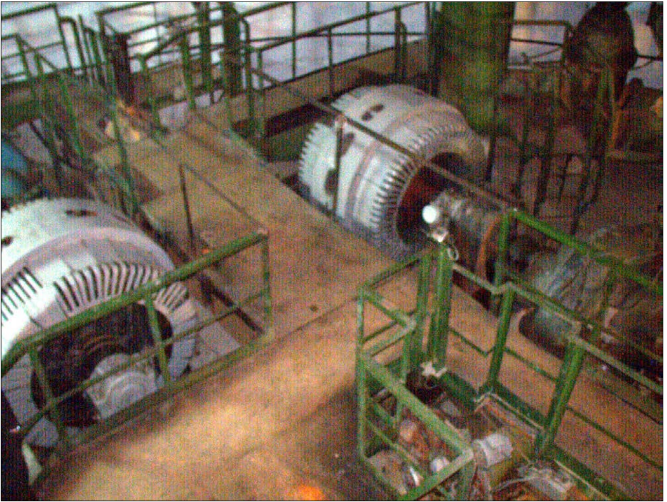
Foto 3.2. Stația de pompare SP-I .
