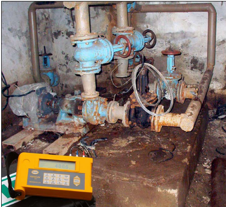
Фото 2.2. Замеры расхода воды в напорном трубопроводе повысительной насосной станции.
