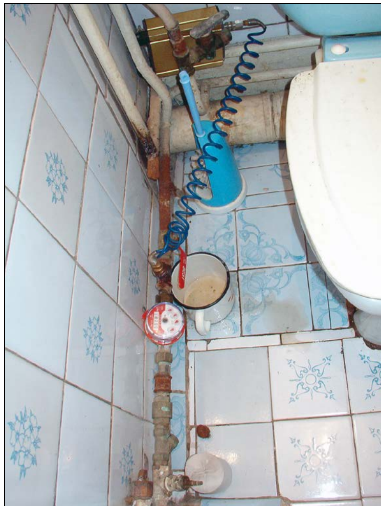
Фото 2.3. Замеры давления воды у потребителя
