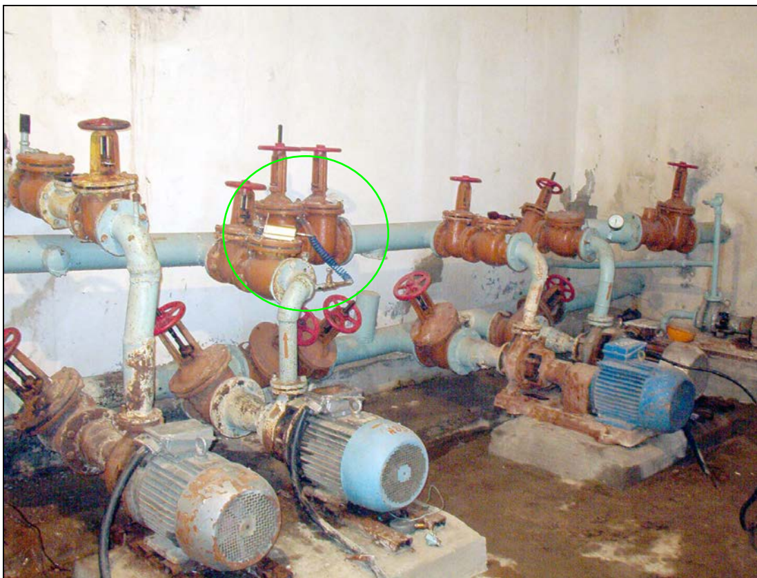
Фото 2.1. Замеры давления воды в напорном трубопроводе насосного агрегата НС-III.
