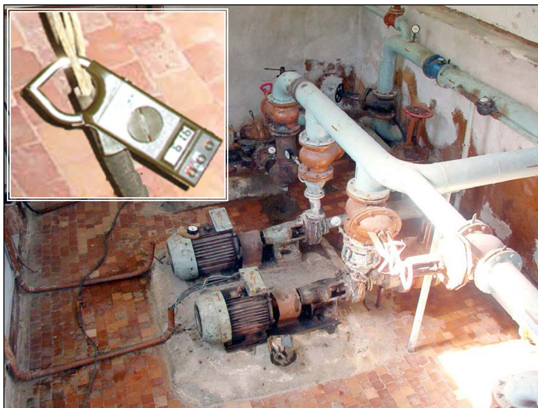
Фото 2.4. Замеры напряжения и силы тока в щите управления насосными агрегатами.
