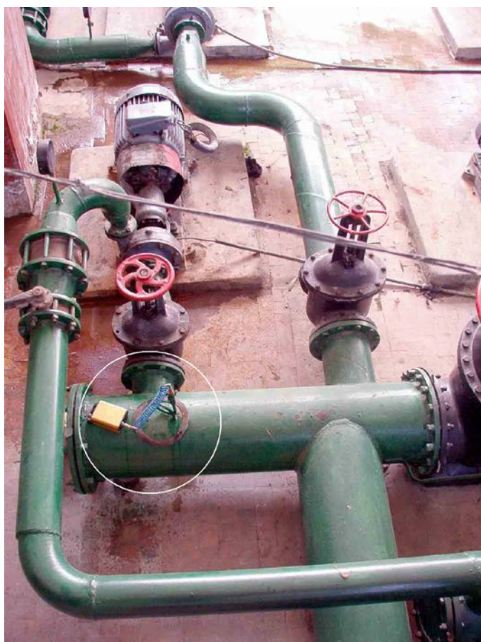
Фото 2.4. Замеры давления в напорном трубопроводе насосной станции.
