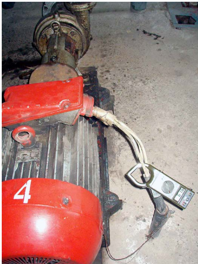
Фото 2.3. Замеры напряжения и силы тока на электродвигателе насосного агрегата.
