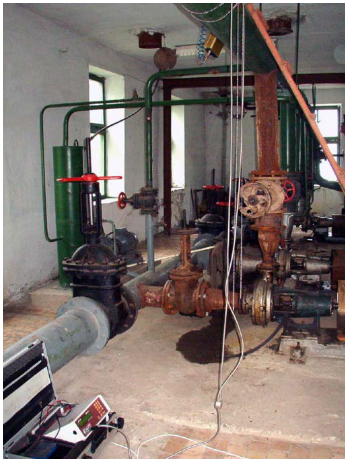
Фото 2.1. Замеры расхода воды в напорном трубопроводе насосной станции.
